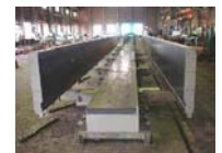
PCa 用型枠（脱型時）
