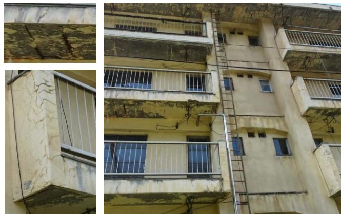
老朽化した集合住宅（ひび割れ, 露筋）
