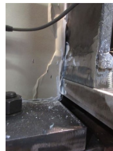
(b) ボードと载荷フレームの接触（面内変形 +0.75\% ）
