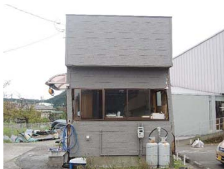
図4 小規模木造建築物の残留変形 1)
