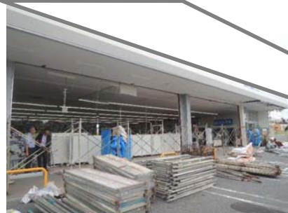
図11 脱落した建具の応急復旧に向けた準備 1)
