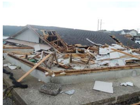
図3 木造倉庫の倒壊 1)
