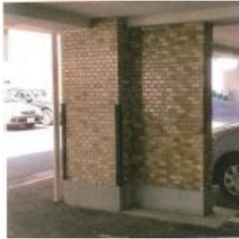
補強壁設置
