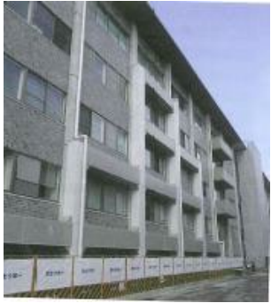
外付けフレーム設置
