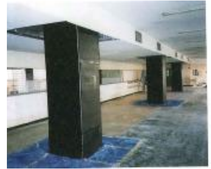
炭素繊維シート巻付け
