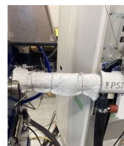
図 2 サンプリング管被覆の様子
