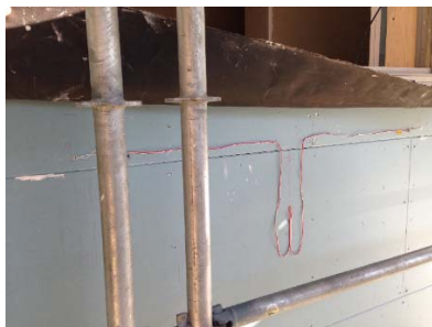
写真5 漏水（結露）センサ（上）とその設置状況（下）
