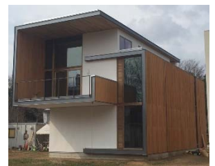
写真 6 CLT パネル工法 2 階建て実験棟
