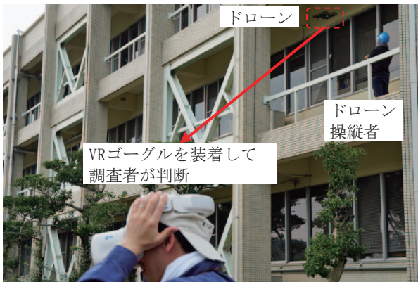
図25 被災建物におけるドローンによる遠隔調査
