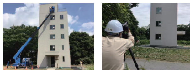
①高所作業(目視点検) ②地上撮影点検(カメラ撮影)
