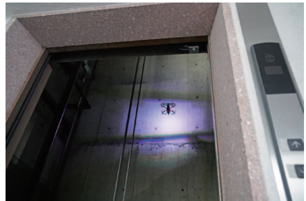
図27 狭所空間（例：エレベーターシャフト）内のドローンによる点検調査
