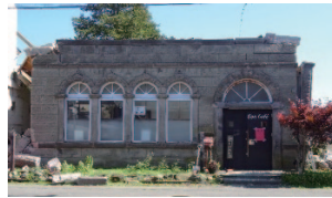
写真 3.3.15 比較的古い組積造の2層の崩壊
