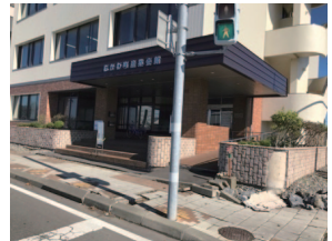
(c) 隣接する産業会館の入り口の被害状況
