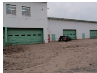
写真 4.27 流出土砂の堆積状況 (約 50~70 cm 堆積)
