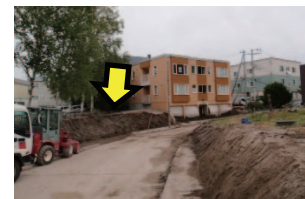
写真 4.25 流出土砂撤去後 (矢印は運送会社事業所の敷地)
