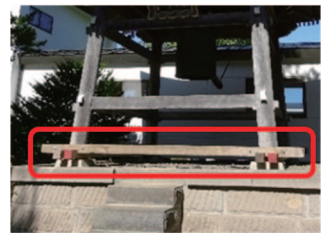
写真 3.3.36 写真 3.3.35 の補強部分
