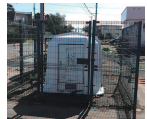
(a) 地震計の設置状況①
