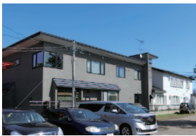
写真 3.2.18 外観上無被害に見受けられる住宅
