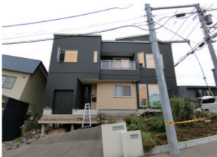
写真 4.20 周囲より建築物全体の傾斜が小さい写真 4.19 の住宅
