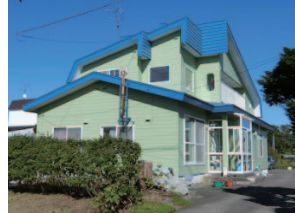
写真 3.3.44 外見上無被害に見受けられる住宅
