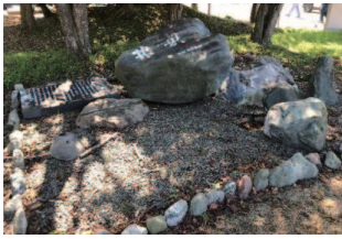
写真 3.2.13 建築物B付近の工作物の破壊状況（上部が東側へ転倒）
