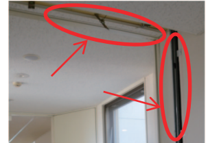
(b) カバーが脱落したエキスパンション・ジョイント
