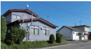
写真 3.3.39 外見上無被害に見受けられる住宅
