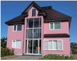
写真 3.3.43 外見上無被害に見受けられる住宅
