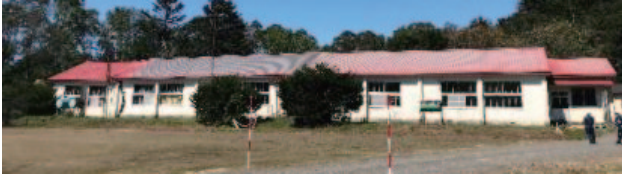
写真 3.2.3 旧小学校の校舎 A 全景
