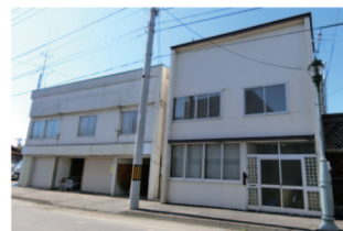
写真 3.3.23 間口に壁の無い木造モルタル2階建て
