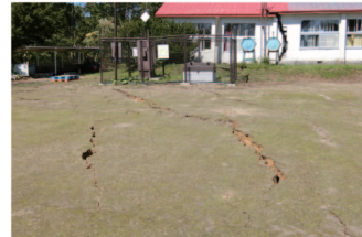
写真 3.2.7 旧小学校の校舎 A 南側の地割れ
