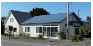
写真 3.3.40 外見上無被害に見受けられる住宅
