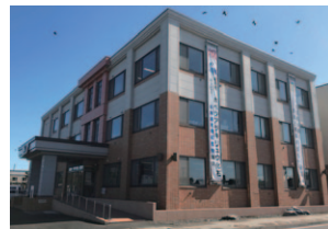
(a) 町役場庁舎の全景
