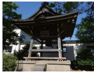
写真 3.3.35 鐘楼の脚部の補強
