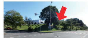
写真 3.3.3 早来町民センターが建つ丘又は造成地 (矢印:地震計設置箇所)
