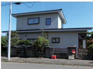
写真 3.3.28 無被害に見受けられる外壁がサイディングの比較的新しい住宅
