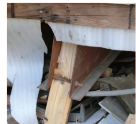
(d) 2階床を支持する鋼材
