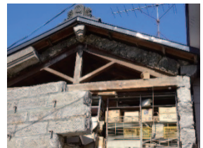
写真 3.3.18 写真 3.3.17 の小屋組
