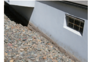
(b) 地中部分の一部が露出した基礎
