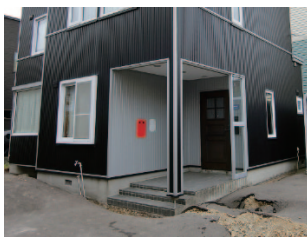
写真 4.17 地盤が隆起・沈降しているにもかかわらず、ほぼ無被害に見える基礎
