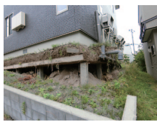
写真 4.18 杭 (角形) 状地盤補強を講じたと思われる住宅の基礎
