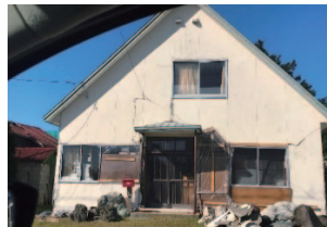
写真 3.3.37 外壁の剥落
