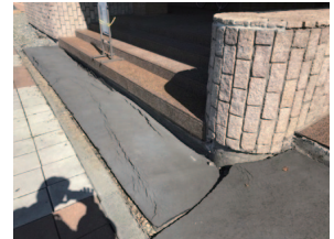
(d) 隣接する産業会館の入り口付近の舗装の被害
