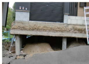
写真 4.19 杭 (円形) 状地盤補強を講じたと思われる住宅の基礎
