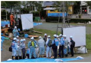
写真 4.11 ボーリング作業と調査団
