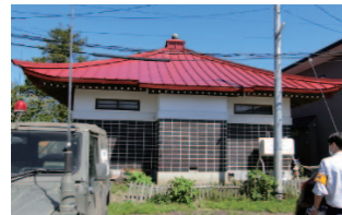
写真 3.2.19 外観上無被害に見受けられる寺社建築
