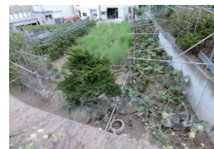
写真 4.34 東側の低い敷地へ流出した土砂
