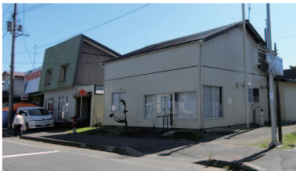
写真 3.2.20 外観上無被害に見受けられる店舗又は店舗併用住宅
