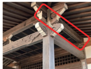
写真 3.3.34 写真 3.3.33 の補強部分
