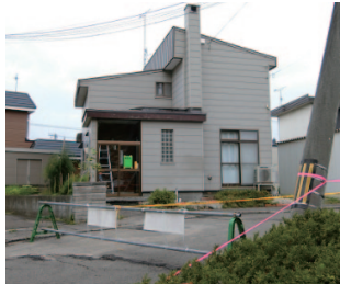
写真 4.15 写真 4.3 の住宅の 2 軒南側でほぼ無被害の住宅
