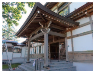
写真 3.3.33 社寺建築の玄関部分の補強
