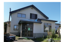
写真 3.1.17 中央通り沿いでほぼ無被害のように見受けられる専用住宅
