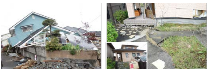
倒壊した建築物 状況確認が困難
