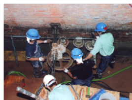
切断機の設置作業
