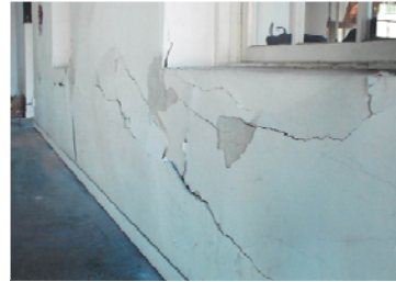
内壁モルタル塗の破損状況(修理前)
