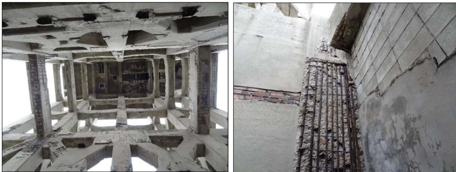
重要文化財 旧志免鋳業所竪坑櫓 (福岡県、鉄筋コンクリート造、1943年)
