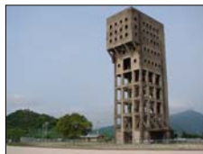
旧志免鉱業所竪坑槽
