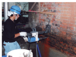
ワイヤーソー挿入口削孔
