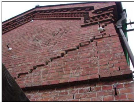
指定外の某煉瓦造建物 (茨城県、煉瓦造、1892年)
