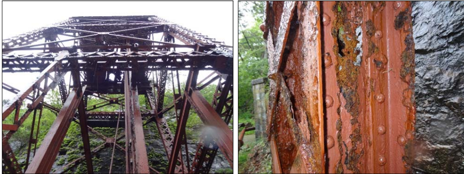
重要文化財 旧佐渡鉱山採鉱施設 大立竪坑櫓 (新潟県、鉄骨造、1940年)
