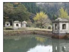
旧美敷水源地水道施設
