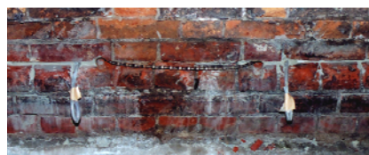
第一工程の注入完了と第二工程の目地材切除作業の準備
