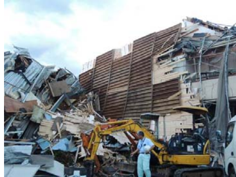
上部構造全体が飛散し、近隣の住家に衝突した事例(越谷市)
