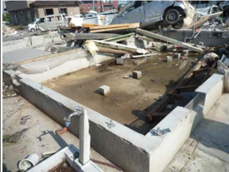
一部の土台が残存しているものの、ほとんどの上部構造が飛散した事例(つくば市)
