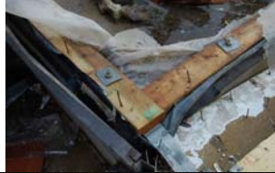
一部の土台が残存しているものの、ほとんどの上部構造が飛散した事例(つくば市)
