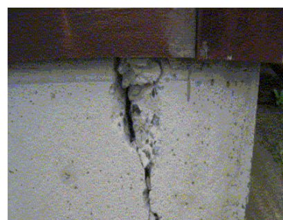
写真19 コンクリート基礎の被害
