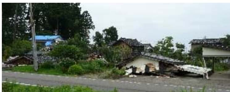
写真7 軒並み倒壊した倉庫・車庫
