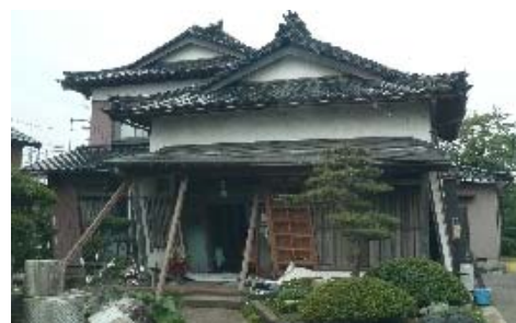
写真6 比較的古い構法による木造家屋の被害
