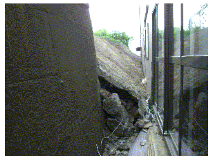
写真20 番神町における擁壁の被害状況
