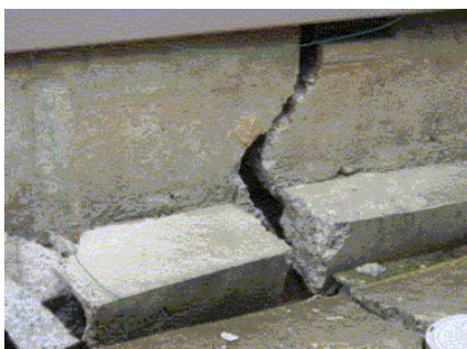
写真19 コンクリート基礎の被害
