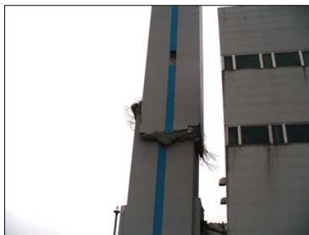
写真10 煙突の北側面
