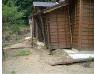
写真21 液状化に伴う住宅背面崖の地盤変動により下方から突き上げられた住宅
