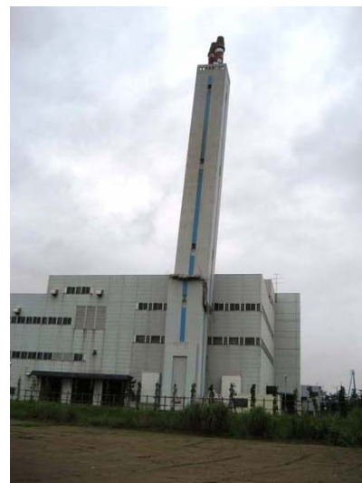
写真9 塔状工作物(自立型煙突)の全景
