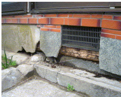
写真18 ブロック基礎の被害例
