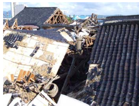
写真11 煙突と木造工場
