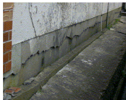
写真18 ブロック基礎の被害例
