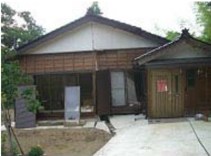
写真21 液状化に伴う住宅背面崖の地盤変動により下方から突き上げられた住宅
