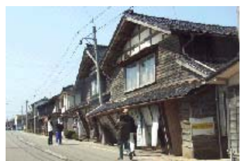
写真4 家屋の残留変形が目立った道下地区
