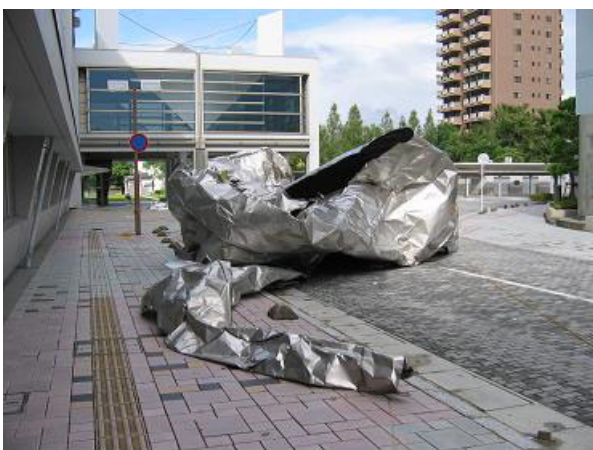
写真 4 落下した屋根ふき材(飯塚市教育文化振興事業団 提供)
