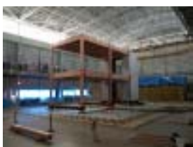
写真 4, 木質フレームとRCコアの実大振動実験
