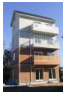
写真 9, 桝組壁工法による4階建建物
