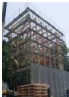
写真 8, 1階RC・2～5階ハイブリッド部材の実施例
