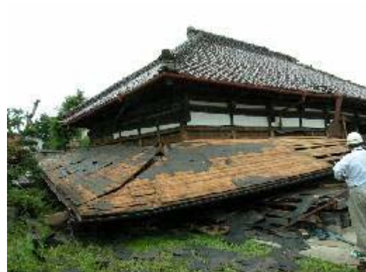
写真1 農家型住宅の被害(1階部分の崩壊)
