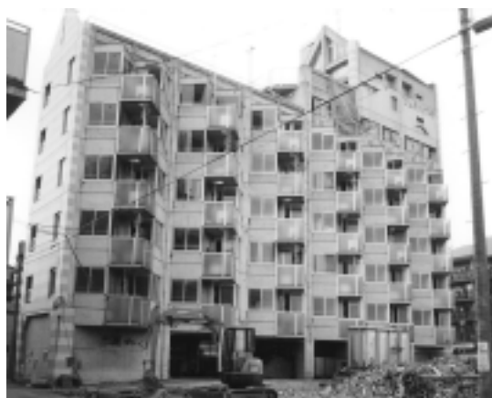
(a) 建物全体（構造は鉄筋コンクリート造剛節架構）
