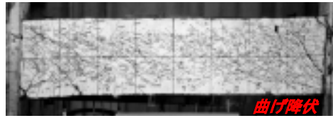
左と同じ配筋で、高靱性コンクリートを用いた梁： 破壊は防止されており、損傷もずっと小さい
