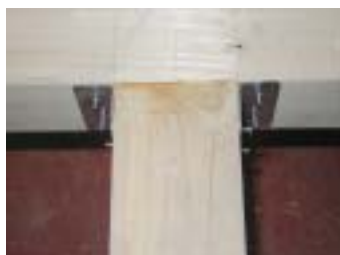
写真1 根太受け金物の接合部にダブルヘッド釘使用
