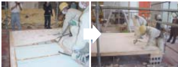
写真6 床下地合板の撤去 (右:改良型)
