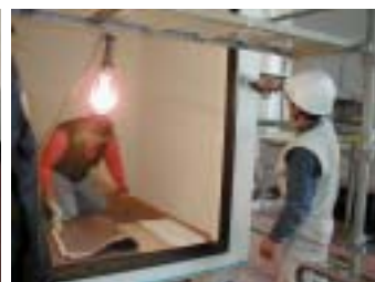
写真2 珪藻土成型板とカーペットの施工
