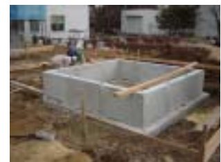
写真8 リユース基礎の施工風景
