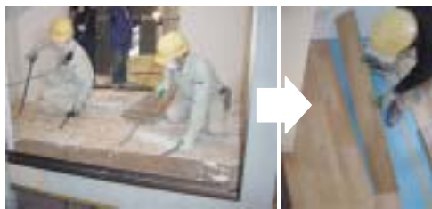
写真5 フローリングの撤去 (右:改良型)
