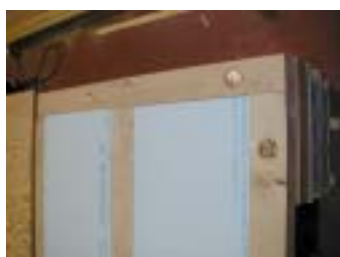
写真3 404材と実合板による床組の施工
