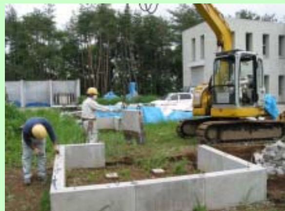
プレハブ基礎の解体
