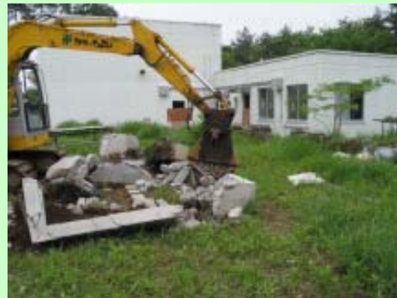
従来の基礎(解体)
