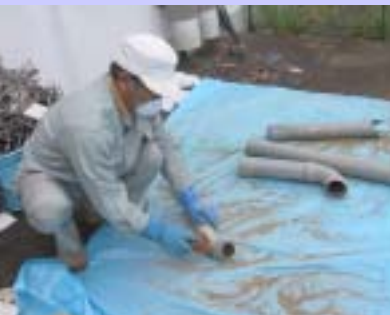
塩ビ管の汚れ拭き取り作業
