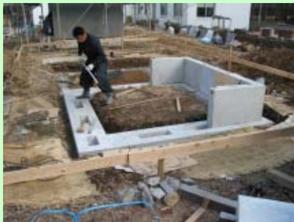
プレハブ基礎の施工
