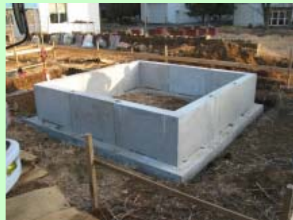
プレハブ基礎の施工完了
