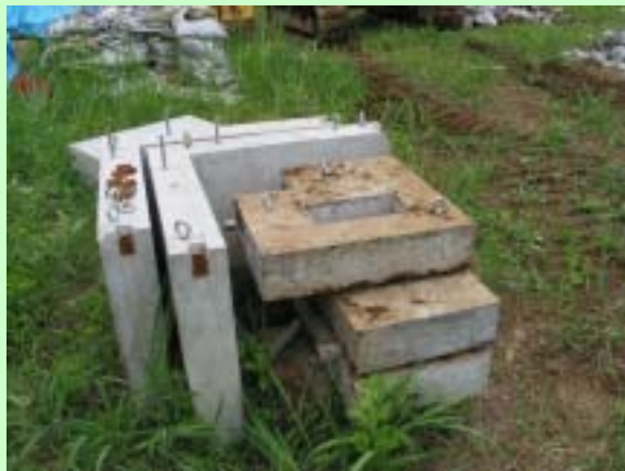
解体されたプレハブ基礎
