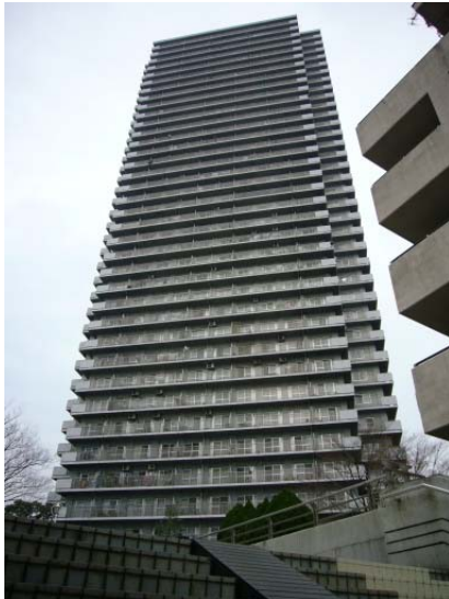
写真 1 佃タワー外観
