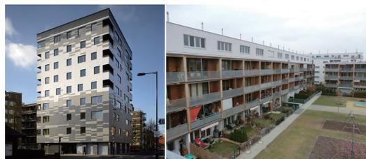
欧米で建設されている中層・大規模木造建築物。日本では、時刻歴応答解析、限界耐力計算など高度な構造計算が要求される。
