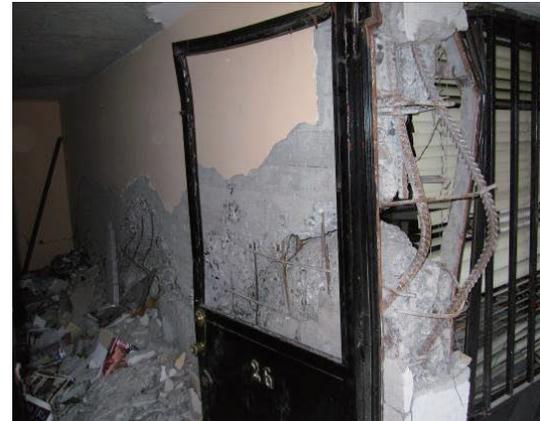
図 1 柱型を省略した連層耐力壁の被害（2010 年チリ地震）
