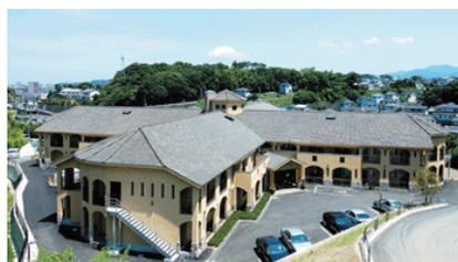
2 × 4 工法による耐火構造でつくられた大規模木造建築物。防火規定により木造には厳しい制限があり、高い耐火性能が要求される。
