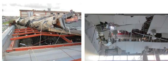
図3 鉄骨造の文教関連施設の屋根ふき材と天井材の被害
