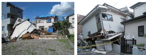
図4 木造住家の上部構造の倒壊
