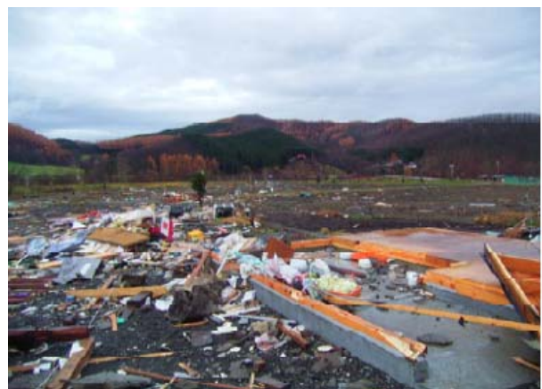
平成 18 年台風 13 号被害調査
