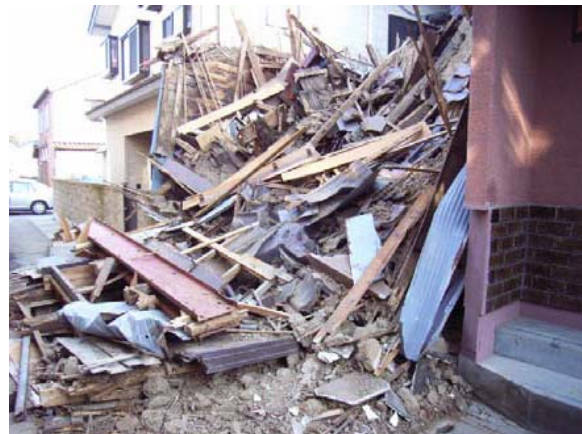
平成 19 年能登半島地震被害調査
