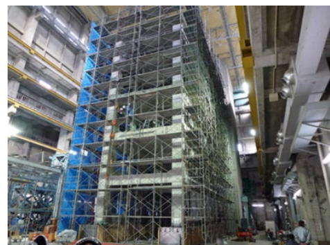
実大構造物実験棟での 構造安全性に関する実験
