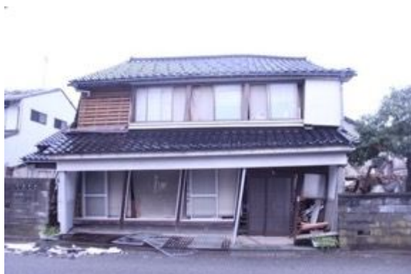
写真 6.7.9 大きく傾斜した木造住宅
