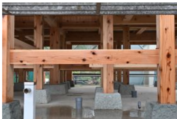
写真 6.7.4 写真 6.7.3 の束と礎石部分
