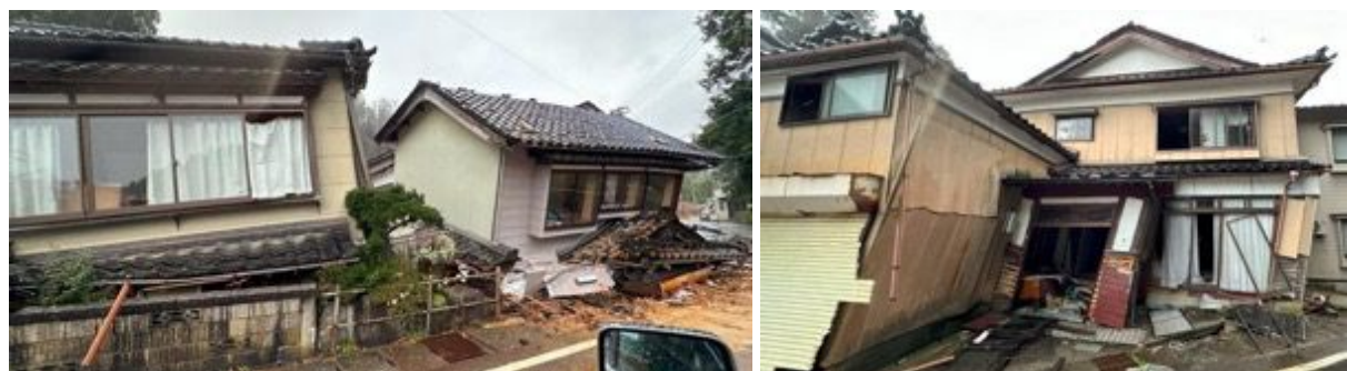
写真 6.3.2 珠洲市役所前以外で倒壊を含む大きな被害を受けた家屋（珠洲市上戸町）
