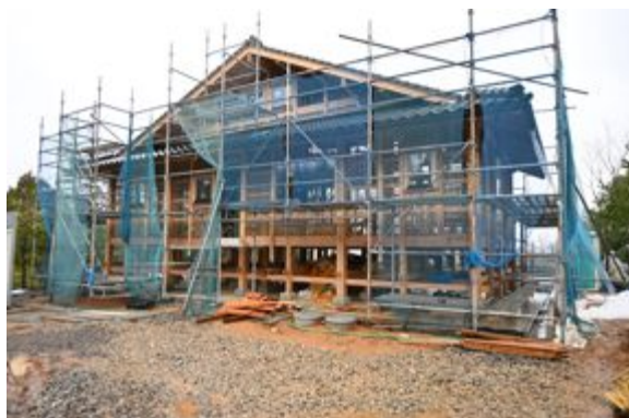
写真 6.7.3 建設中の石場建て木造住宅
