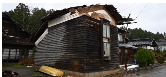
写真 6.7.6 土蔵の被害
