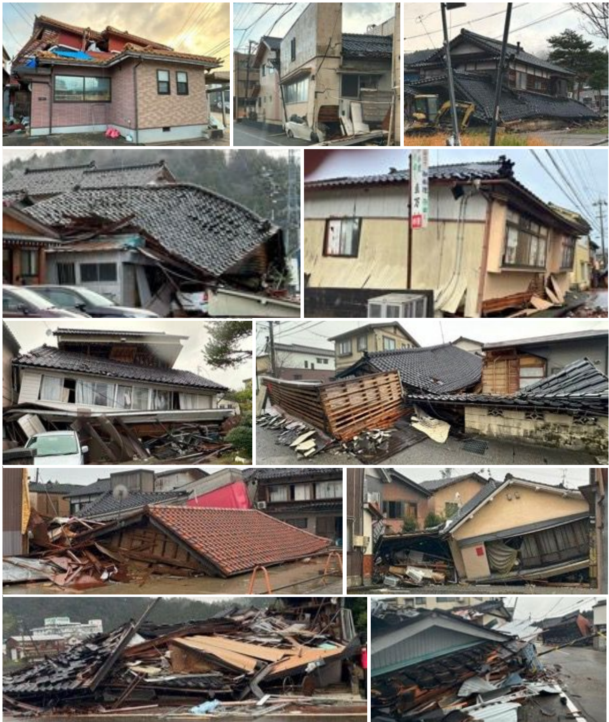
写真 6.4.7 穴水町大町の倒壊家屋群
