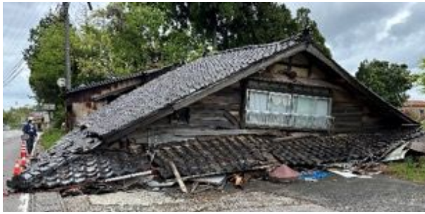
写真 6.3.14 珠洲市三崎町二本松で2023年地震時に倒壊した家屋 2) (2023年5月撮影)
