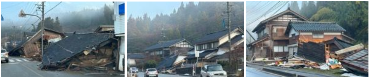
写真 6.1.12 輪島市三井町で確認された倒壊家屋
