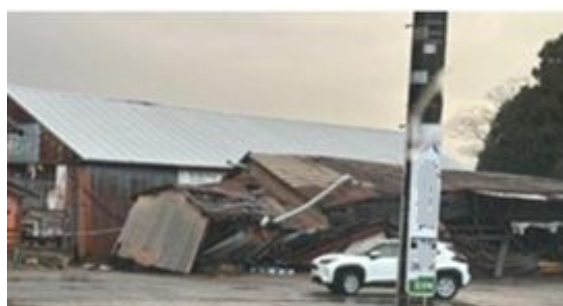
写真 6.4.4 穴水町川島の工場社屋の倒壊
