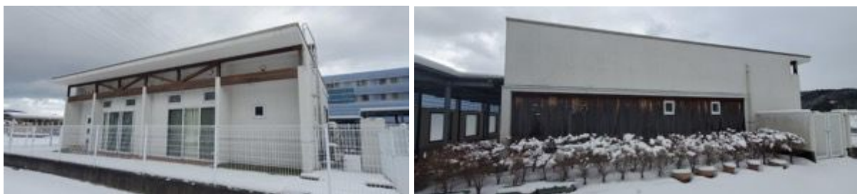
写真 6.8.6 輪島市の教育施設 F (2013 年竣工)
