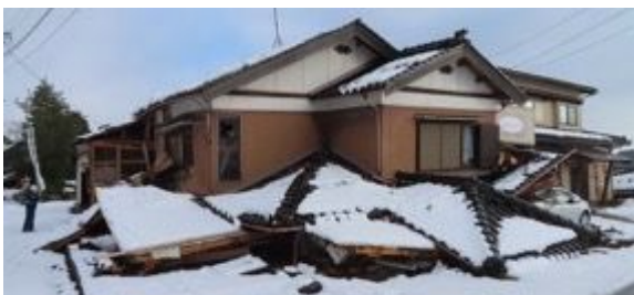
写真 6.3.23 1層が崩壊した木造住宅
