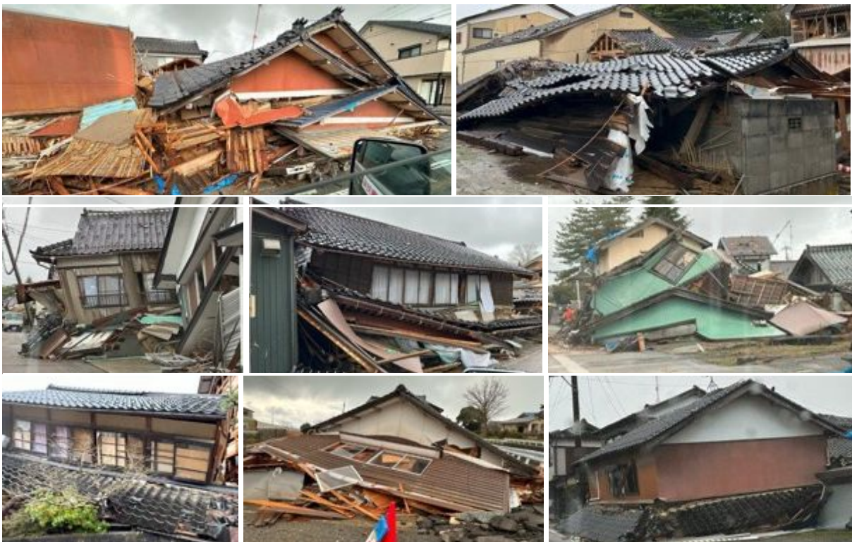
写真 6.3.6 珠洲市正院町正院で倒壊した木造家屋
