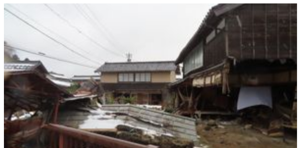
写真 6.6.6 津波により倒壊した木造住宅
