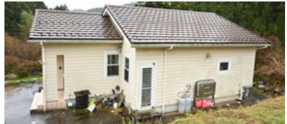
写真 6.9.2 七尾市能登島曲町の平家の枠組壁工法住宅 (2003 年竣工)
