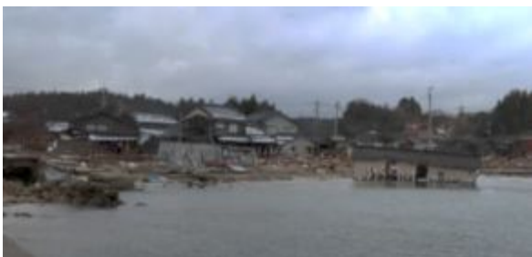
写真 6.6.3 津波により湾に流出した木造住宅
