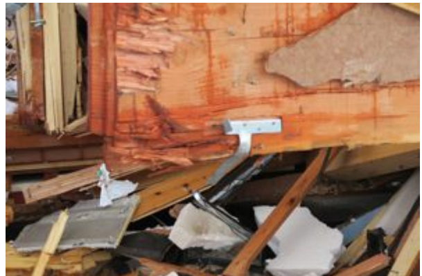
写真 6.3.22 写真 6.3.19 のかど金物 (T型)
