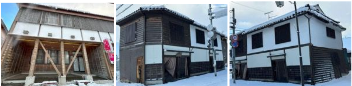
写真 6.2.3 無被害、又は被害軽微と見受けられる比較的新しい木造家屋（門前町門前）
