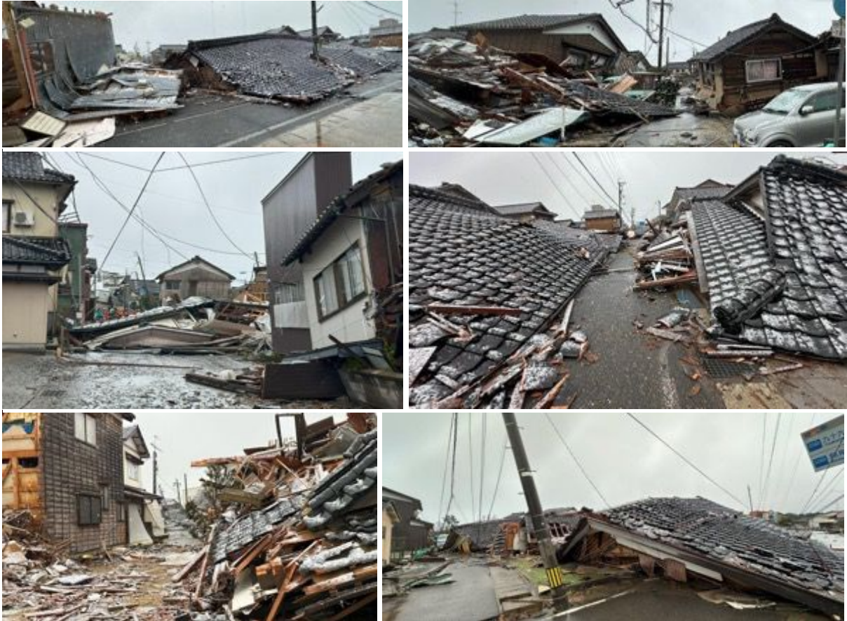
写真 6.3.11 各所に見られた倒壊家屋による道路閉塞（珠洲市宝立町鶴飼）
