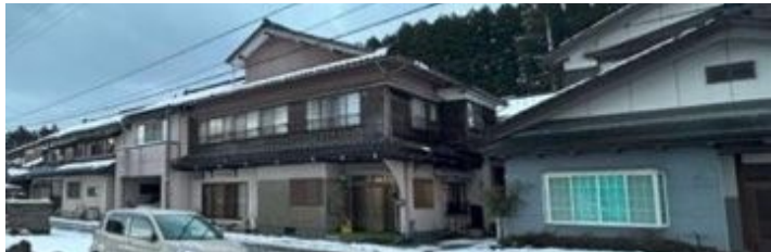
写真 6.5.3 外観上無被害に見える木造家屋
