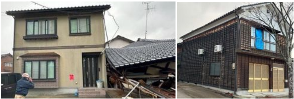
写真 6.4.9 築年数が浅い外観上無被害の家屋 (左の住宅は隣家の倒壊のため応急危険度「危険」判定)
