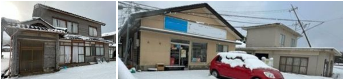
写真 6.2.11 建築年が古い割に被害が軽微の家屋（右の写真の右側の建物はコンクリート造）
