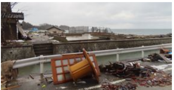
写真 6.6.5 津波により流失した木造住宅 2
