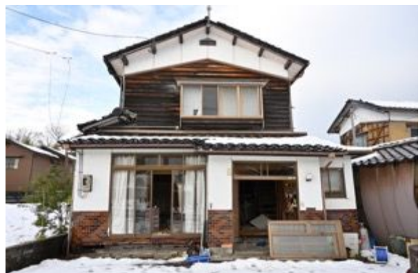
写真 6.3.26 比較的健全な木造住宅
