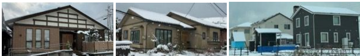
写真 6.2.10 外観上無被害に見える築年数の浅い家屋（門前町道下・館）
