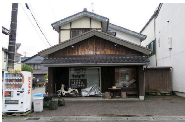
写真 6.7.10 外観上無被害の木造店舗併用住宅
