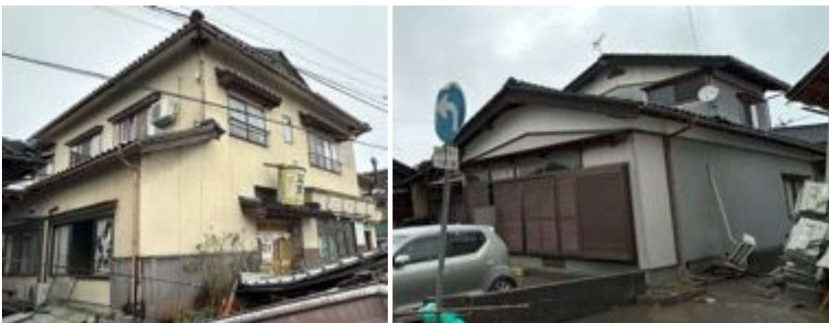
写真 6.3.13 比較的建築年が古い割に被害が軽微な木造家屋
