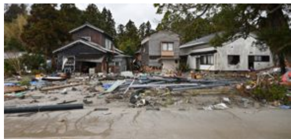
写真 6.6.4 津波により流失した木造住宅 1
