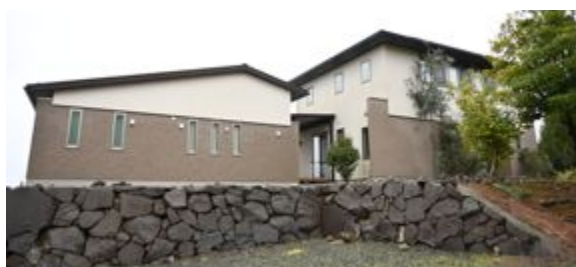
写真 6.7.5 外観上無被害の木造住宅
