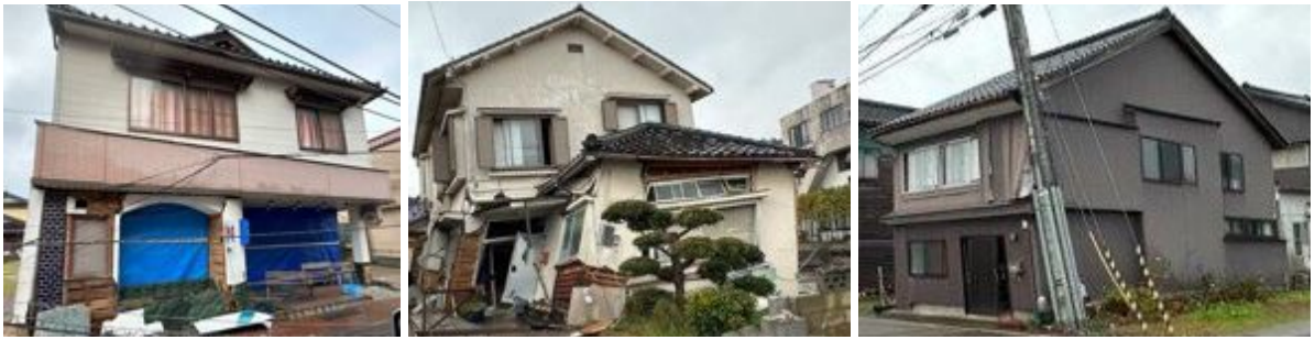
写真 6.3.3 一部は安全限界変形を超えるような大きな残留変形のある木造家屋（珠洲市飯田町）
