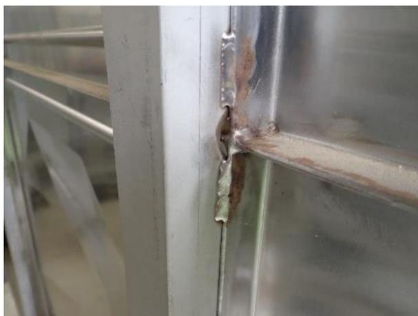
(c) SUS パネル接合部の補修状況
