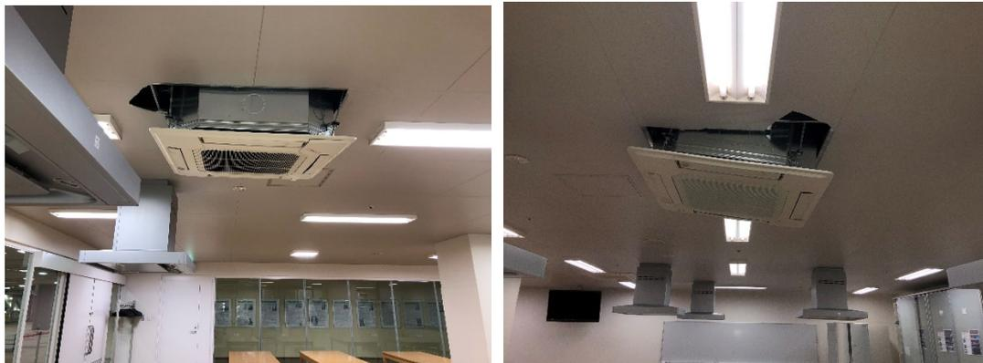
図 4.18.5 空調設備機器の脱落（建築物 R）
