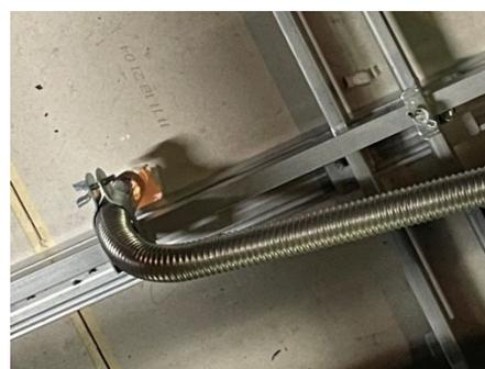
(b)スプリンクラーヘッド付近の天井損傷
