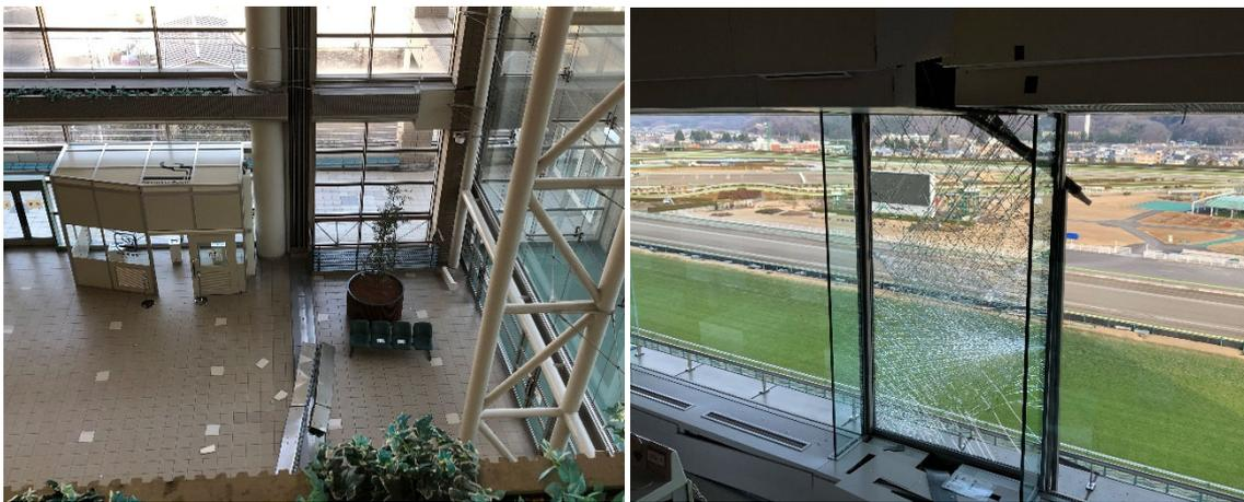
(a) 吹き抜け天井部分の Exp.J カバー破損
