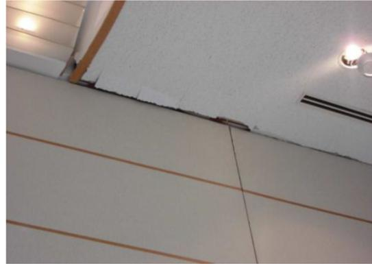
(d) 可動間仕切りレール部の破損
