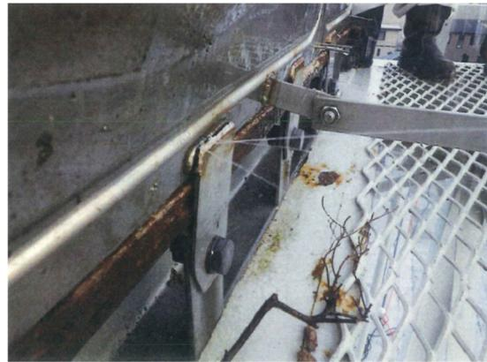
(d) 下部タンク止め溶接部からの漏水
