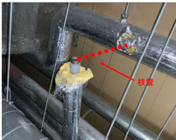
(a) 配管破断の状況
