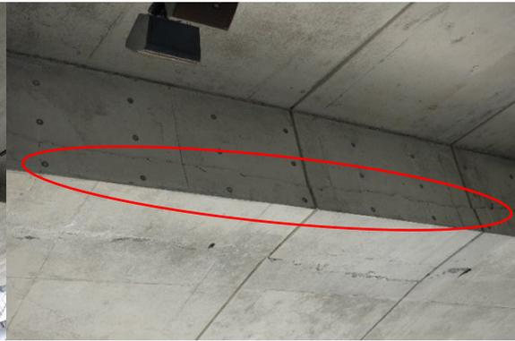
(b) 撓んだ床側面の水平ひび割れ
