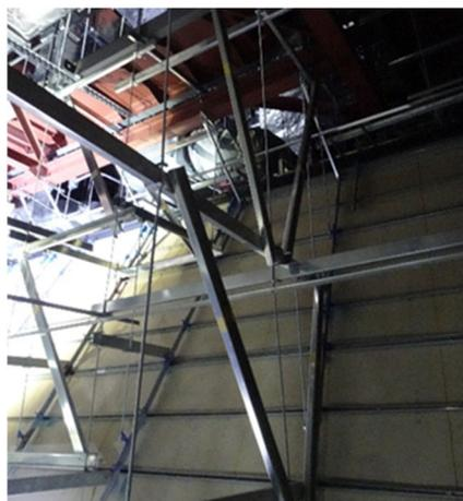
(b) 補強された天井裏の斜材
