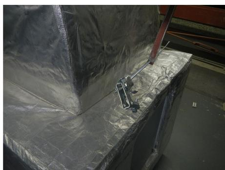
(d) リップ溝形鋼用支持金具の脱落
