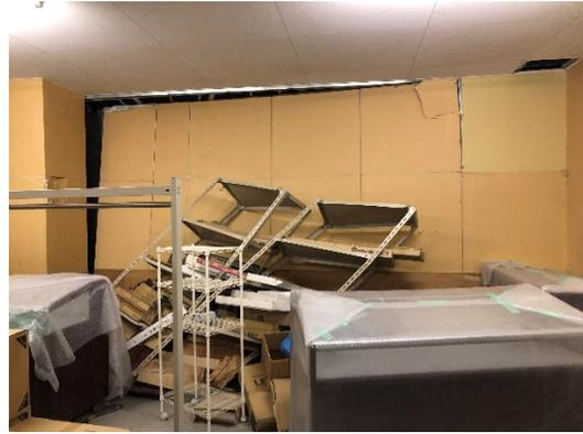
(b) 非構造壁（天井勝ち）の損傷
