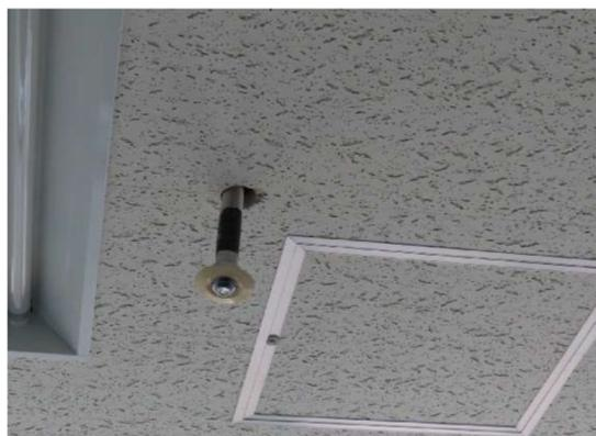
(b) スプリンクラーの破損
