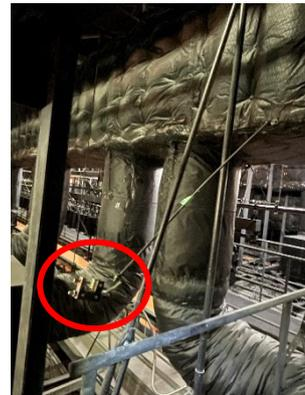
(d)ダクト振れ止めクランプの脱落(2)
