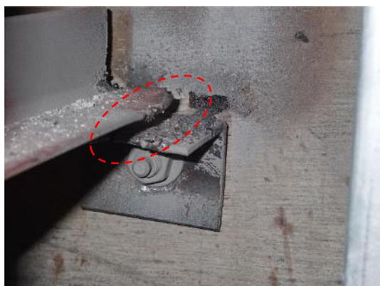
(b) 取り付け部分の溶接破断
