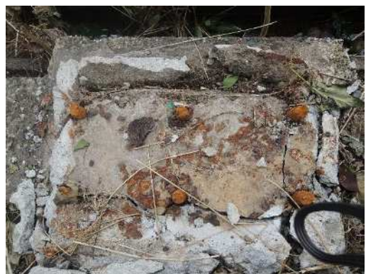
写真 3.9 柱脚ベースプレートの設置跡
