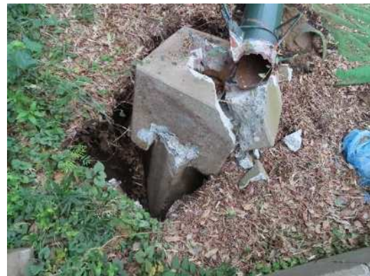
写真 3.27 柱脚の折損
