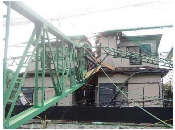
写真 3.11 近隣の住宅の被害(1)
