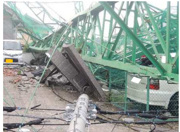
写真 3.13 ブロック塀、電柱、乗用車の被害
