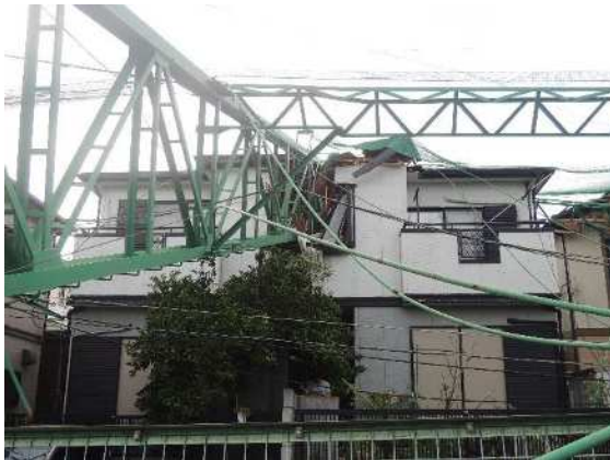
写真 3.12 近隣の住宅の被害(2)
