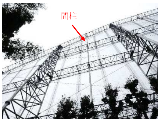
写真 3.28 無被害の鉄柱と間柱
