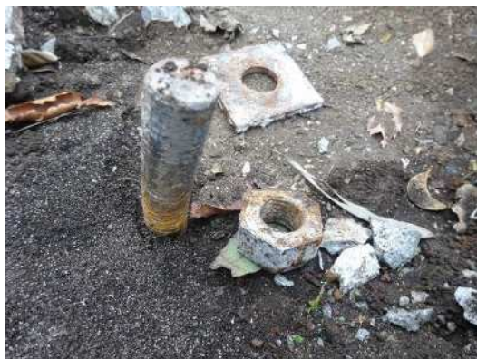
写真 3.20 発錆していないアンカーボルト
