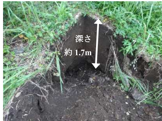
写真 3.25 柱脚の埋め込み跡
