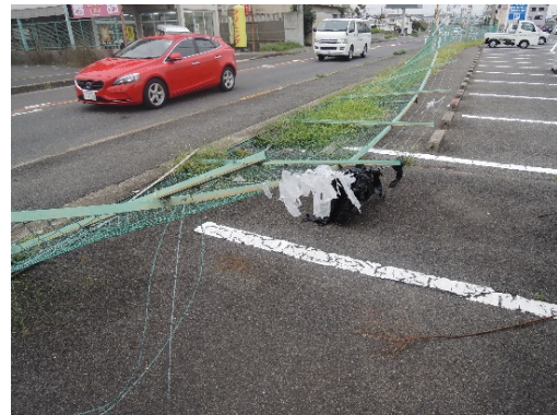
写真 4.49 フェンスの著しい変形
