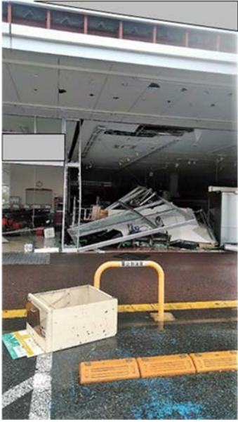
写真 4.36 南東に面する建具の脱落・ 屋内への転倒(当該店舗提供)
