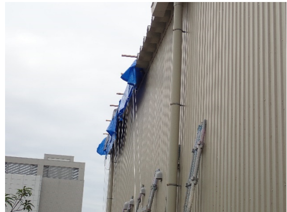
写真 4.11 鋼板製屋根材のブルーシートによる養生
