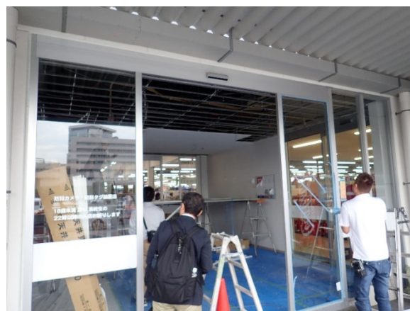
写真 4.14 店舗入口での修復中の天井と自動ドア
