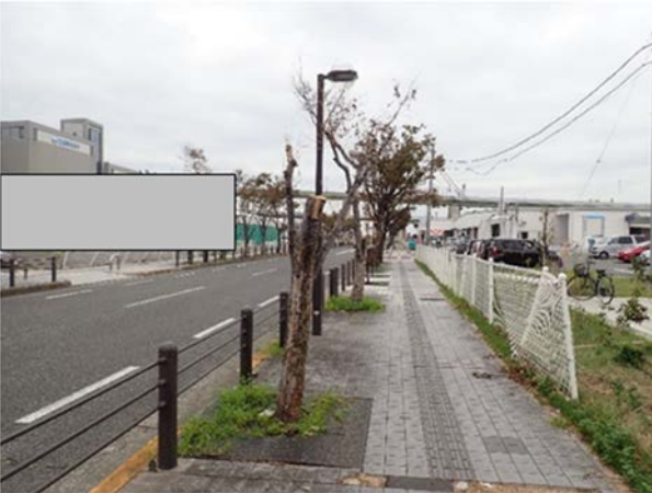
写真 4.54 街路樹の折損（折損範囲を切断済み）
