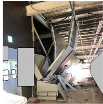
写真 4.18 店舗南西側の間仕切 (当該店舗提供)
