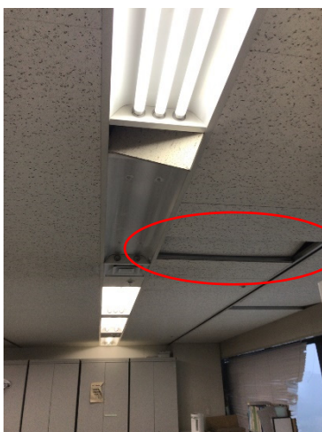
写真 3.11 被災直後の13階天井の持ち上がりの様子 (当該庁舎提供)
