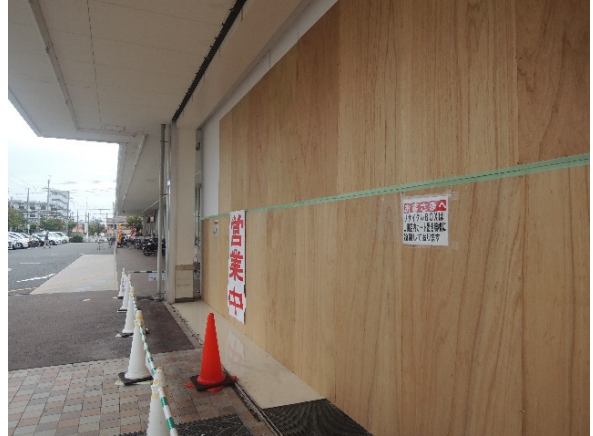
写真 4.39 南西面の養生の状況
