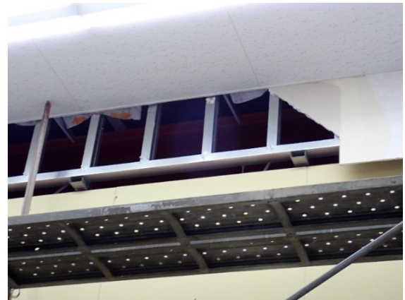
写真 4.5 脱落・転倒した建具の仮復旧状況 (屋内側) 2
