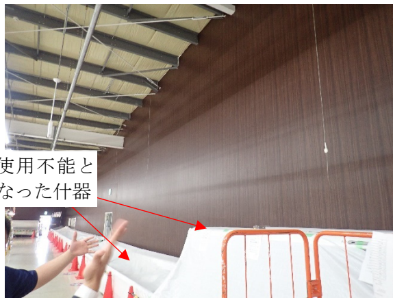
写真 4.19 修復済みの間仕切
