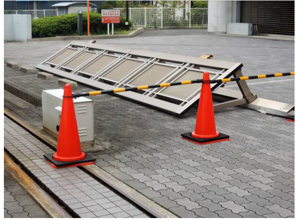
写真 4.51 移動式門扉の転倒
