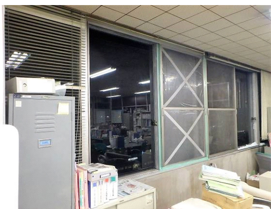
写真 3.14 庁舎Dの10階の窓ガラスの養生の状況（当該庁舎提供）
