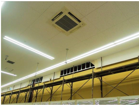
写真 4.4 脱落・転倒した建具の仮復旧状況 (屋内側) 1
