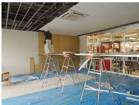
写真 4.15 天井の修復状況
