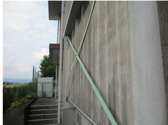
写真 4.1.10-2 ブレースのわずかなたわみ
