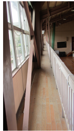
写真 4.1.3-4 2階（ギャラリーレベル）鉛 直ブレース（被害なし）
