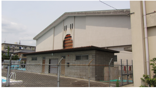
写真 4.1.3-1 外観（外壁の被害は写真 4.1.3-9, 4.1.3-10 参照）
