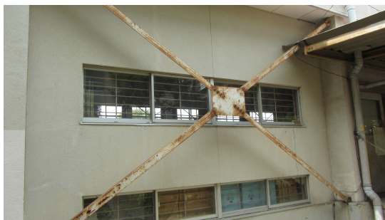
写真 4.1.3-3 1階鉛直ブレース（被害なし）
