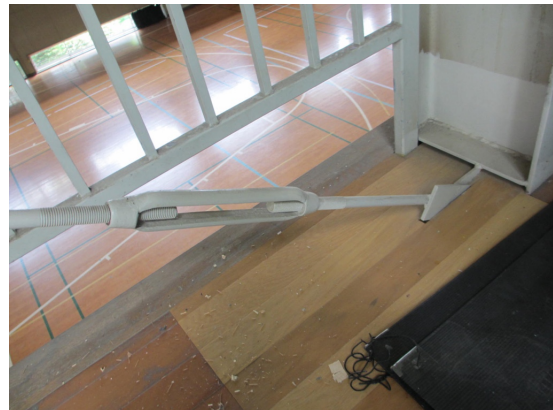
写真 4.1.1-2 耐震改修された鉛直ブレース （一部の床板が交換されている）
