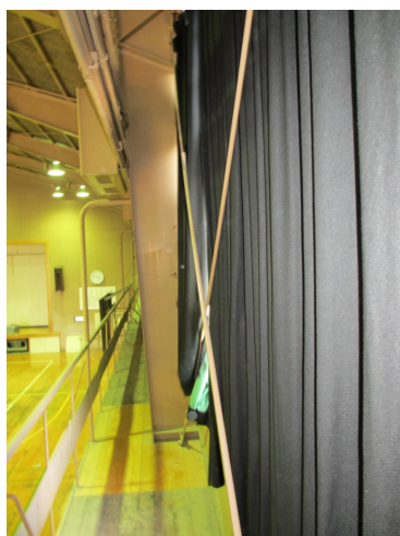
写真 4. 1. 11-3 改修で取り替えられたブレ ースのわずかなたわみ
