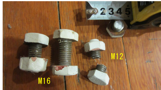
写真 4.1.7-4 屋根面水平ブレース用のボルト
