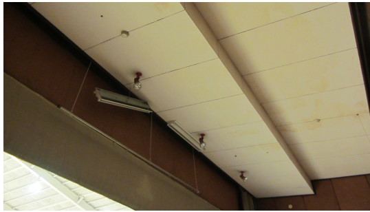
写真 4.1.7-7 舞台の天井（被害なし）と照明のぶら下がり
