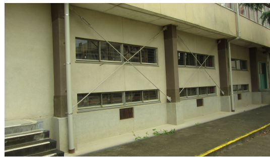
写真 4.1.7-10 1階鉛直ブレース（被害なし）
