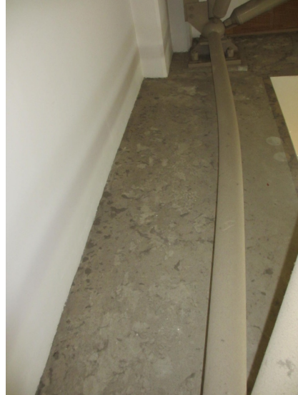
写真 4.2-12 体育館Nのトラス屋根の下弦材の曲がり
