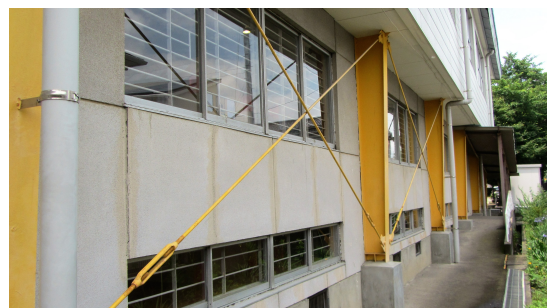
写真 4.1.8-6 1階の鉛直ブレース
