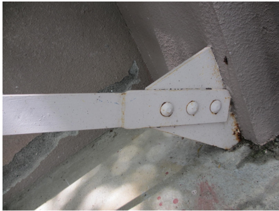
写真 4.1.6-5 ブレース端接合部分はやや幅広のプレート
