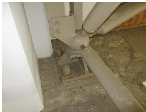
写真 4.1.14-8 建物の4隅はピン支承部であり無被害
