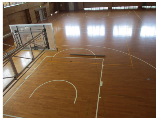
写真 4.1.14-2 落下したトラス下弦材
