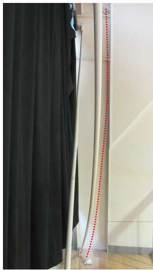
写真 4. 1. 4-4 鉛直ブレース（左：2階レベル、右：1階レベル）
