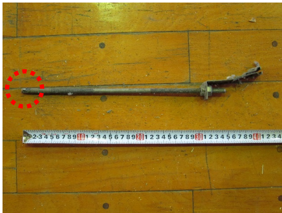
写真 4. 1. 15-7 吊り材 (円内は溶接痕)
