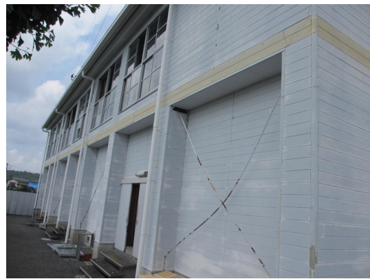
写真 4.1.9-6 1階のブレースの様子
