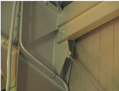
写真 4. 1. 11-5 改修で取り替えられたブレース（被害無し）
