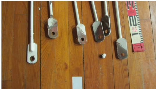
写真 4.1.7-3 撤去された屋根面の水平ブレースの羽子板部分（ボルト孔は健全）
