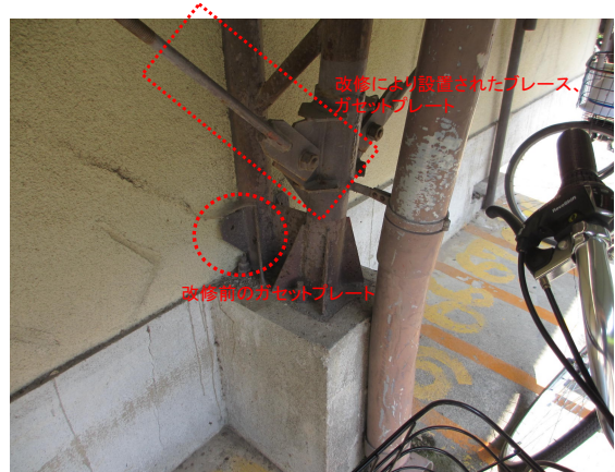
写真 4.1.13-2 耐震改修で取り替えられたブレース
