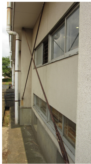
写真 4. 1. 4-4 鉛直ブレース（左：2階レベル、右：1階レベル）
