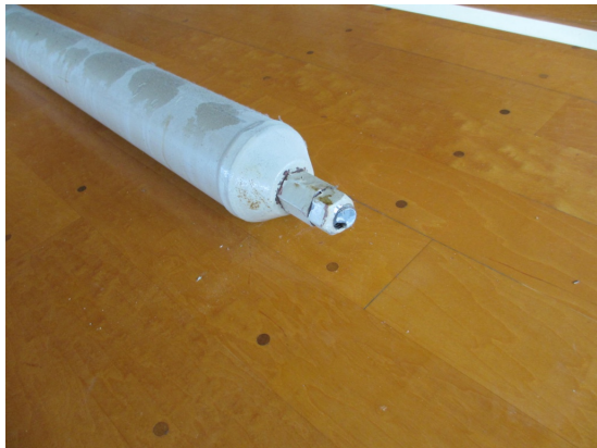
写真 4.1.14-5 落下したトラス下弦材
