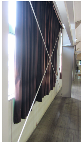
写真 4.1.8-3 2階鉛直ブレース
