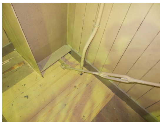
写真 4. 1. 11-4 改修で取り替えられたブレ ース（被害無し）
