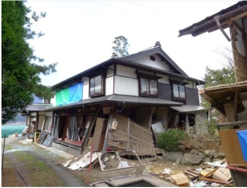
写真 5.3.11 開口の大きい面が大破した住宅 写真 5.3.12 床下の状況
