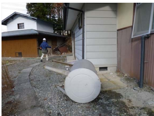
写真 5.3.24 灯油タンクの転倒
