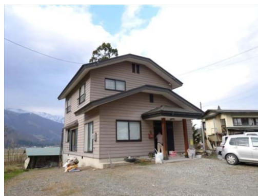
写真 5.3.25 外観からは被害が少ない住宅
