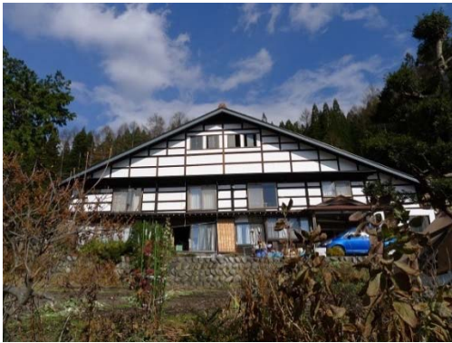
写真 5.1.12 大きな小屋組の住宅
