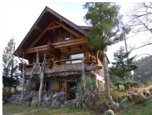
写真 5.3.21 1F RC+2階ログハウスの建築物
