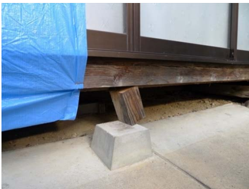
写真 5.3.15 束のずれ
