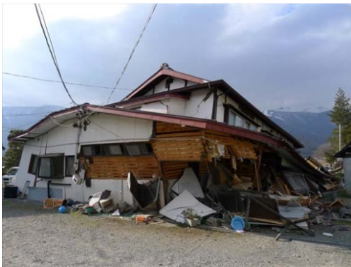
写真 5.3.1 倒壊した住宅
