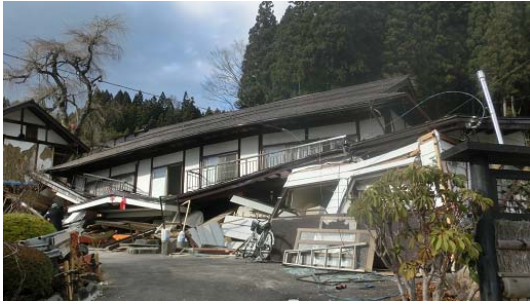
写真 5.2.4 倒壊した住宅
