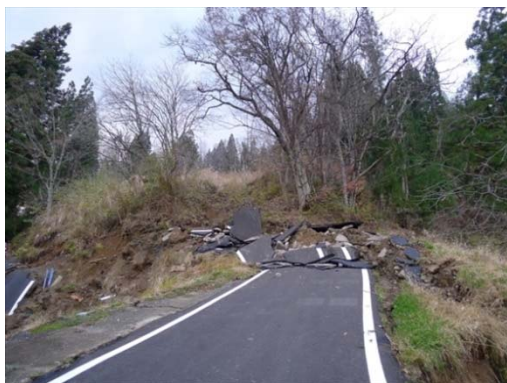
写真 6.1.3 土砂崩れによる道路の被害
