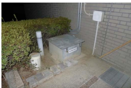
写真 6.2.3 小川村震度計設置状況
