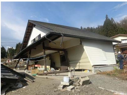
写真 5.1.18 大きく傾いた車庫
