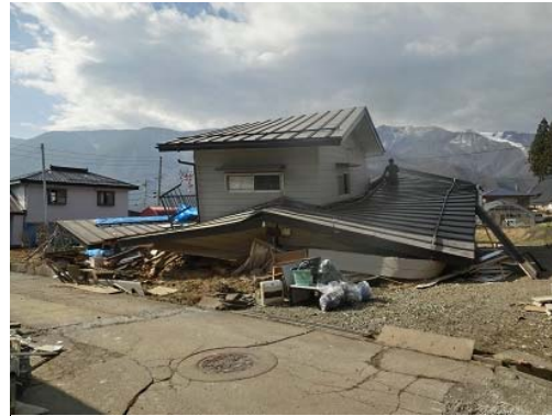
写真 5.1.15 倒壊した住宅
