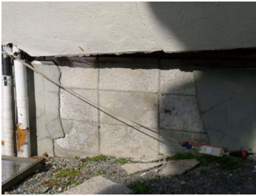
写真 5.3.3 コンクリートブロック基礎
