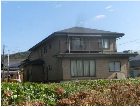
写真 5.1.20 外観上無被害の住宅
