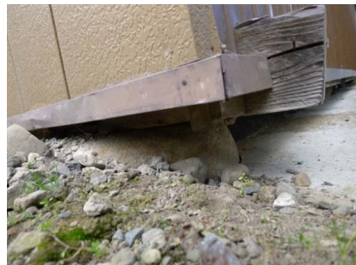
写真 5.3.16 土台のずれ
