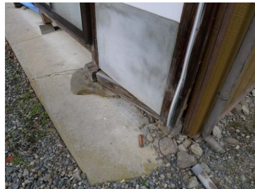
写真 5.3.14 土台のずれ
