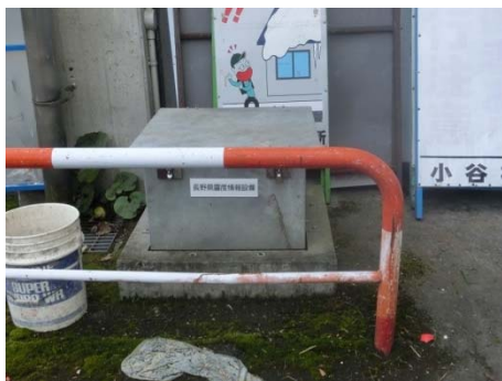
写真 6.2.1 小谷村震度計設置状況
