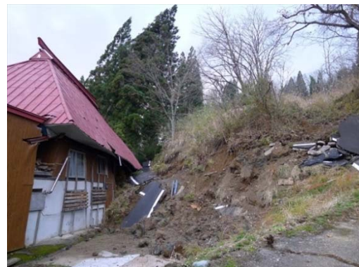
写真 6.1.2 建築物背面の土砂崩れ
