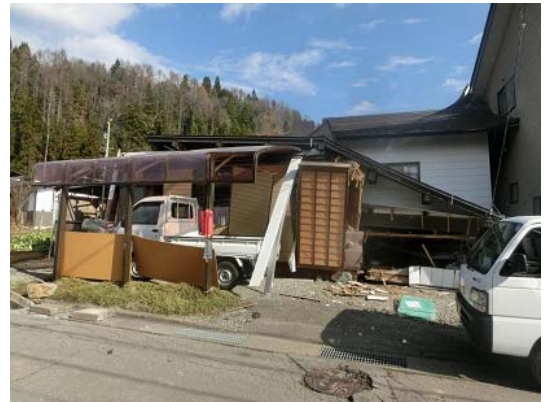
写真 5.1.9 倒壊した住宅
