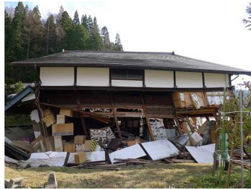
写真 5.1.13 北へ大きく傾いた住宅
