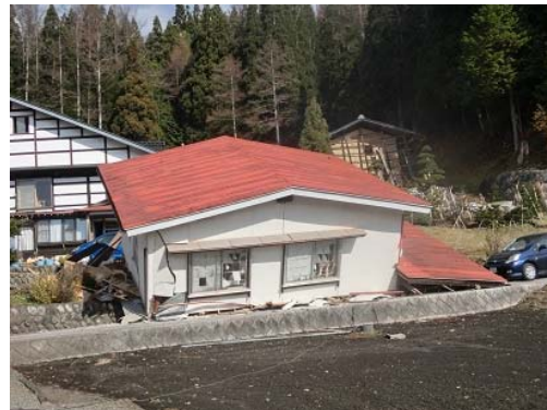
写真 5.1.17 倒壊した納屋併用家屋（手前）
