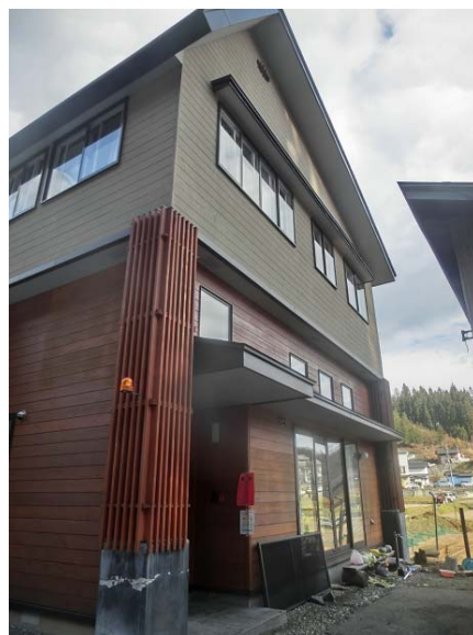
写真 5.2.2 1階部分に鋼管がある住宅
