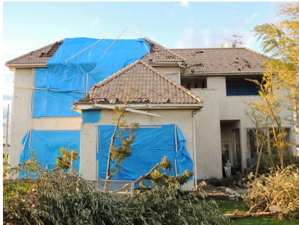
写真 4.2.13 屋根及び開口部の応急措置の状況
