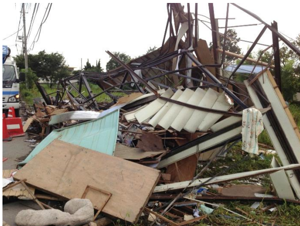
写真3 飛散した上部構造
