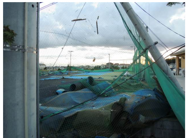
写真 4. 4. 6 テニスコート人工芝等の被害
