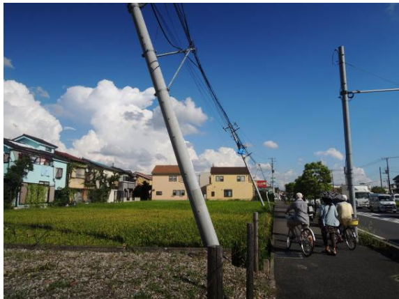
写真 4. 4. 3 電柱の傾斜
