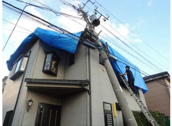
写真 4. 4. 4 電柱の折損 (隣家に衝突している)
