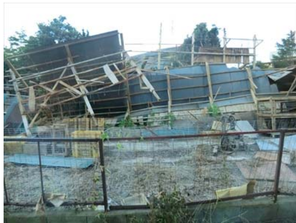
写真 5.1.11 倉庫の倒壊
