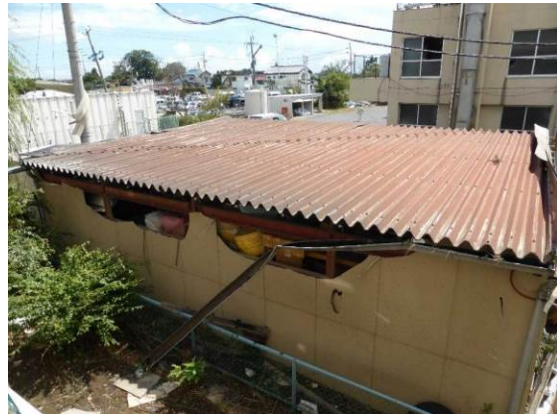
写真 4.1.24 建築物背後の倉庫
