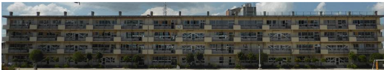
写真 4. 1. 11 本校舎外観及び教室側構面のガラス窓被害
