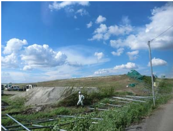
写真 5.2.20 フェンスの被害
