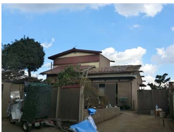
写真 5. 2. 3 小屋組の被害
