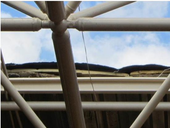
写真 4.1.5 屋根ふき材の断面
