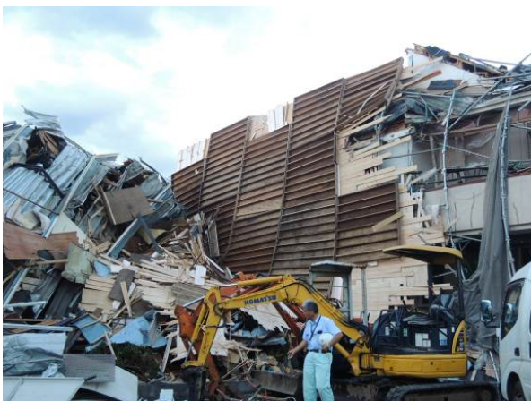
写真 4.2.3 上部構造の飛散
