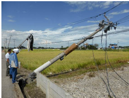
写真 4. 1. 10 電柱の倒壊
