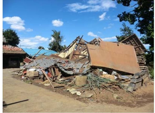
写真 5. 2. 13 納屋の倒壊
