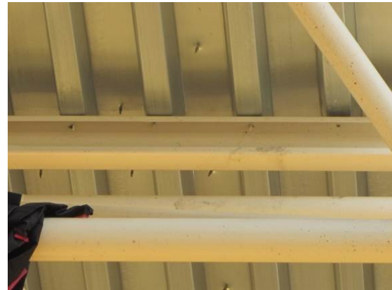
写真 4.1.6 屋根ふき材と母屋との接合部（ビス）
