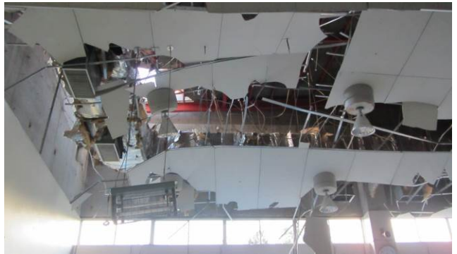
写真 4. 1. 28 天井の破壊
