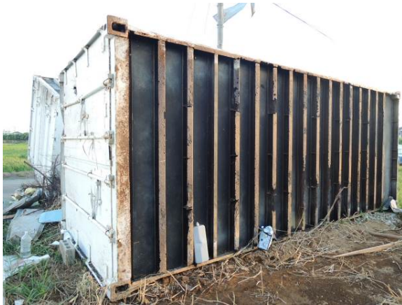
写真 4. 4. 1 転倒した鋼製コンテナ (1)
