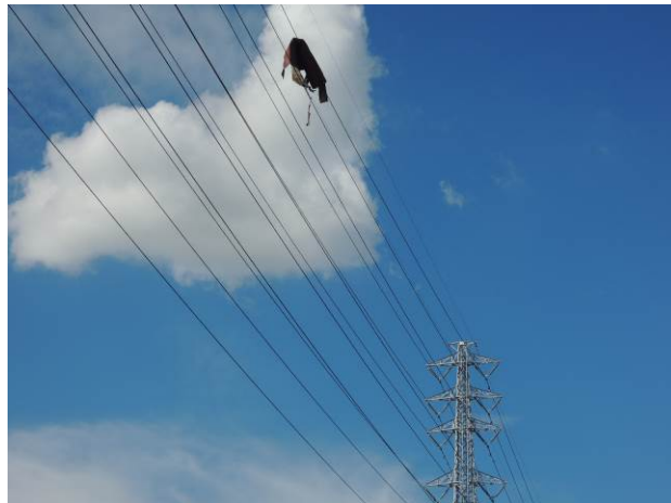
写真 4.3.2 電線に引っ掛かった外装材
