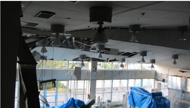
写真 4. 1. 28 天井の破壊
