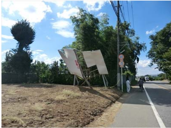
写真 5.2.18 看板の被害
