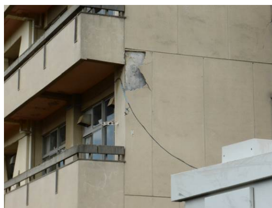
写真 4.1.1 本校舎外観及び窓ガラス被害 写真 4.1.2 本校舎の仕上げモルタルの剥落
