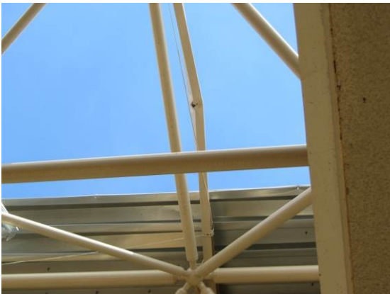
写真 4.1.7 母屋の変形
