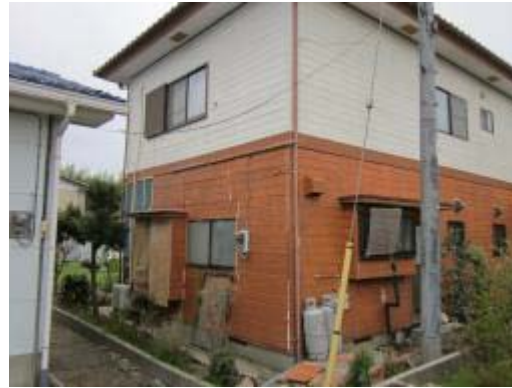
写真 5. 4. 2-20 外観－北東角／外壁補修箇所
