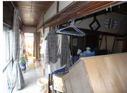
写真 5. 4. 2-30 内部の様子（既存部分、傾斜）
