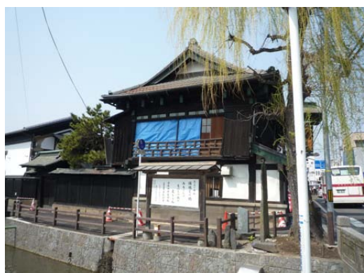
写真 5. 4. 2-37 母屋 3 の南側外観
