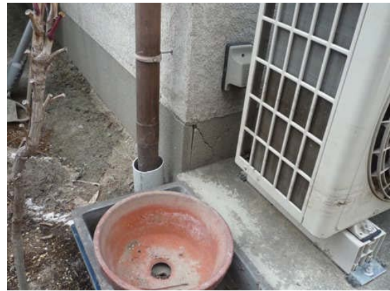
写真 5. 4. 2-54 基礎の亀裂
