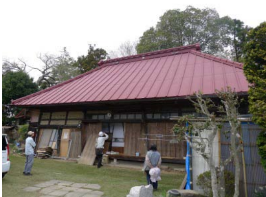
写真 5. 4. 2-15 調査建物の外観
