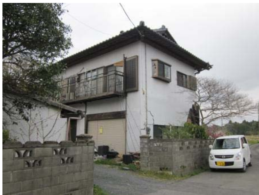
写真 5.4.2-11 建物外観、写真右側ガレージが倉庫
