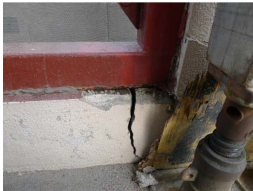
写真 5. 4. 2-26 基礎の亀裂
