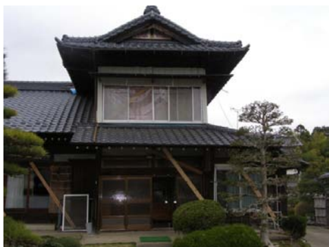
写真 5. 4. 2-1 外観と仮筋かい補強
