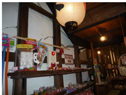
写真 5. 4. 2-36 1階土壁の亀裂と剥落
