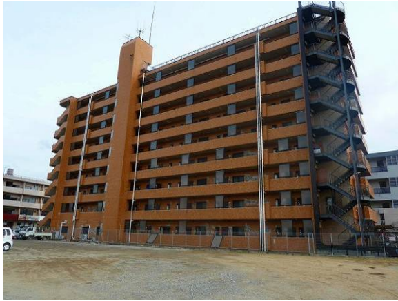
写真 32 集合住宅 B の外観
