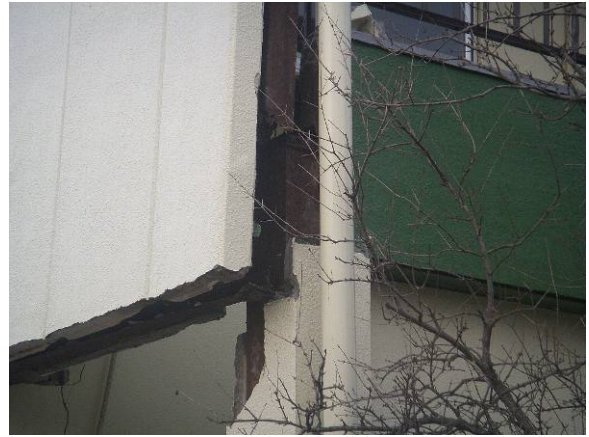
写真 41 事務所ビル C の外観と柱脚部の腐食
