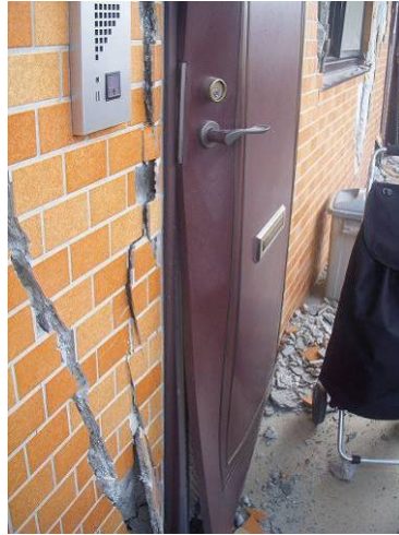
写真 37 玄関ドアの変形
