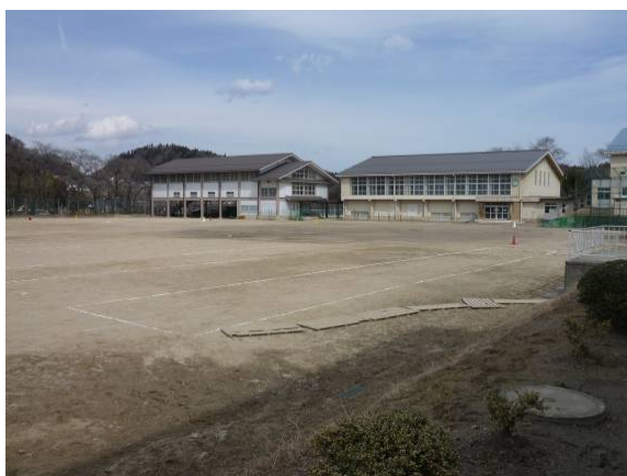
写真 15 第 2 体育館の外観 (左は柔剣道場)
