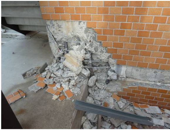
写真 34 1階柱脚部の破壊状況
