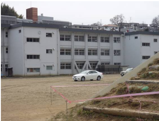
写真 19 C 小学校校舎外観
