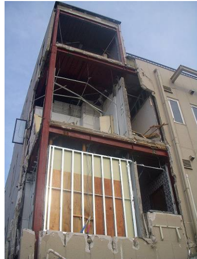
写真 29 ペントハウス部分の詳細
