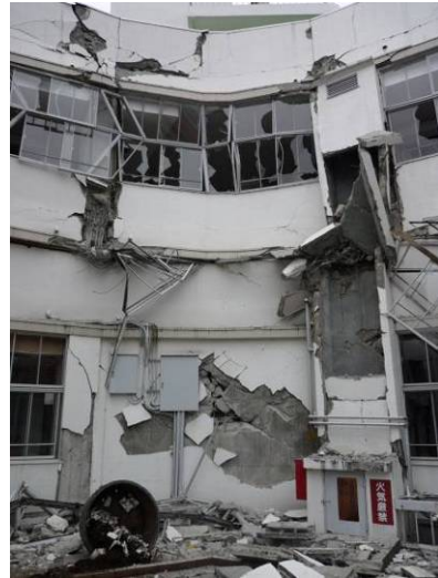
写真 75 本館中央部 (エキスパンション・ジョイントの存在は 確認できない)
