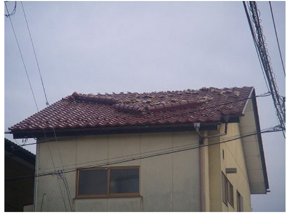
写真 60 棟瓦の脱落
