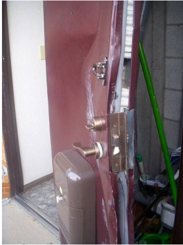
写真 37 玄関ドアの変形
