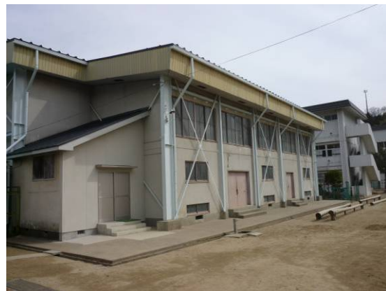
写真 20 屋内運動場外観
