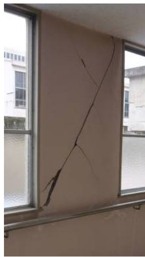
写真 63 柱と方立て壁のせん断ひび割れ
