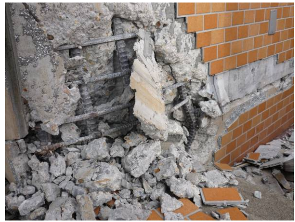
写真 34 1階柱脚部の破壊状況
