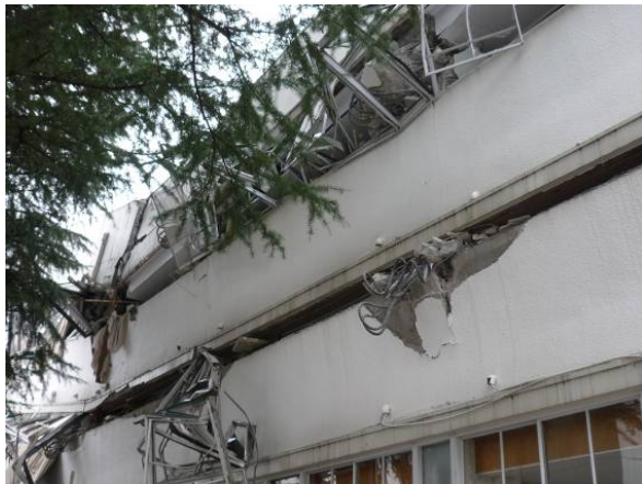
写真 76 2階層崩壊部
