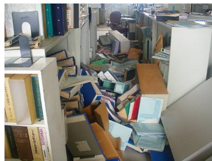
4階（ロッカーの転倒と書類の散乱）
