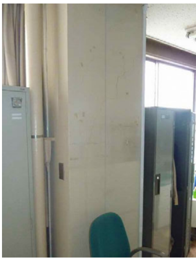
写真 63 柱と方立て壁のせん断ひび割れ
