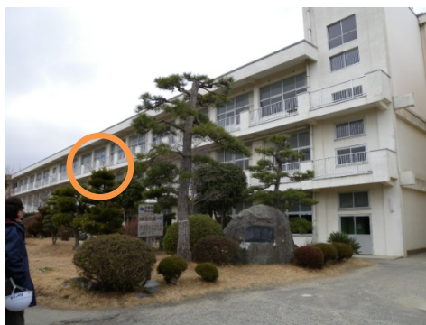
写真1 A中学校の校舎外観
