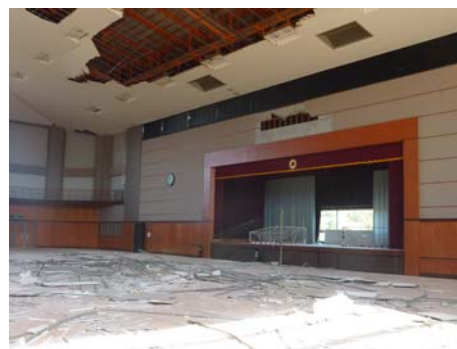
写真 17 天井の脱落 2
