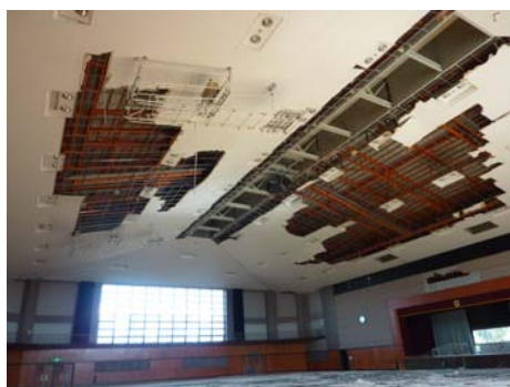
写真 16 天井の脱落 1
