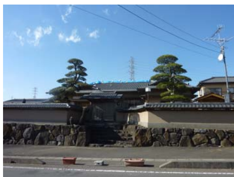
写真 20 木造住宅の瓦の被害
