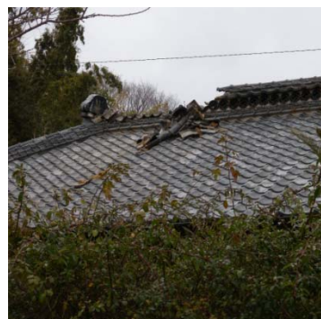
写真 8 拡大図(写真 7 の○印内)
