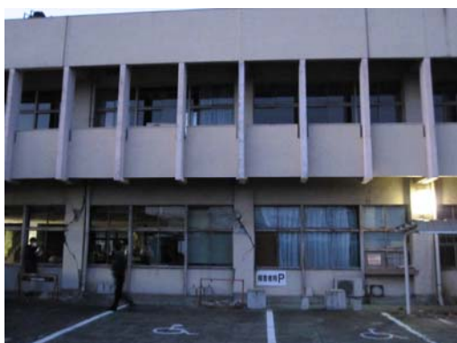
写真 31 建物の被害の外観
