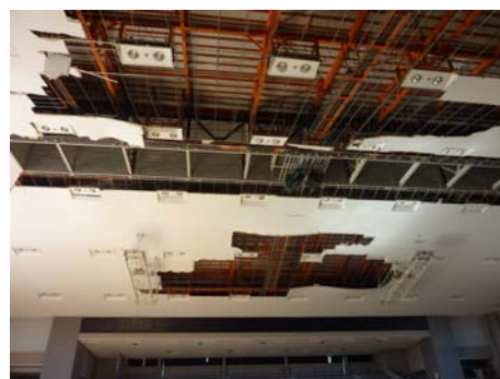
写真 17 天井の脱落 2
