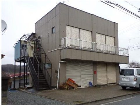
写真 39 鉄骨造建築物の被害 (栗原市瀬峰)
