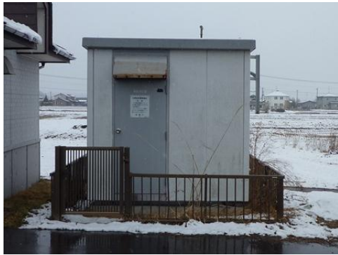
写真 35 栗駒の JMA 地震計設置状況 (栗原市栗駒)
