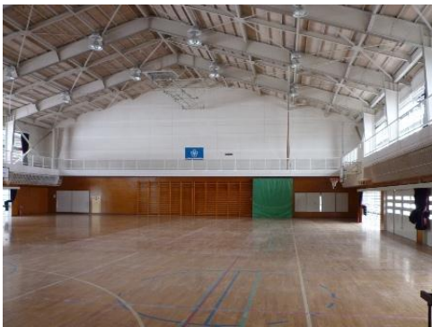
写真 31 小学校体育館内部 (栗原市栗駒)
