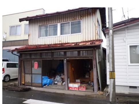
写真15 町屋形式の住宅の被害
