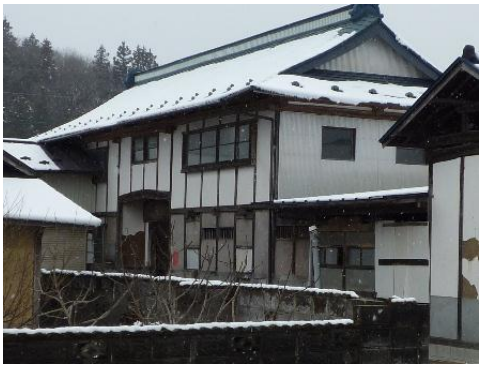
写真 29 長屋門の土塗り壁剥落 (栗原市栗駒桜田)
