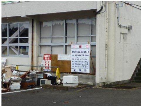
写真 41 瀬峰の震度計設置状況 (栗原市瀬峰)
