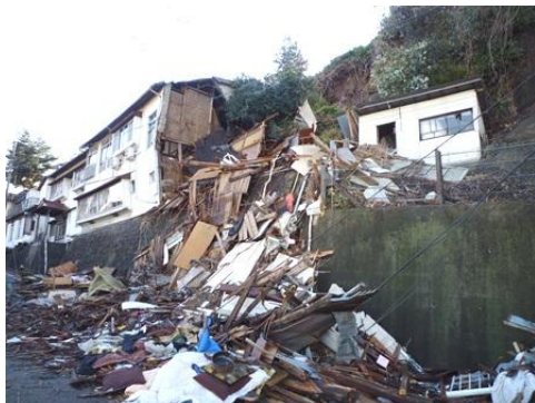
写真 43 旅館の倒壊現場 (仙台市太白区向山)
