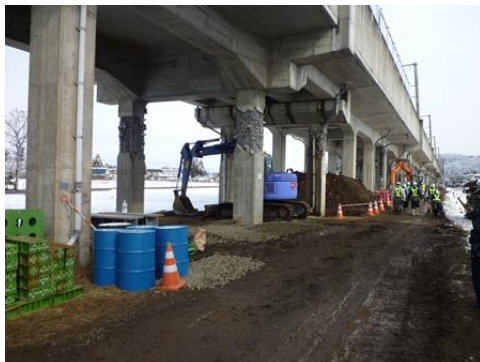
写真 25 新幹線橋脚の破壊 （北上市更木）
