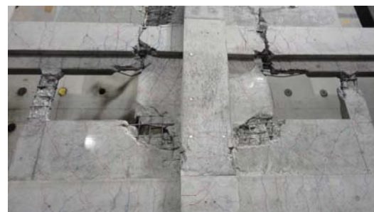
写真 2 壁付き架構実験
