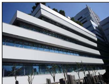
写真 2-33 壁面緑化 (見かけ上 400 m 2 )
