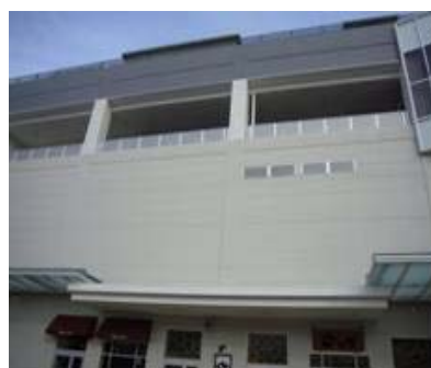
写真 2-29 壁面緑化 (見かけ上 100 m 2 )
