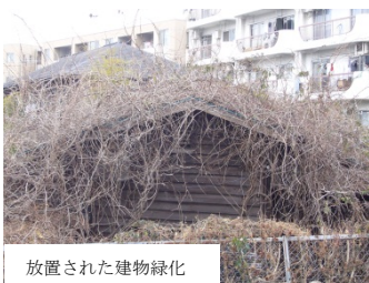
放置された建物緑化
