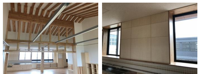
図 2 吸音処理をした室内の例
