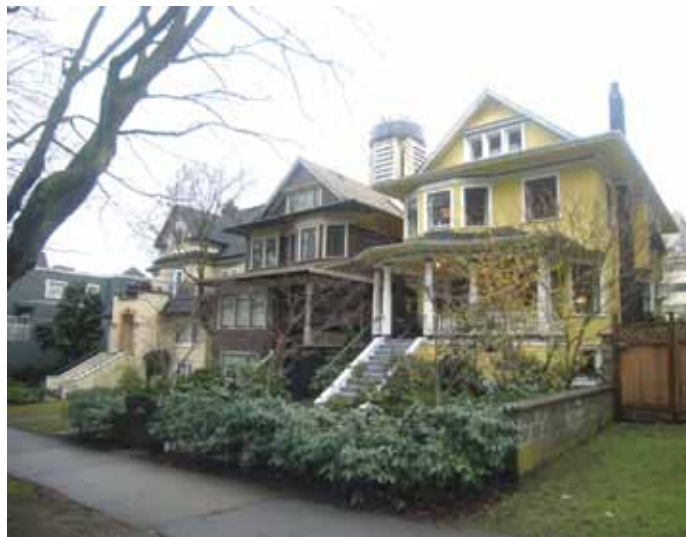
■ 写真1 築100年に近い木造住宅（カナダ）
