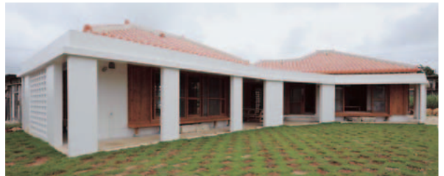
写真5 RC造の深い軒を持つ「エコハウス：郊外型」。軒先の半戶外空間は、暑さをしのいだり、洗濯物を干すなど様々なアクティビティが行われる。
