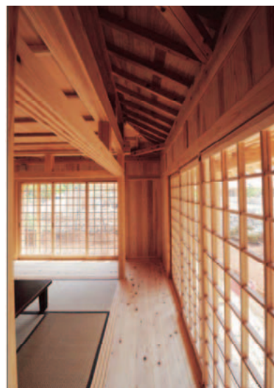
■写真2 かたあきの里の各棟は、十分な通風を常時確保するため、鍵のかかる網戸を備えた格子戸を開口部に備えている。
