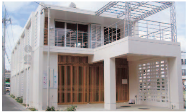
写真3 間口の狭い市街地内の敷地にあわせて建設された「エコハウス：市街地型」
