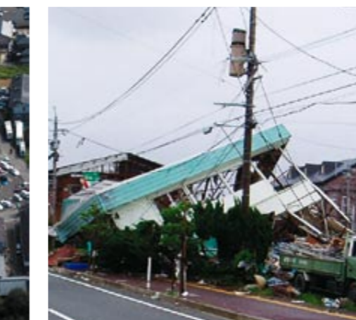
写真3 竜巻により倒壊した建築物(延岡市提供)
