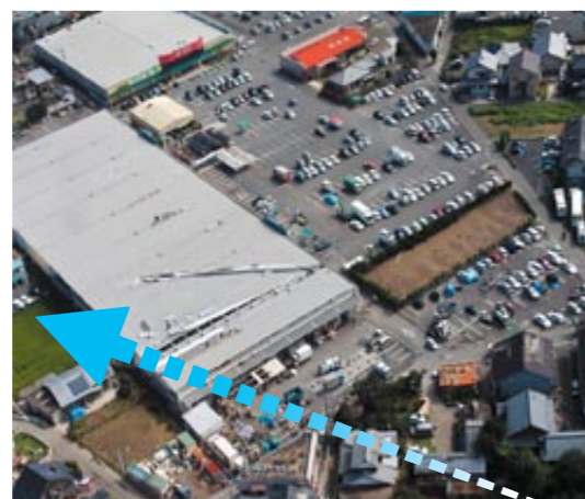
写真2 ホームセンターの折板屋根のはく離し 矢印が竜巻の通った経路(延岡市提供)
