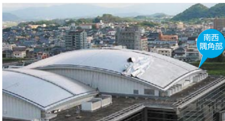
写真5 台風13号による飯塚市文化施設(イズカコスモスコン)の屋根被害(イズカコスモスコン提供)
