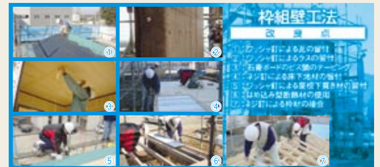
図3 解体・分別し易い木材建築物の設計 瓦等の留付方を工夫することなどにより解体時に分別しやすい設計手法を取りまとめた 94㎡、1988年築の建物 13日43人工 143㎡、1986年築の建物 25日69人工
