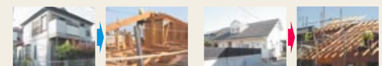
図4 解体手間の比較 良質な解体材を得るためには、通常より手間をかけて解体することが必要
