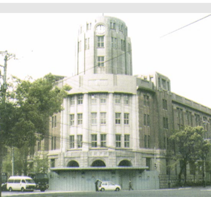
兵庫県南部地震に耐えた結果、構造上の不安が払拭され、保存活用されることになった神戸税関。避難所にもなった小学校と並んで、戦前の基準で設計された建物の中にも頑丈な物件が多い。
