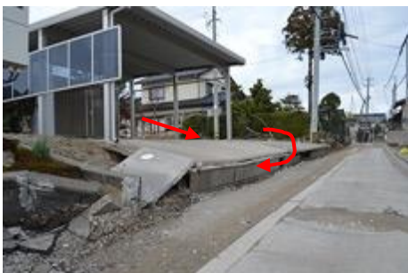
k) 側方流動と側溝の回転
