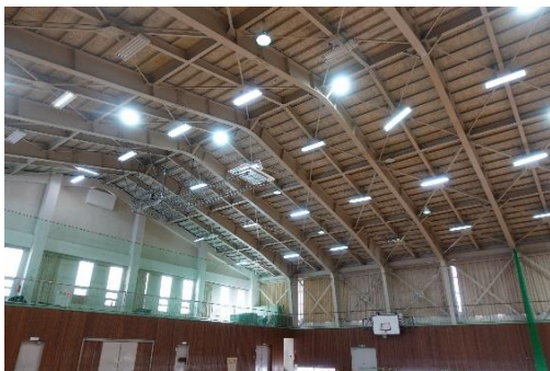
写真 5.5-137 第一体育館 内観
