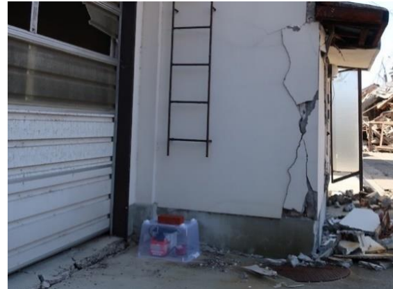
写真 4.4-17 地震計設置状況 (WJMG、Atom No.7_164)
