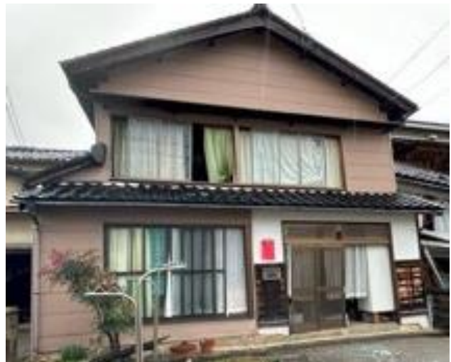
写真5.2.2-59 残留変形がある家屋（穴水町大町）
