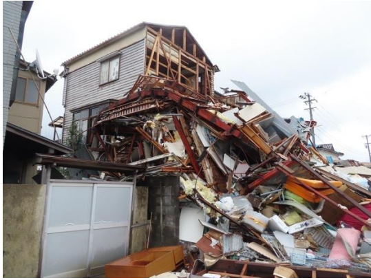
写真 5.5-5 2階、3階の倒壊の状況
