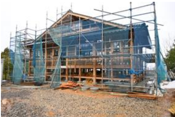
写真5.2.2-76 建設中の石場建て木造住宅
