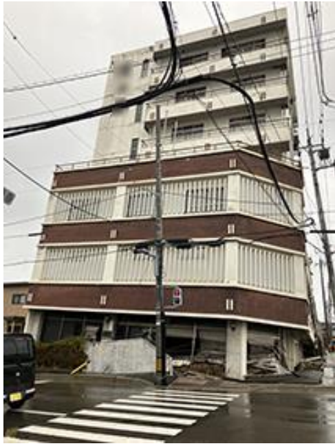
写真 5. 4. 2-21 建物全景（南側から撮影）
