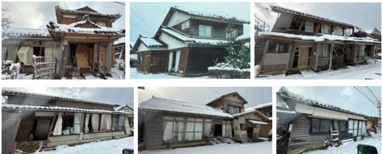
写真5.2.2-21 一部は安全限界変形を超えるような大きな残留変形がある家屋（門前町道下・館）
