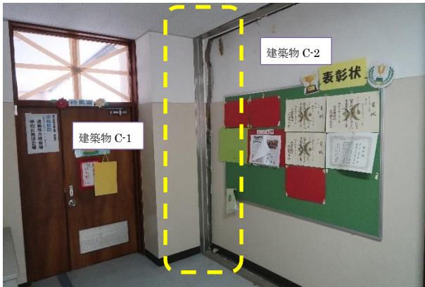
写真 5.3.2-30 建築物 C-1 と C-2 の間の Exp. J. の被害
