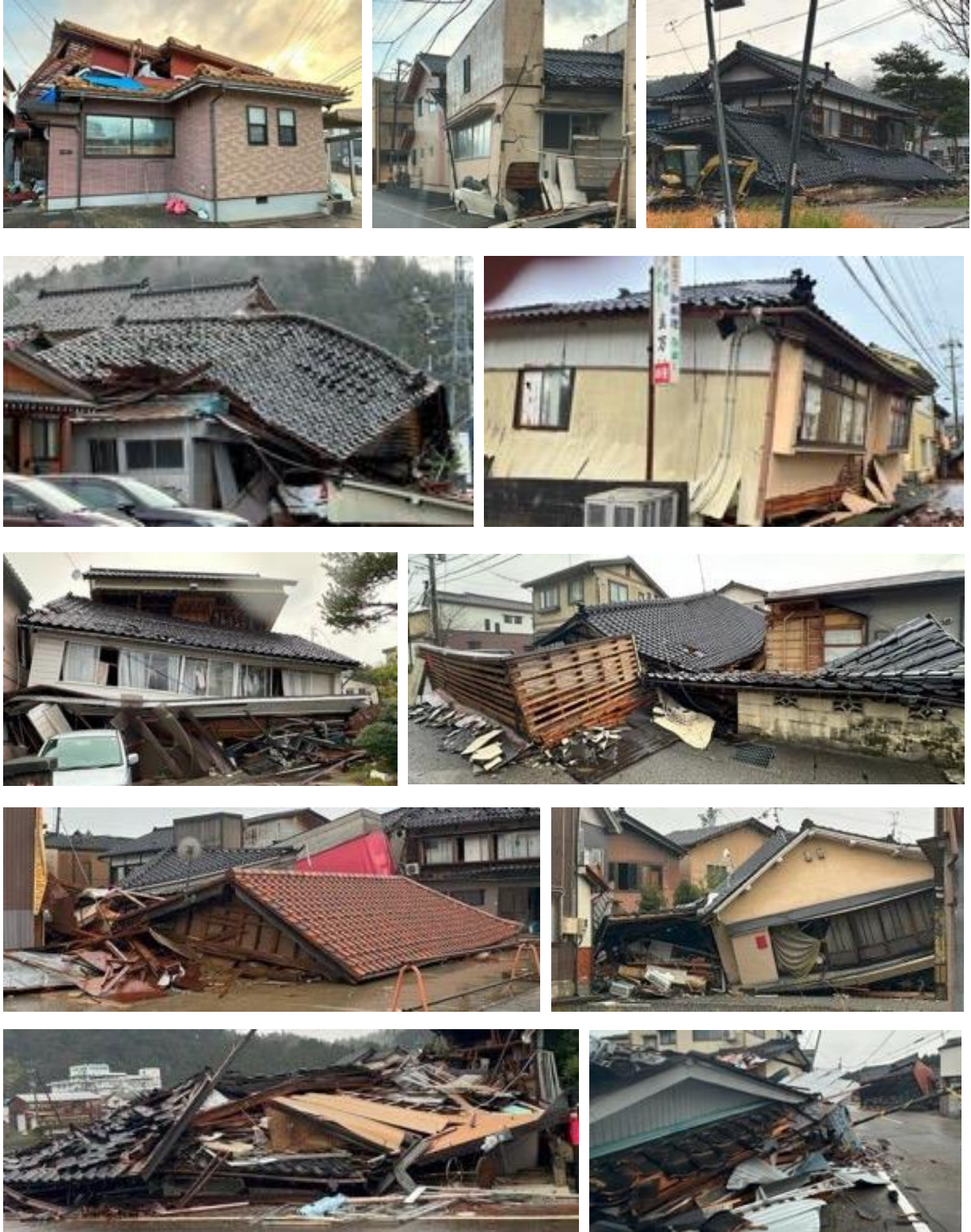
写真5.2.2-58 穴水町大町の倒壊家屋群
