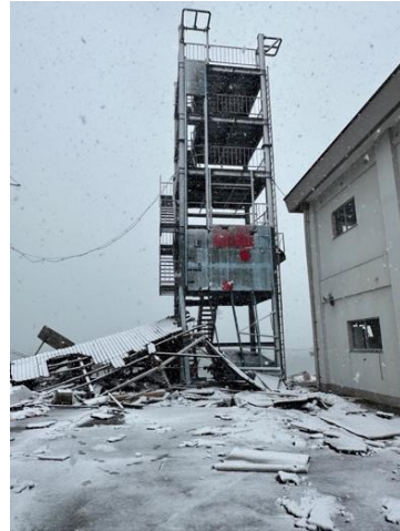
写真 5.7-21 津波避難施設の外観(陸側からの撮影)
