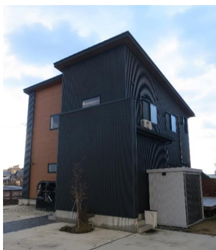
(ア) 南東側から見た建物全景
