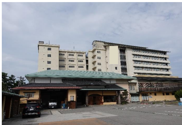
写真 5.3.2-163 建築物南側外観
