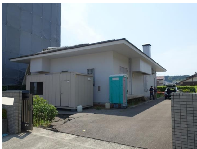
写真 5.3.2-49 建築物外観 (北側)
