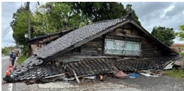
写真5. 2. 2-41 珠洲市三崎町二本松で2023年地震時に倒壊した家屋 (2023年5月撮影)
