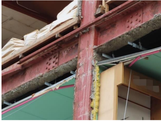
写真 5.5-104 日の字断面柱梁接合部
