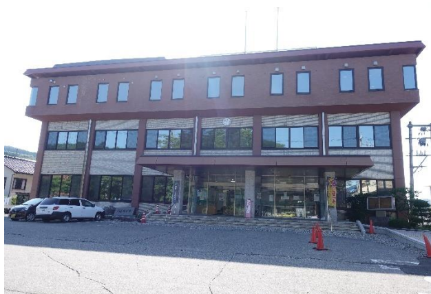
写真 5.3.2-171 AL-1 棟東側全景
