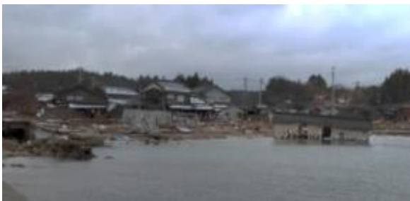
写真5. 2. 2-70 津波により湾に流出した木造住宅
