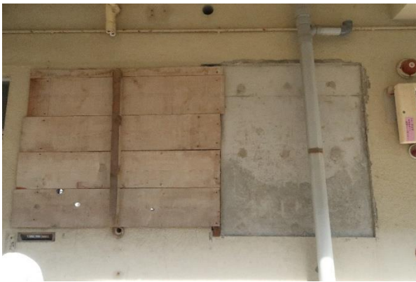
写真 5.3.2-149 施工途中の開口閉塞補強
