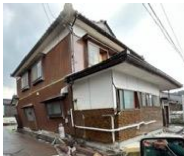
写真5. 2. 2-9 一部は安全限界変形を超えるような大きな残留変形のある住宅（鳳至町）
