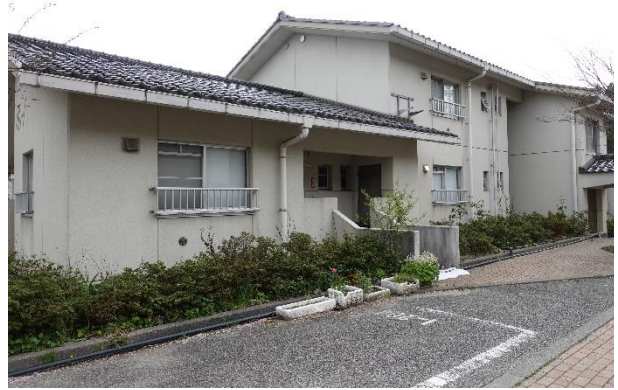
写真 5. 3. 2-189 県営住宅の外観
