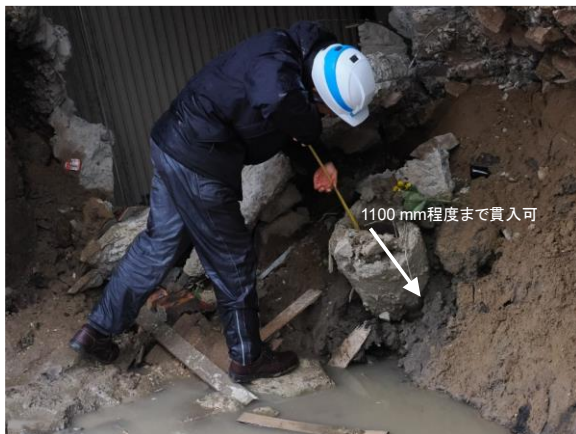
写真 5. 4. 2-15 露出した杭頭
