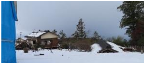
写真5.2.2-49 1層が崩壊した木造住宅と倉庫
