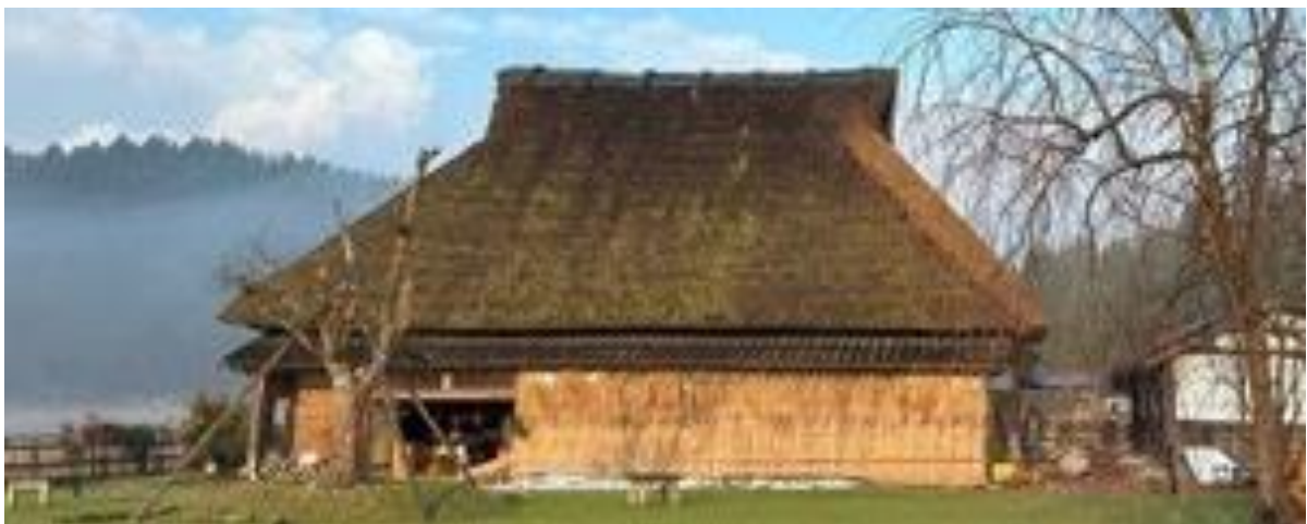
写真5. 2. 2-12 被害軽微に見える藁葺き屋根の民家
