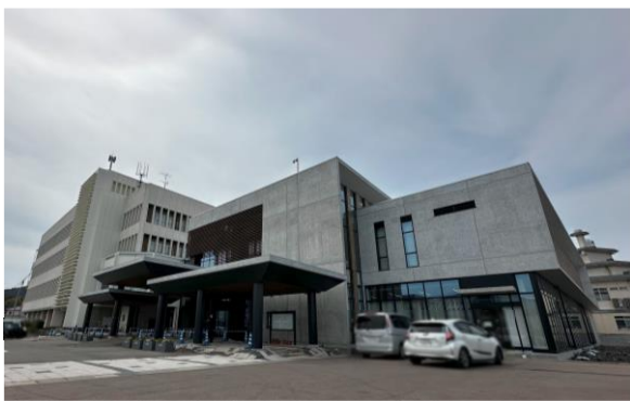
写真4.4-1 WJMS（輪島市役所）概観
