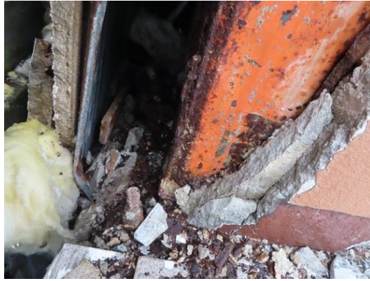
写真 5.5-49 露出柱脚の状況
