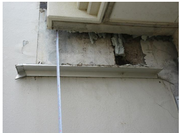
写真 5.3.2-21 建築物 B-2 と別棟の間の Exp. J. の段差
