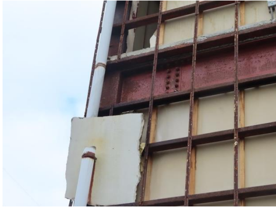
写真 5.5-115 柱梁接合部
