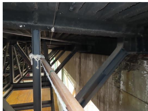
写真 5.5-124 支承部の状況
