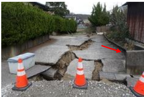
o) 側方流動した地盤と地割れ
