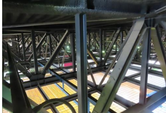
写真 5.5-120 鉄骨立体トラス梁の屋根
