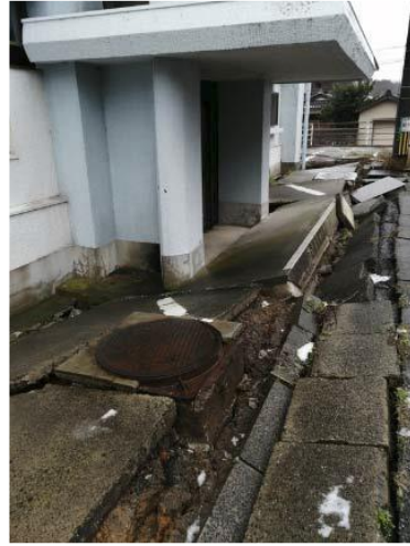
写真 5. 4. 2-46 G住宅の地盤被害の状況
