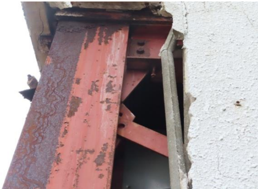
写真 5.5-76 H形鋼弱軸側の柱梁接合部
