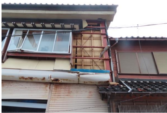
写真 5.5-22 ターンバックルブレースの状況
