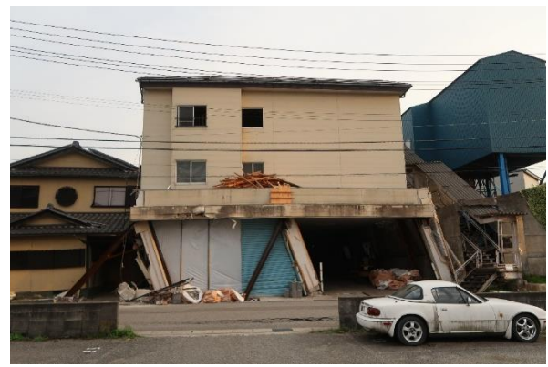
写真 5.3.2-150 隣接する鉄骨造住宅の被害
