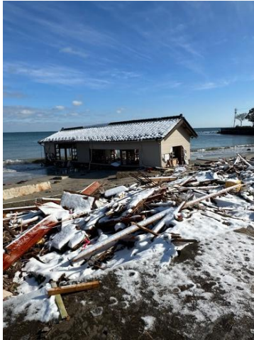
写真 5.7-28 住宅の2階部分の移動
