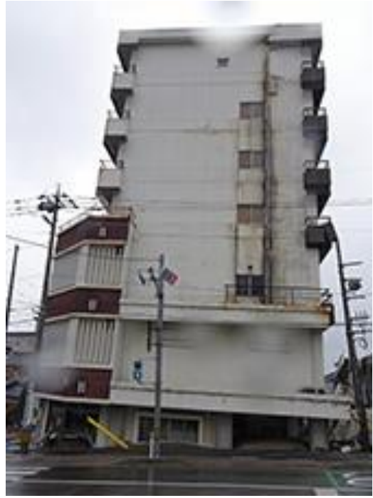
写真 5. 4. 2-22 建物全景（東側から撮影）
