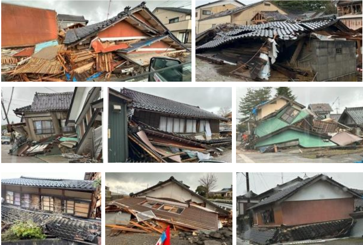
写真5. 2. 2-33 珠洲市正院町正院で倒壊した木造家屋
