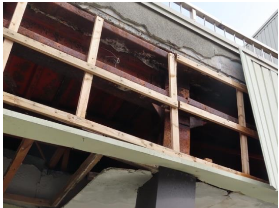
写真 5.5-13 2階柱頭部の梁端部接合部
