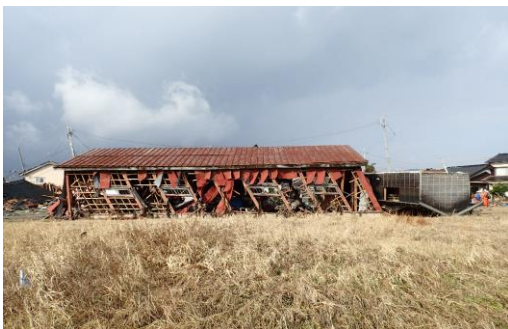
写真 5.7-34 鉄骨造倉庫の状況
