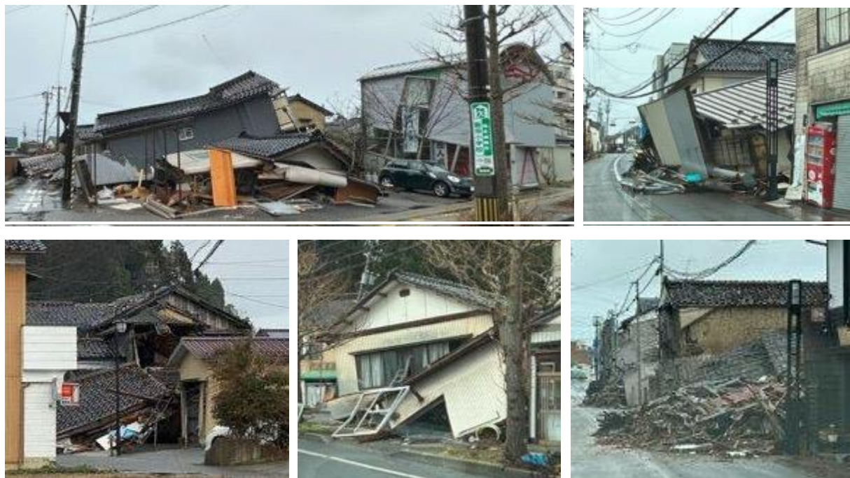
写真5. 2. 2-28 珠洲市役所近辺で倒壊した木造家屋群（珠洲市飯田町）
