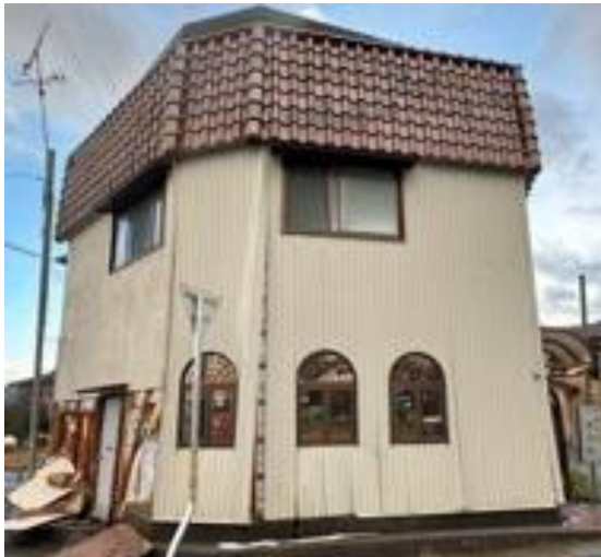
写真5.2.2-59 残留変形がある家屋（穴水町大町）
