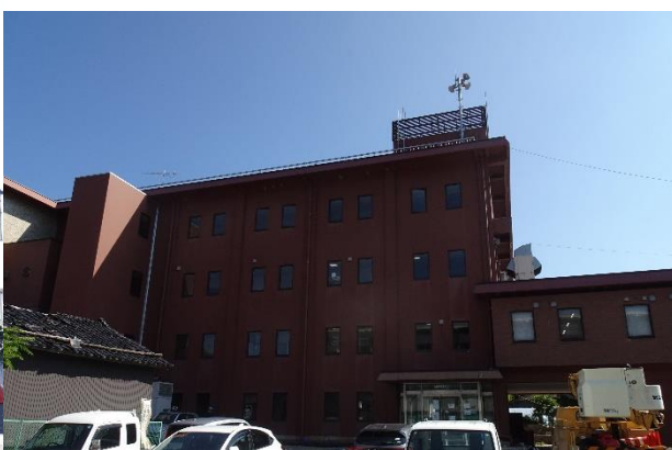
写真 5.3.2-172 AL-2 棟北側全景
