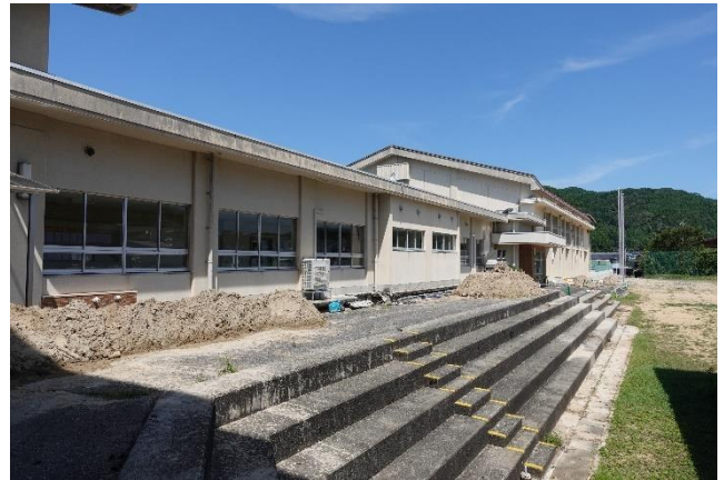
写真 5. 3. 2-38 建築物 D-2 南東側全景
