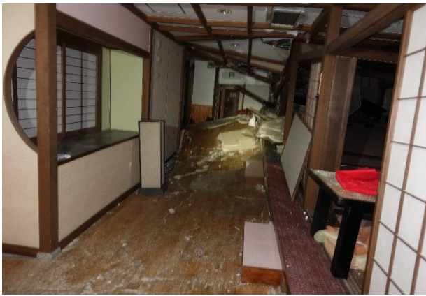
写真 5.3.2-167 西側棟 1 階室内の状況
