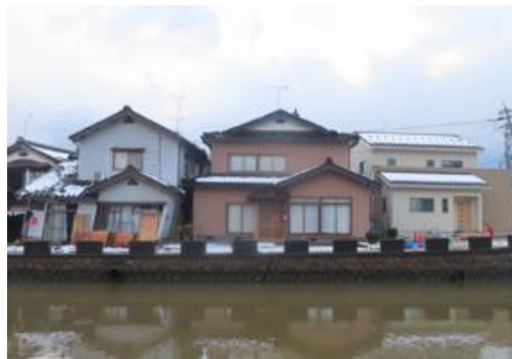
写真5. 2. 2-63 大きく傾斜した木造住宅 (左)
