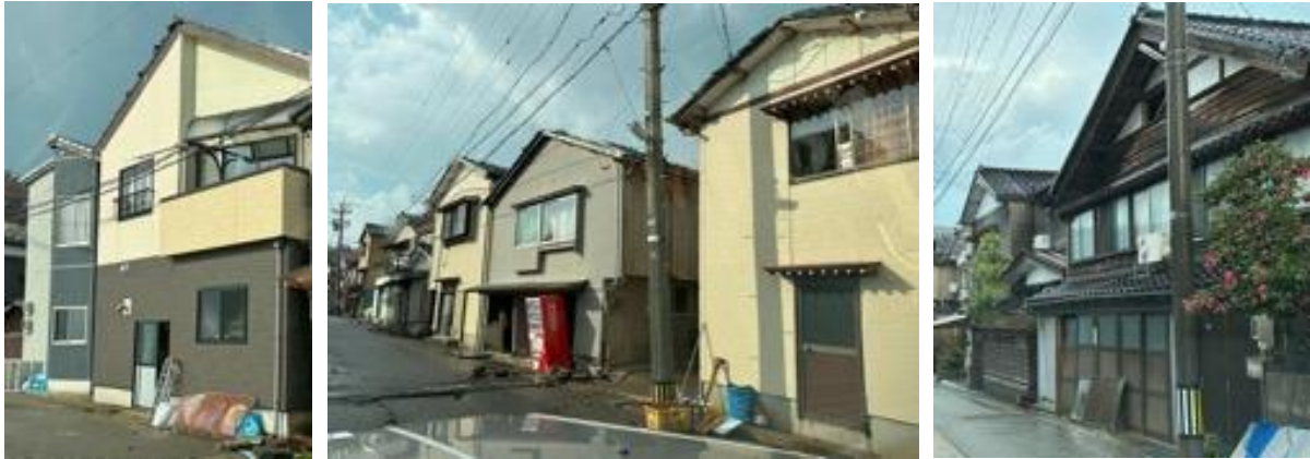
写真5. 2. 2-10 比較的被害が軽微と見受けられる木造住宅（鳳至町）
