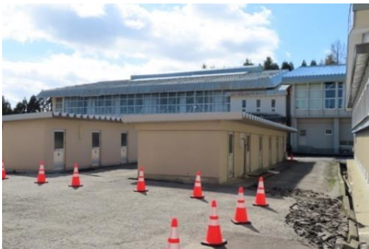
写真 5.5-143 第二体育館 外観
