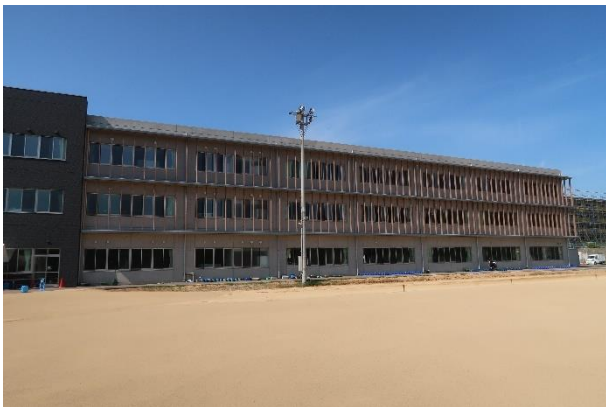
写真 5.3.2-116 建築物 O-1 外観
