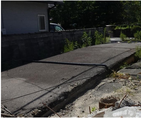
写真 5.3.2-175 応急復旧した排水管
