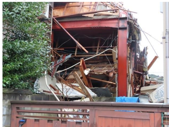
写真 5.5-4 1階は倒壊していない
