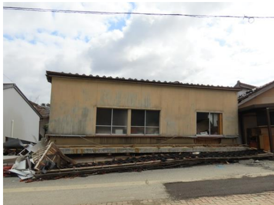
写真 5.5-16 1階の層崩壊
