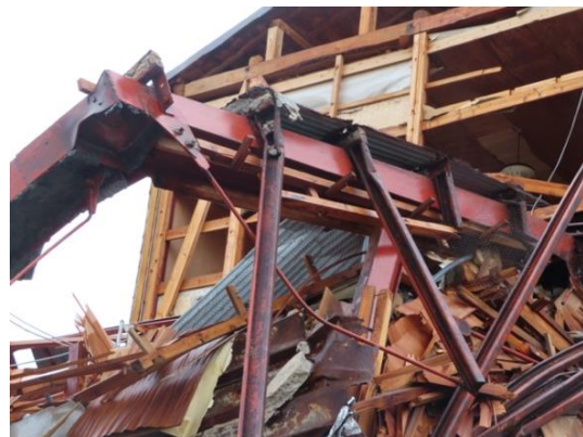
写真 5.5-2 3階柱頭部のH形柱弱軸方向に接続するターンバックルブレース
