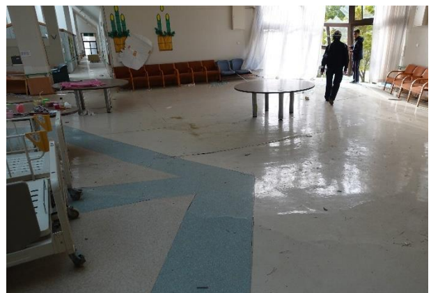
写真 5.3.2-197 床の傾斜
