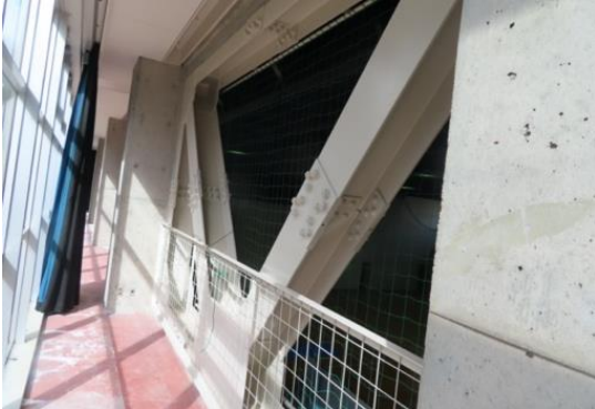
写真 5.5-119 枠付き H 形鋼ブレースフレームによる耐震補強
