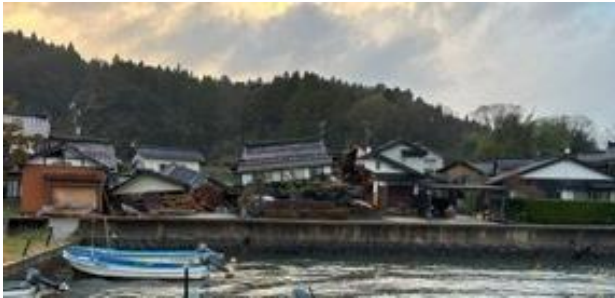
写真5. 2. 2-52 穴水町曾福の倒壊家屋群
