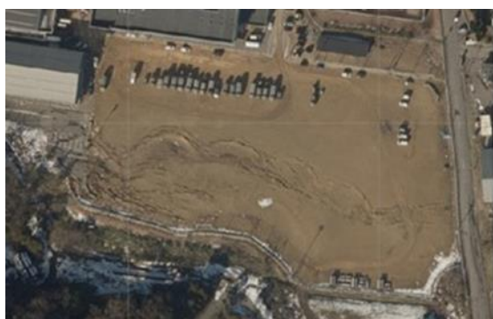
写真 5. 4. 2-42 校庭の地割れ全景 5.4-12)
