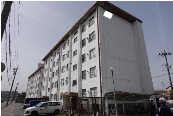
写真 5.3.2-139 建築物 AC-2 外観
