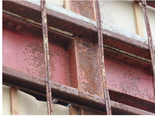
写真 5.5-116 柱梁接合部の部材等
