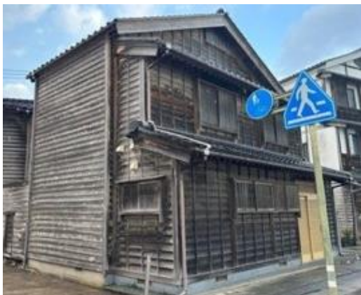
写真5. 2. 2-4 被害軽微に見える比較的古い木造家屋
