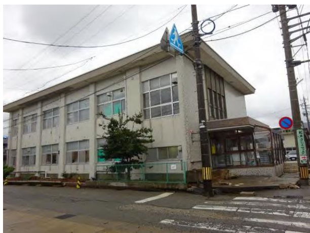
写真 5.3.2-180 建築物 AN-1 外観
