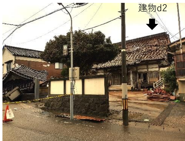
写真 6.2.2-8 建物 d2 北側道路前の樹木の状況
