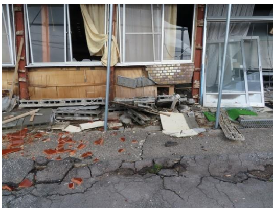
写真 5.5-32 外壁や地盤の状況
