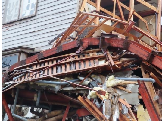
写真 5.5-6 2階のターンバックルブレース
