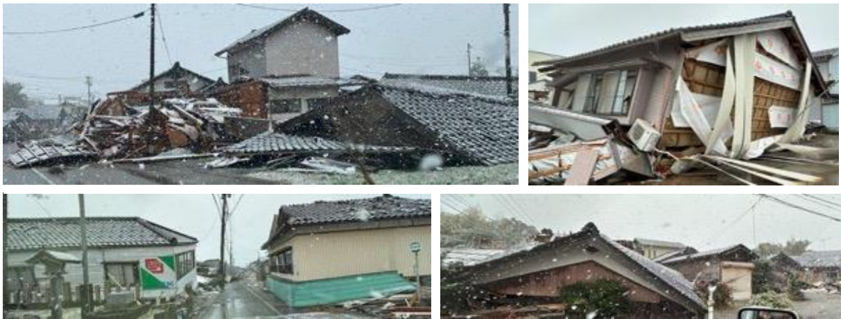
写真5.2.2-36 珠洲市宝立町鶴飼の倒壊家屋群
