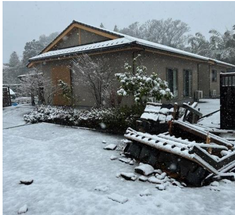
写真 5.7-39 住宅に隣接した門の倒壊
