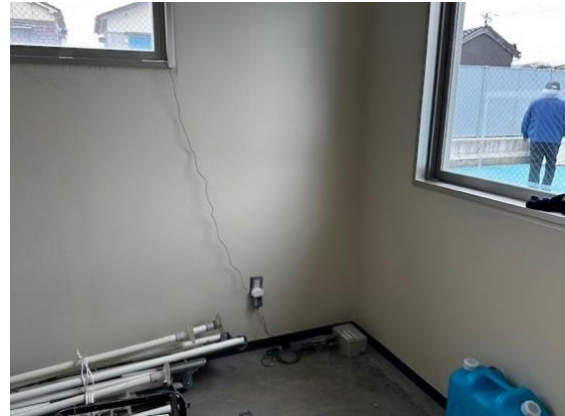
写真 4. 4-19 強震計設置状況 (WJMK1 : 北西側、CV374_149)
