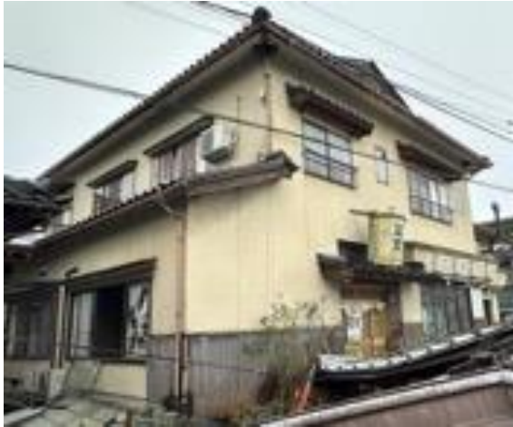
写真5. 2. 2-40 比較的建築年が古い割に被害が軽微な木造家屋
