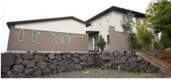
写真5. 2. 2-78 外観上無被害の木造住宅
