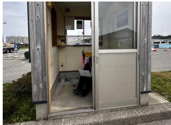
写真 4.4-16 強震計設置状況 (WJMM、CV374_143)
