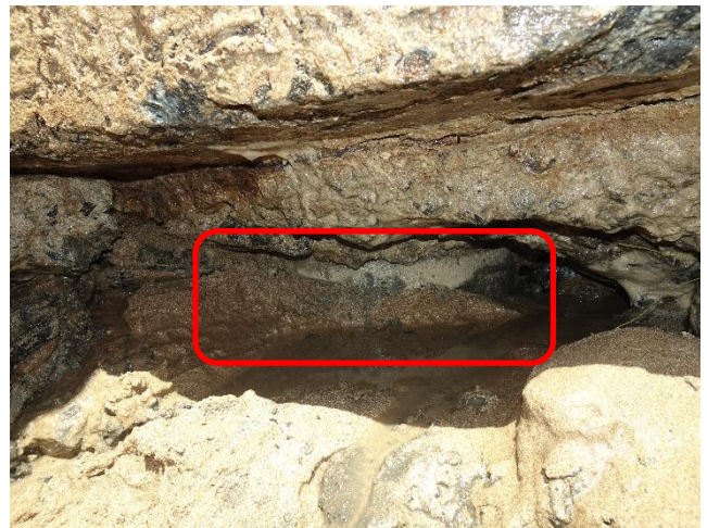
写真 5. 3. 2-40 杭頭部の状況 (D-2①)
