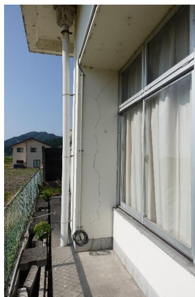
写真 5.3.2-185 柱の縦ひび割れ
