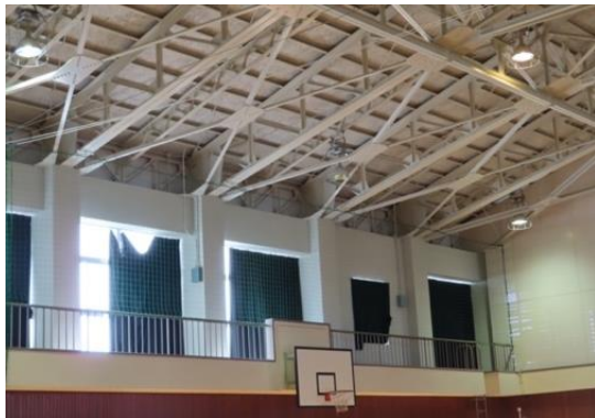
写真 5.5-133 平側のRC造柱の柱頭とトラス梁の接続部（支承部）の状況
