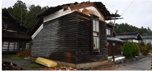
写真5. 2. 2-79 土蔵の被害
