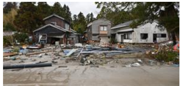
写真5. 2. 2-71 津波により流失した木造住宅1
