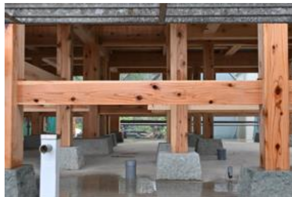
写真5.2.2-77 写真 5.2.2-76 の束と礎石部分
