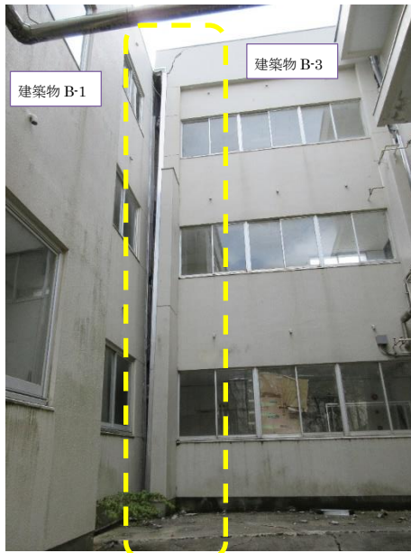
写真 5.3.2-22 建築物 B-1 と B-3 の間の Exp. J. の被害
