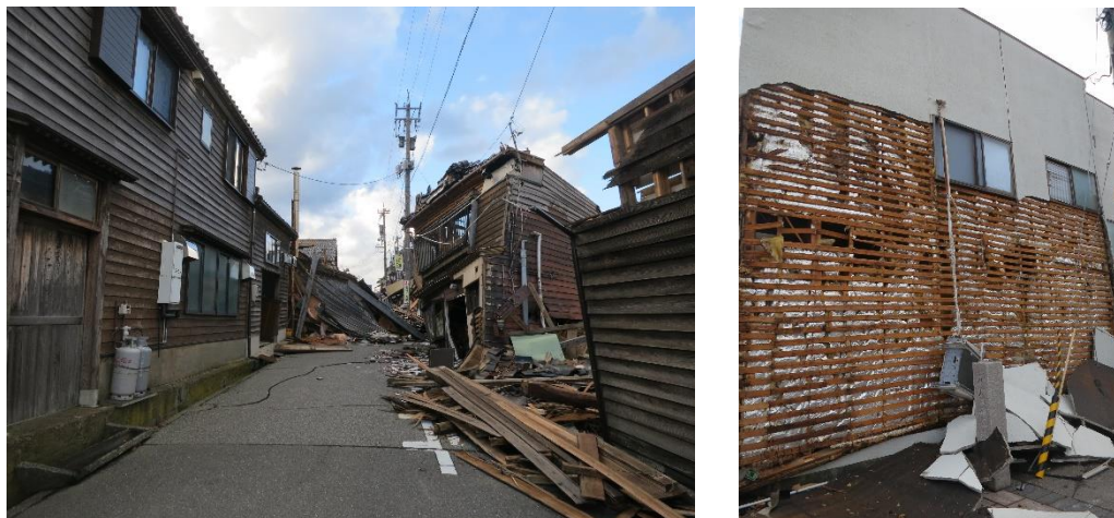
写真 6.2-1 焼失した区域周辺の市街地の様子
