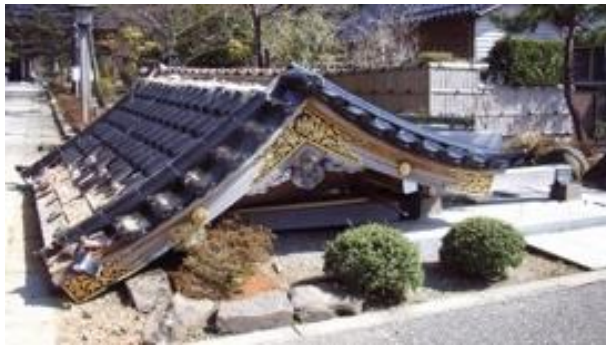
写真5. 2. 2-19 2007年地震時の倒壊（左：'07年撮影）後に再建された手水処の倒壊
