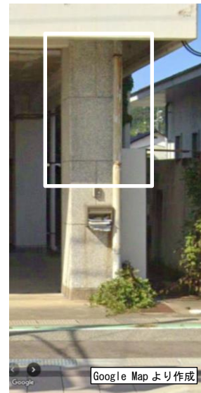
d) 地震前（2023年10月）5.4-6より作成の状況 （□部が写真cで沈下後に露出した部分）
