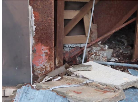
写真 5.5-111 柱の錆
