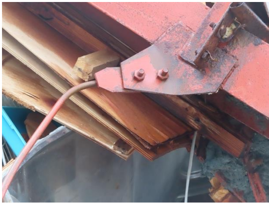
写真 5.5-7 ターンバックルブレース接合部分
