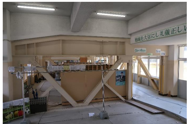
写真 5.3.2-27 建築物 C-1 梁間方向耐震補強
