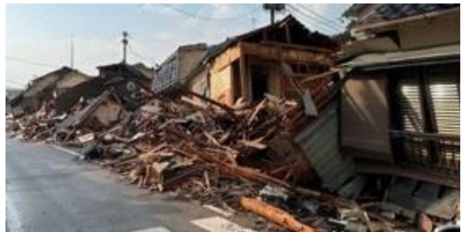
写真5. 2. 2-8 鳳至町の倒壊家屋群
