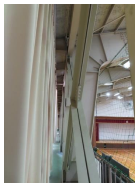
写真 5.5-140 第一体育館 山形鋼ブレース (2 丁合わせ)
