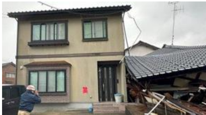
写真5.2.2-60 築年数が浅い外観上無被害の家屋 （左の住宅は隣家の倒壊のため応急危険度「危険」判定）
