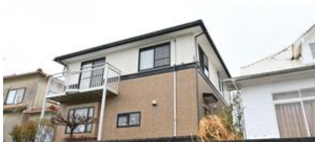
写真5.2.2-86 七尾市の2階建枠組壁工法住宅 (1996年竣工)
