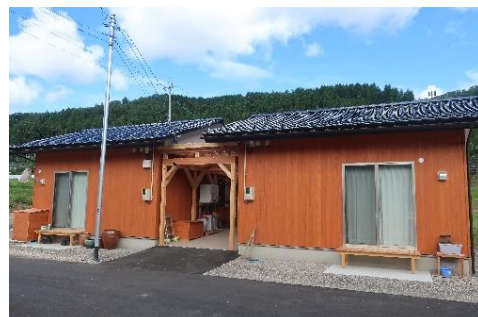
木造・ふるさと回帰型（穴水町内）
