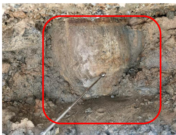
写真 5.3.2-174 未損傷の杭頭部 (13A の箇所)
