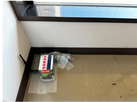
写真 4. 4-10 強震計設置状況 (WJMC5 : 南西側 2 階、Sonas No.4)
