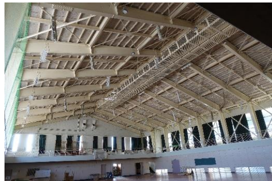
写真 5.5-144 第二体育館 内観
