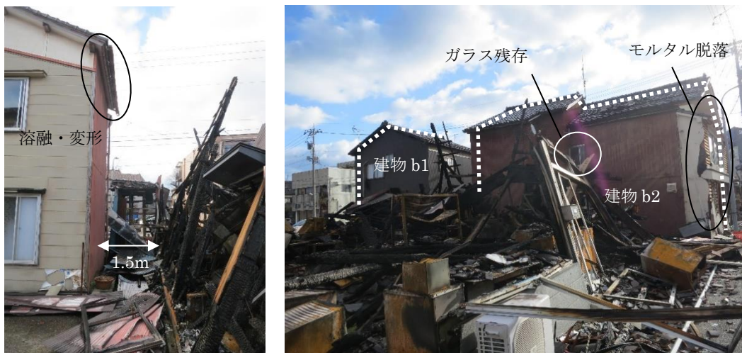
(ア) 北側から西面を見た様子
