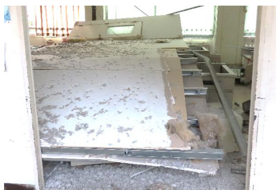
写真 5.6.2.(2)-13 校舎 3階間仕切壁の被害（上ランナごと脱落して転倒） (WA-111：輪島市、教育施設)
