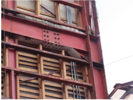
写真 5.5-110 柱梁接合部
