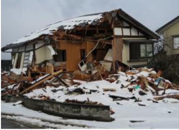
写真5.2.2-44 倒壊した木造住宅
