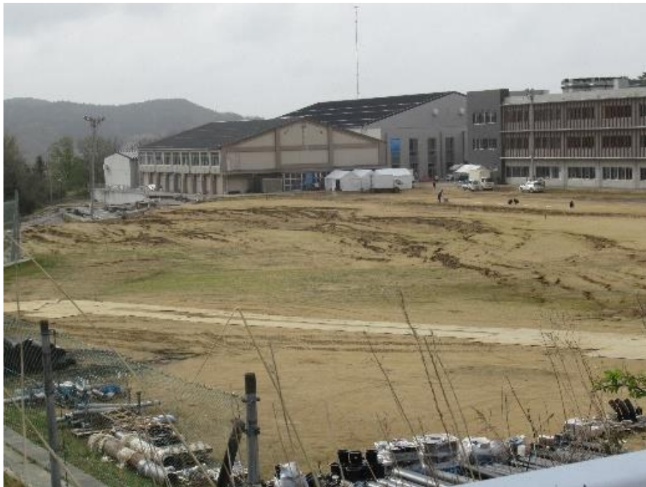
写真 5.3.2-192 建築物 O 敷地周辺地盤の変状
