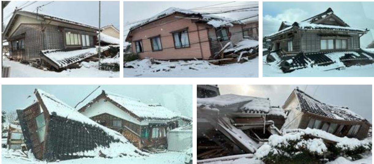
写真5.2.2-20 門前町道下・館の倒壊家屋群
