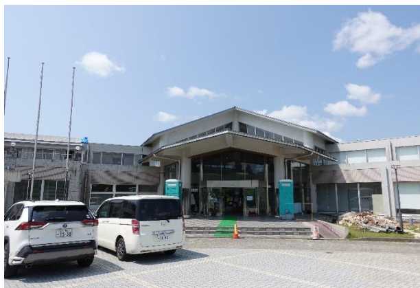
写真 5.3.2-71 J-1 棟北側外観
