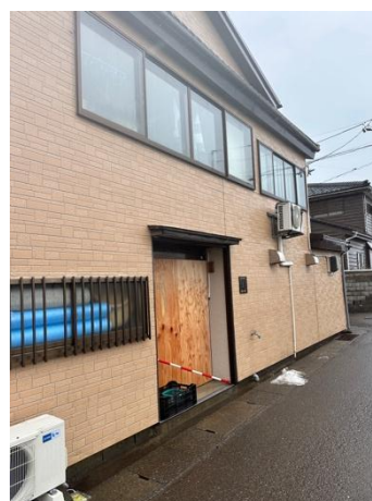
写真 5.7-3 浸水したと見られる住宅
