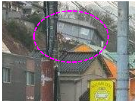
写真5. 2. 2-5 斜面崩壊による被害の可能性のある家屋
