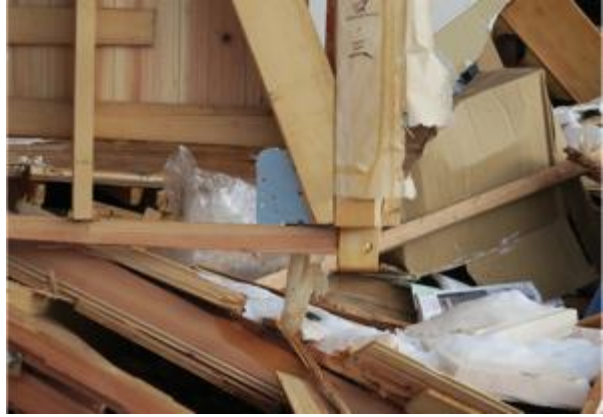
写真5.2.2-45 写真5.2.2-44の筋かい端部の金物
