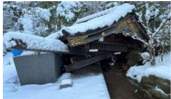
写真5. 2. 2-19 2007年地震時の倒壊（左：'07年撮影）後に再建された手水処の倒壊
