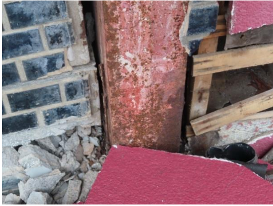
写真 5.5-35 柱の錆
