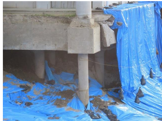
写真 5.3.2-108 杭頭の露出
