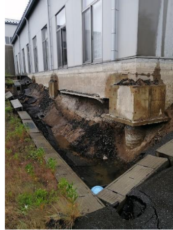
写真 5. 4. 2-44 E 中学校体育施設周囲地盤の変状に伴う被害
