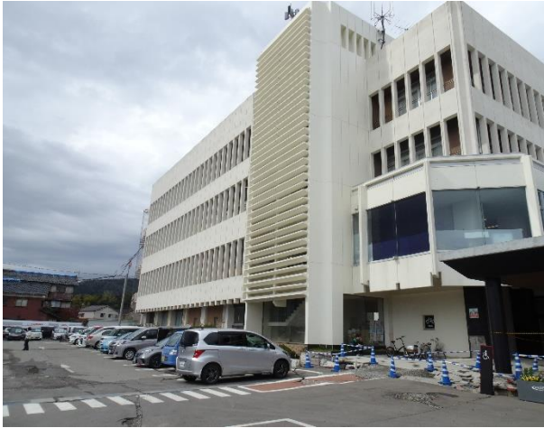
写真 5.3.2-44 建築物外観（北側）
