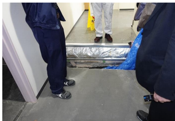
写真 5.3.2-2 Exp. J.の損傷①
