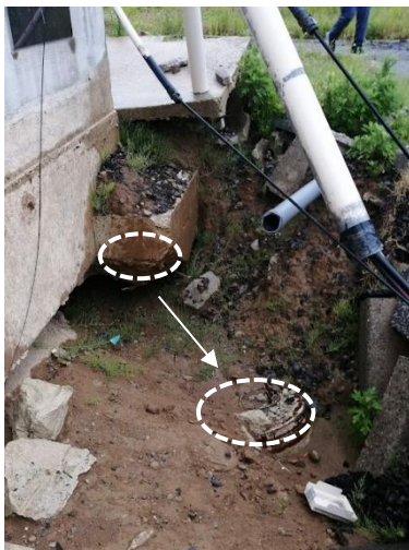
写真 5. 4. 2-48 I住宅の地盤被害の状況
