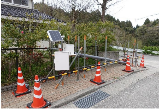
写真 5. 3. 2-188 地盤変位のモニタリング
