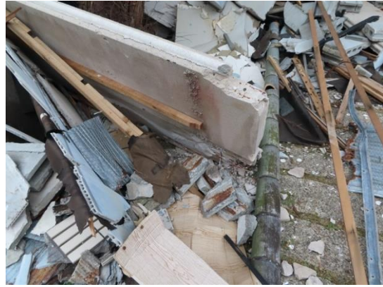
写真 5.5-105 ALC 外壁の脱落
