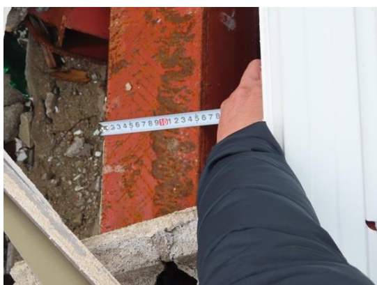
写真 5.5-19 柱外径（約 150mm）
