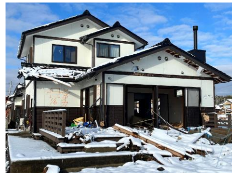
写真 5.7-14 流失を免れた建築物
