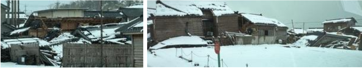
写真5. 2. 2-24 門前町黒島の倒壊家屋群
