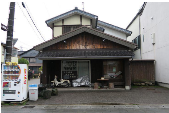
写真5. 2. 2-83 外観上無被害の木造店舗併用住宅
