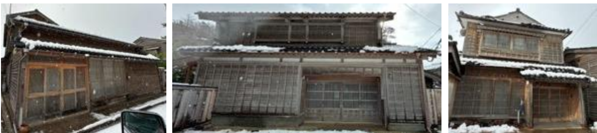
写真5. 2. 2-27 建築年が古い割に被害が軽微の家屋
