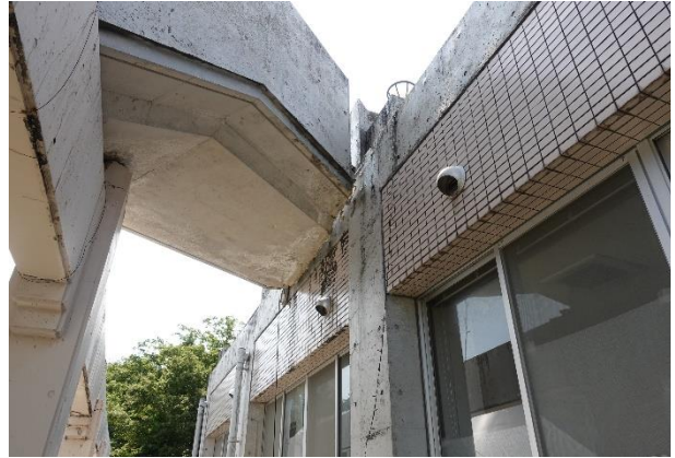
写真 5.3.2-79 外階段と J-3 棟主架構の分離
