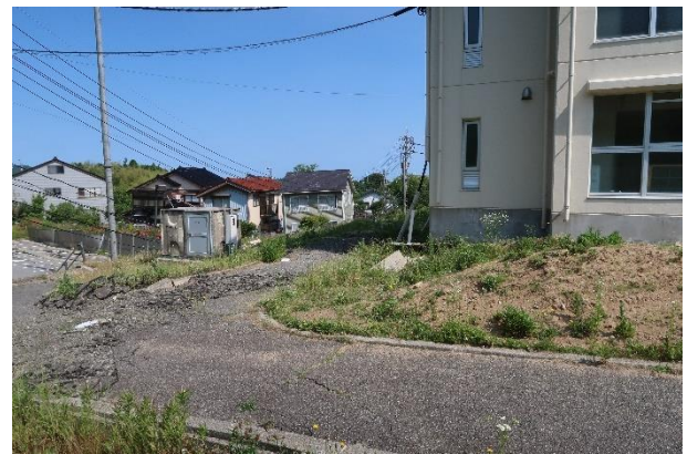
写真 5.3.2-53 西側の地盤変状
