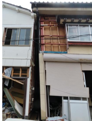
写真 5.5-21 建築物全体の傾斜と隣接建築物との接触
