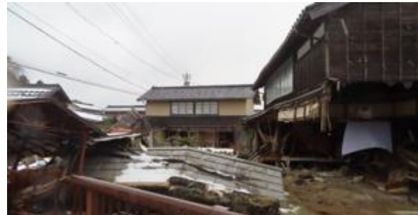
写真5. 2. 2-73 津波により倒壊した木造住宅
