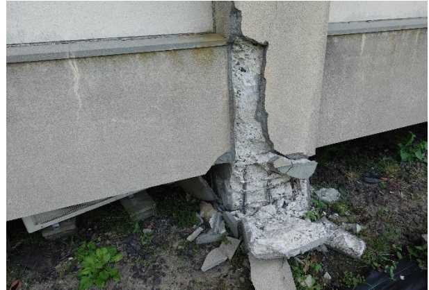
写真 5.3.2-177 東柱の損傷
