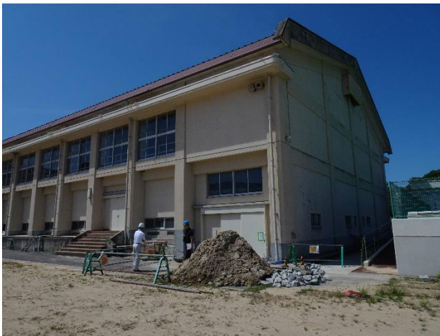
写真 5. 3. 2-39 建築物 D-3 北東側全景
