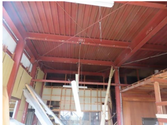
写真 5.5-71 柱梁接合部の状況
