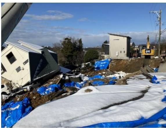
写真 5.4.2-2 崩壊した斜面の状況②
