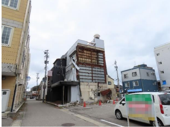
写真 5.5-100 外壁の脱落
