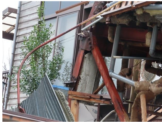
写真 5.5-8 1階の山形鋼ブレース
