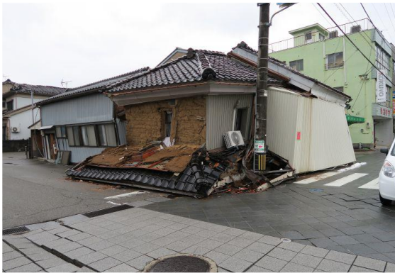
写真5. 2. 2-80 倒壊した木造住宅
