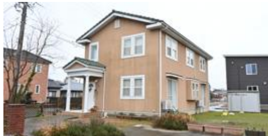
写真5.2.2-87 七尾市の2階建枠組壁工法住宅 (2000年竣工)
