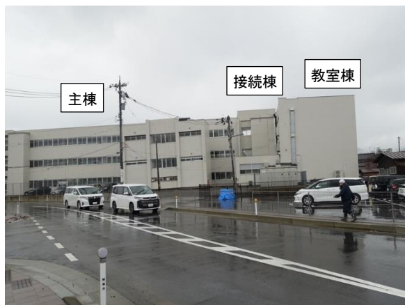
写真 5.4.2-35 C 小学校の外観
