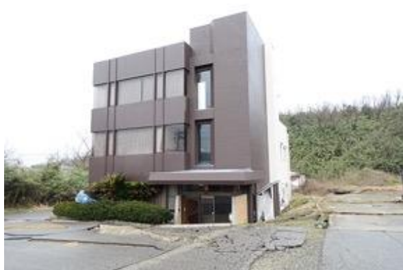
a) 被害状況（2024年1月時点）
