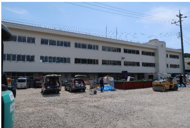
写真 5.3.2-26 建築物 C-1 北面外観
