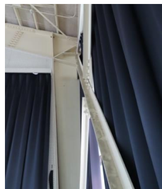
写真 5.5-148 第二体育館 山形鋼ブ レース (1丁)
