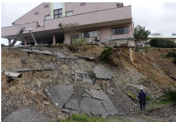
写真 5.3.2-196 杭頭及びパイルキャップの露出
