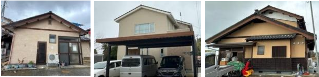
写真5.2.2-35 新耐震基準施行後の建築とみられる無被害又は被害軽微の家屋
