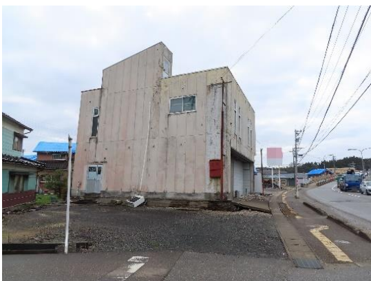
写真 5.5-72 建築物外観（側面）
