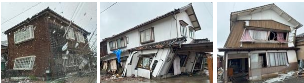
写真5.2.2-37 安全限界変形を超える残留変形がある家屋（珠洲市宝立町鶴飼）
