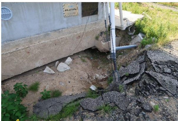
写真 5.3.2-54 南西端部の杭頭部露出
