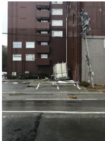
写真 5. 4. 2-45 F ホテルの地盤被害の状況
