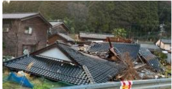
写真5. 2. 2-53 穴水町鹿島の倒壊家屋群
