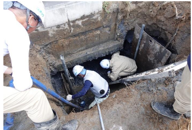
写真 5.3.2-7 杭基礎調査状況
