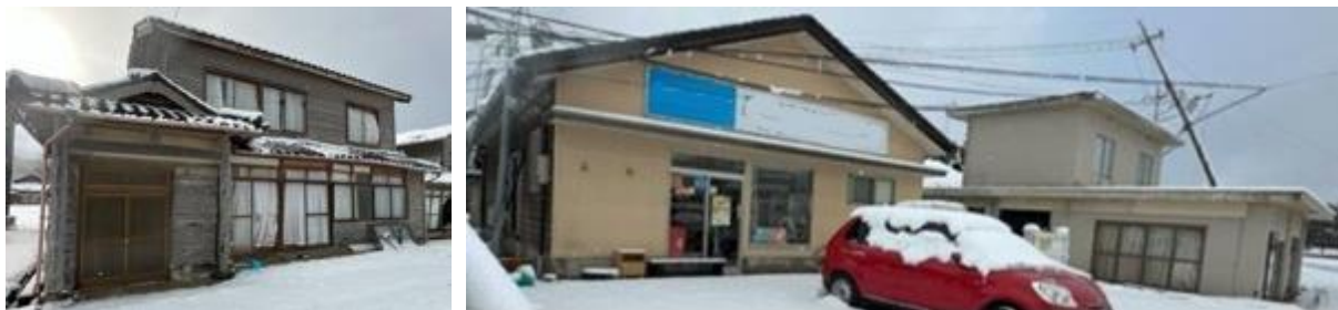
写真5.2.2-23 建築年が古い割に被害が軽微の家屋（右の写真の右側の建物はコンクリート造）
