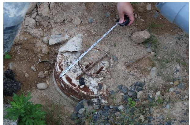
写真 5.3.2-55 露出した杭頭部断面
