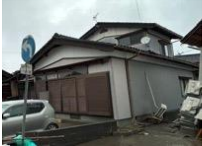
写真5. 2. 2-40 比較的建築年が古い割に被害が軽微な木造家屋
