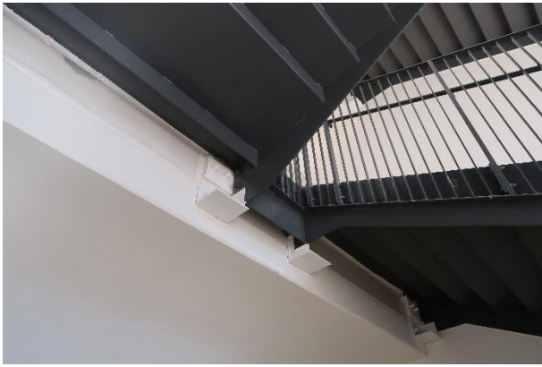
写真 5.3.2-118 建築物 O-1 鉄骨階段の接合部
