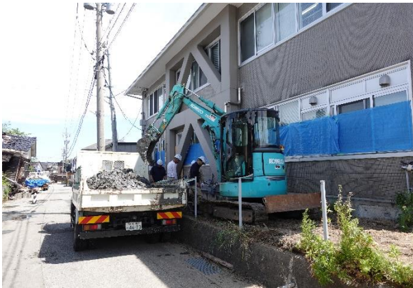
写真 5.3.2-6 杭基礎掘削状況
