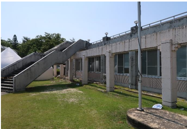
写真 5.3.2-76 J-3 棟北側外観
