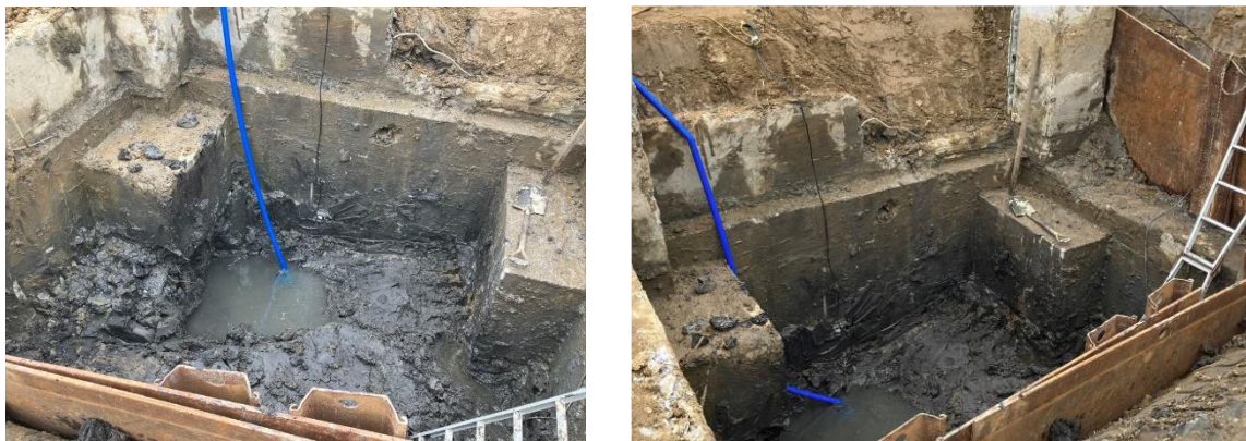
a) X2-Y3 パイルキャップ及び周辺部材
