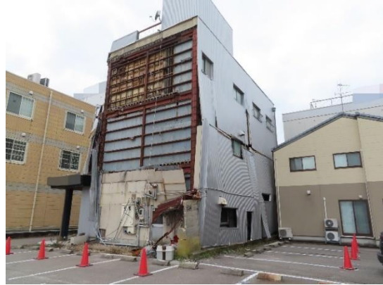
写真 5.5-101 外壁の脱落
