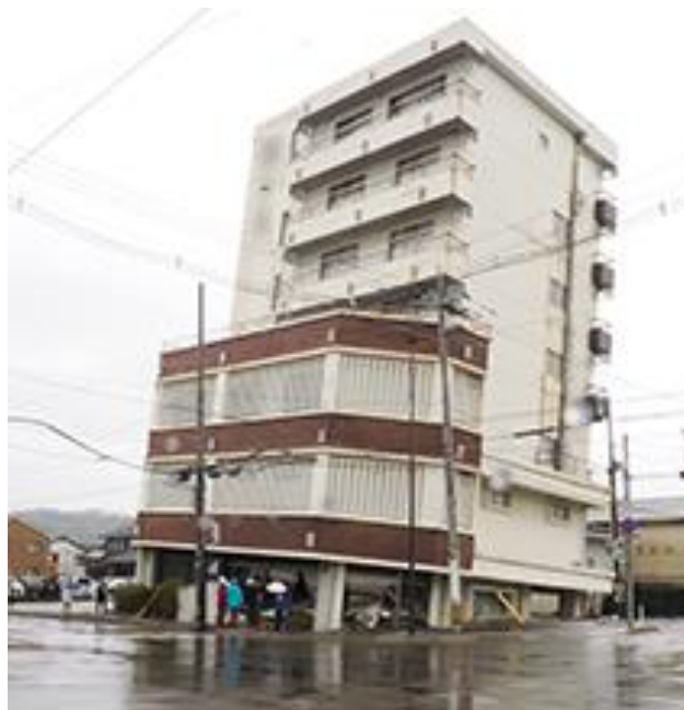
写真 5. 4. 2-20 建物全景 (南東側から撮影)
