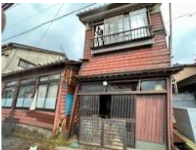
写真5. 2. 2-9 一部は安全限界変形を超えるような大きな残留変形のある住宅（鳳至町）
