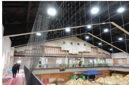
写真 5.6.2.(2)-2 屋内運動場 妻面（出入口方面）の内壁の広範囲な脱落（WA-102：輪島市、教育施設）
