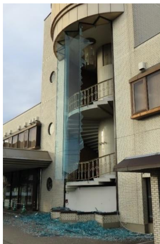
写真 5.6.2(4)-5 ガラススクリーンの被害 (WA-08：輪島市、葬儀場)
