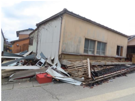
写真 5.5-15 1階の層崩壊
