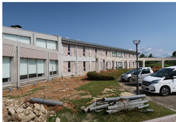
写真 5.3.2-72 J-2 棟東側外観
