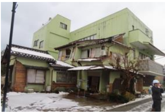
写真5. 2. 2-62 2階が損傷した木造住宅
