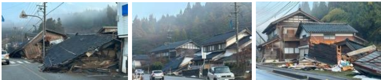
写真5. 2. 2-11 輪島市三井町で確認された倒壊家屋
