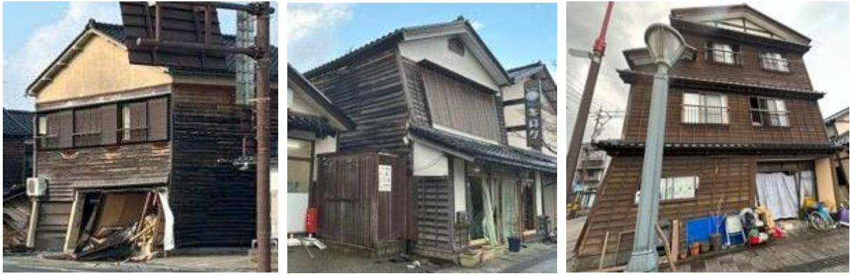
写真5. 2. 2-2 一部は安全限界変形を超えるような大きな残留変形のある家屋
