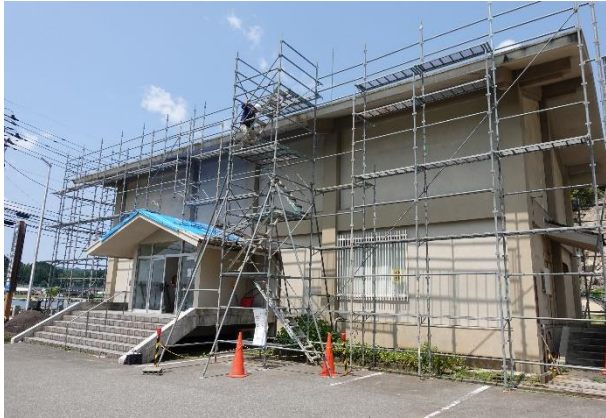
写真 5.3.2-176 建物南東側外観
