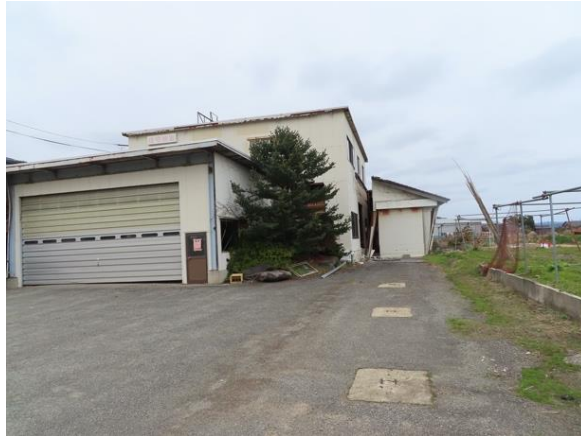
写真 5.5-69 外観（木造下屋部分の分離）
