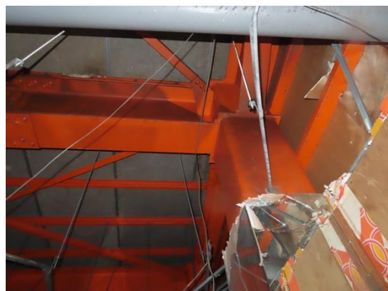
写真 5.5-99 柱、梁部材に明確な損傷無し
