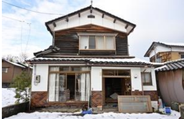
写真5.2.2-51 比較的健全な木造住宅
