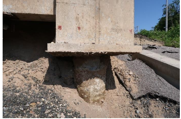
写真 5.3.2-111 建築物 O-3 南西角の基礎露出
