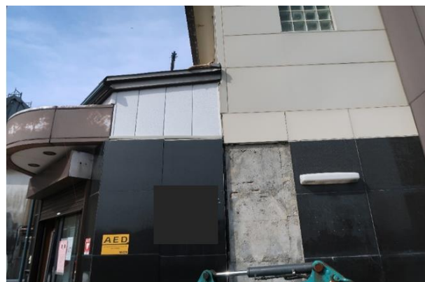
写真 5.3.2-146 入口部と本棟の接合部
