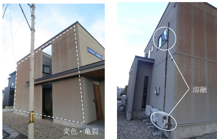
(ア) 南東側から見た建物全景
