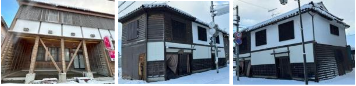
写真5.2.2-15 無被害、又は被害軽微と見受けられる比較的新しい木造家屋（門前町門前）
