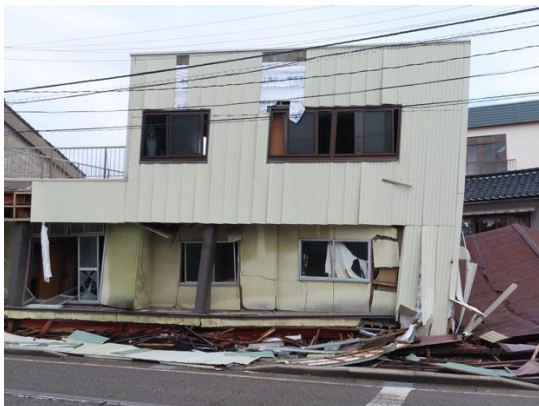
写真 5.5-9 1階の層崩壊（正面）
