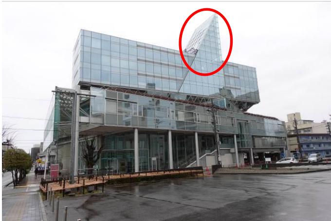
写真 5.6.2(4)-9 外観(丸は外壁被害のあった三角形部分) (建築物 N：富山市、行政庁舎)
