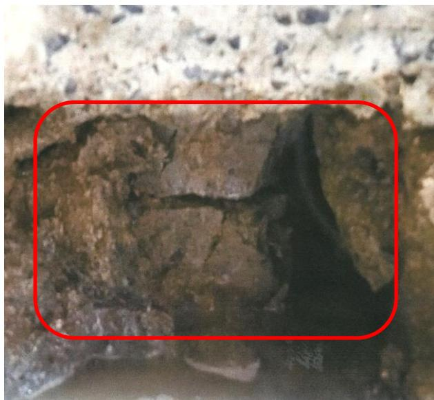
写真 5.3.2-41 杭頭部の損傷 (D-1①)
