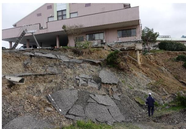
写真 5.3.2-196 杭頭及びパイルカップの露出
