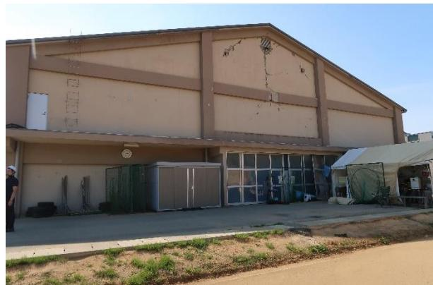
写真 5.3.2-113 建築物 O-4 東妻面の損傷
