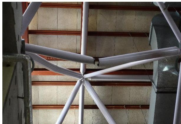
写真 5.3.2-103 システムトラス屋根の主部材の座屈及び破断
