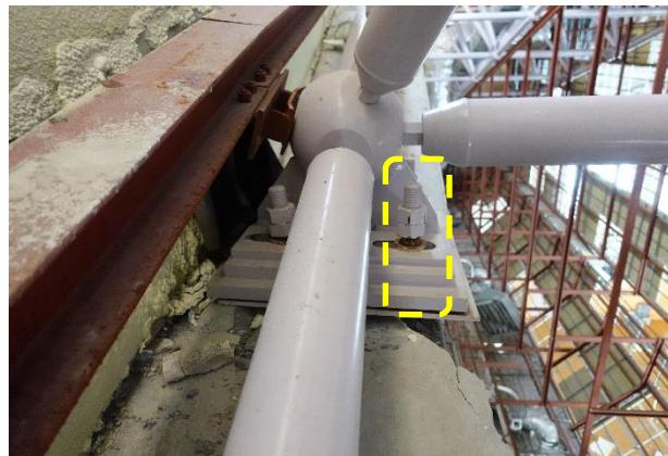
写真 5.3.2-99 屋根支承部のアンカーボルトの伸び
