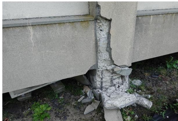
写真 5.3.2-177 東柱の損傷
