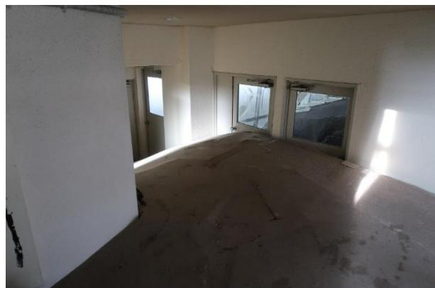
写真 5.3.2-134 Y2~Y3 構面 1階床の膨れ上がり
