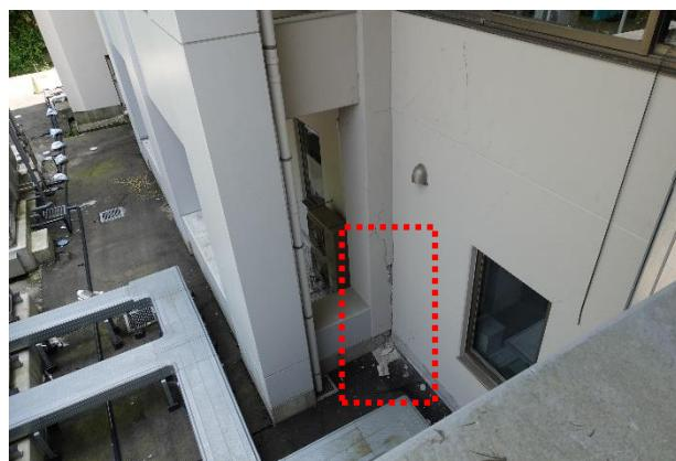
写真 5.3.2-67 柱のひび割れ
