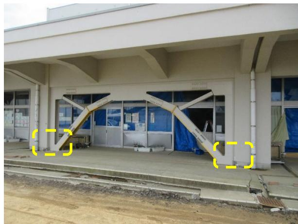
写真 5.3.2-19 建築物 B-2 の鉄骨ブレース補強
