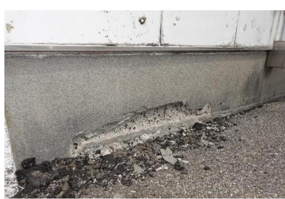
写真 5.3.2-137 上部構造基部のコンクリートの剥落 (建物 AC-1)
