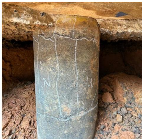
写真 5.3.2-122 杭の損傷状況 (③)
