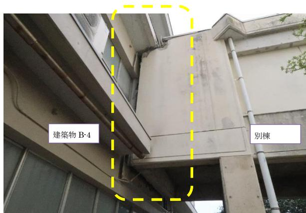
写真 5.3.2-24 建築物 B-4 と別棟の間の Exp. J. の被害
