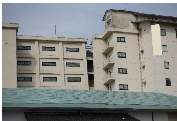
写真 5.3.2-164 西側棟の傾斜による Exp.J.の被害
