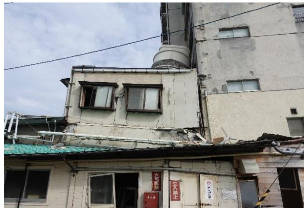
写真 5.3.2-166 西側棟の傾斜による北側 2 階
