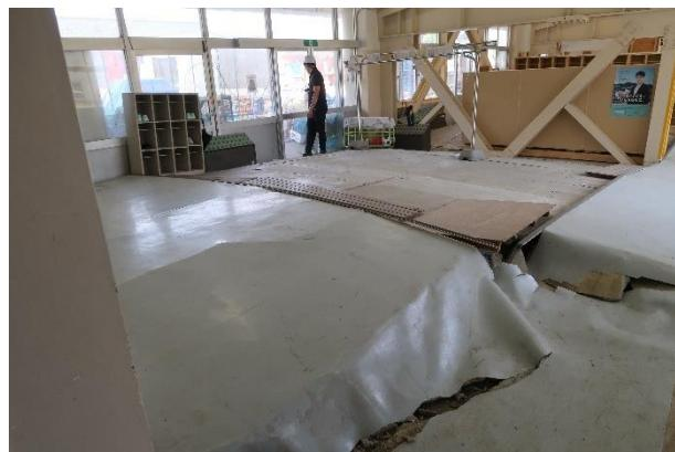
写真 5.3.2-29 建築物 C-1 1 階床面の起伏
