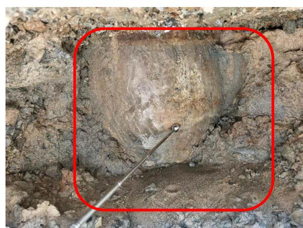
写真 5.3.2-174 未損傷の杭頭部
