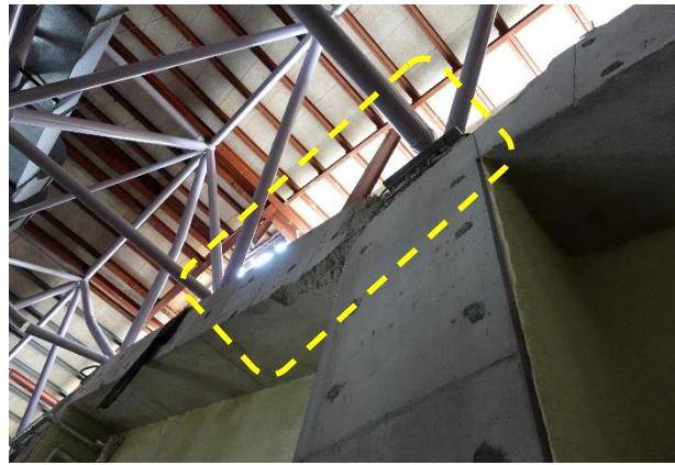
写真 5.3.2-101 屋根支承部の接合部損傷
