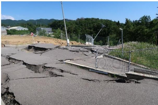
写真 5.3.2-112 建築物 O-4 南側の地盤変状
