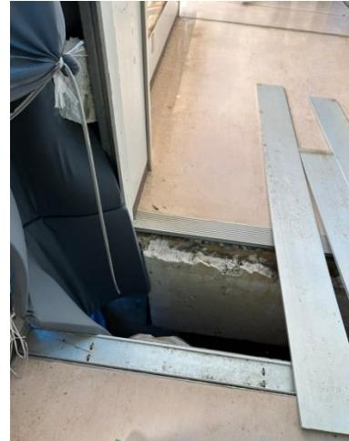
写真 5.3.2-120 Exp. J.の損傷
