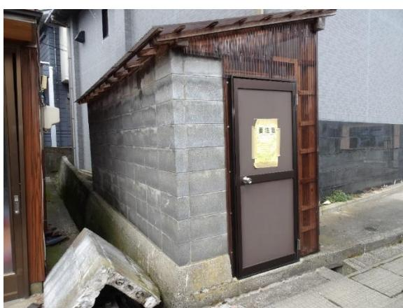
写真 5.3.2-92 建築物 L-2 の傾斜
