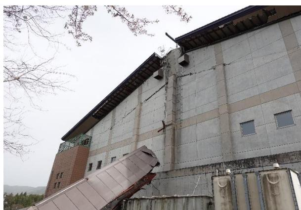
写真 5.3.2-96 妻構面の RC 造壁の面外破壊①
