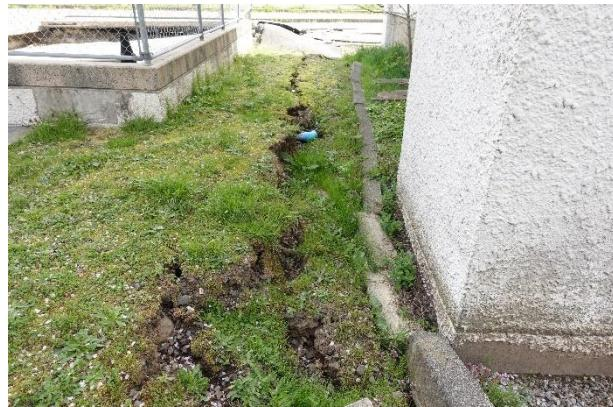
写真 5.3.2-142 建築物 AC-3 北側の地盤変状
