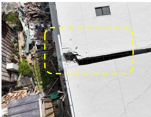
写真 5.3.2-126 西側壁面の損傷
