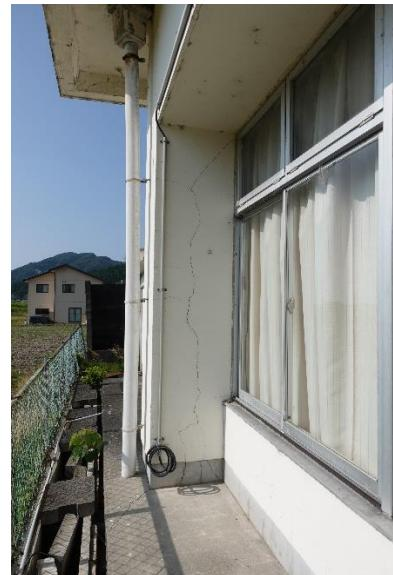
写真 5.3.2-185 柱の縦ひび割れ
