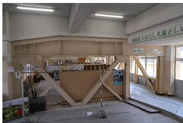
写真 5.3.2-27 建築物 C-1 梁間方向耐震補強
