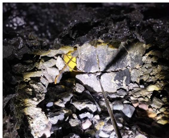
写真 5.3.2-173 杭頭部の損傷 (5G の箇所)
