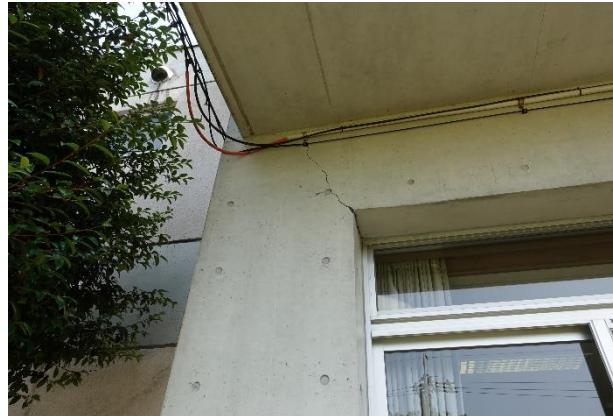
写真 5.3.2-81 梁端部の曲げひび割れ
