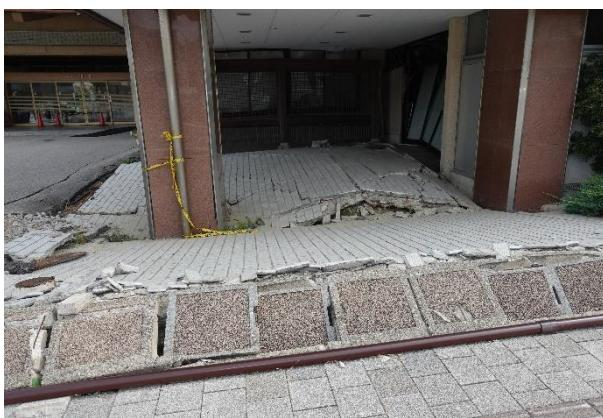
写真 5.3.2-159 AI-1 棟南側の地盤変状
