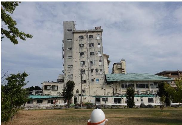
写真 5.3.2-165 西側棟の傾斜
