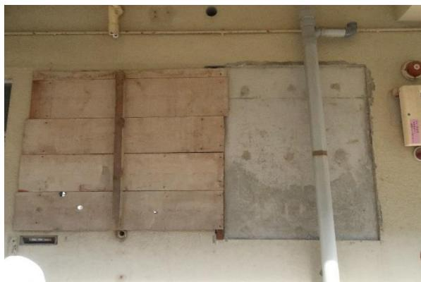
写真 5.3.2-149 施工途中の開口閉塞補強
