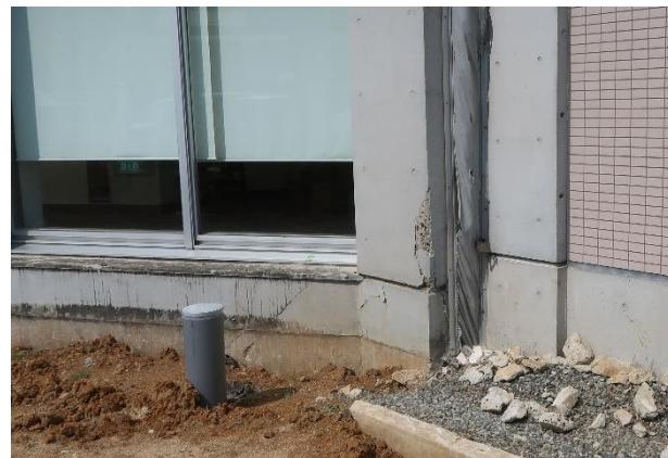
写真 5.3.2-74 1 階柱脚の被害 (J-1 棟)
