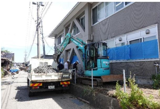
写真 5.3.2-6 桁基礎掘削状況
