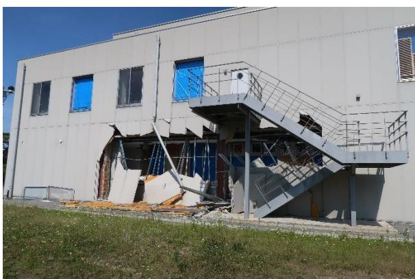
写真 5.3.2-114 建築物 O-2 の西面の外装損傷
