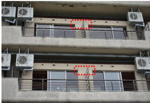
写真 5.3.2-170 西側棟方立壁の曲げひび割れ
