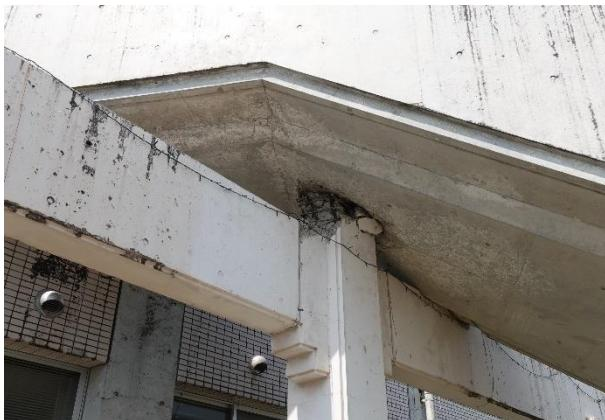
写真 5.3.2-78 外階段一柱接合部の損傷
