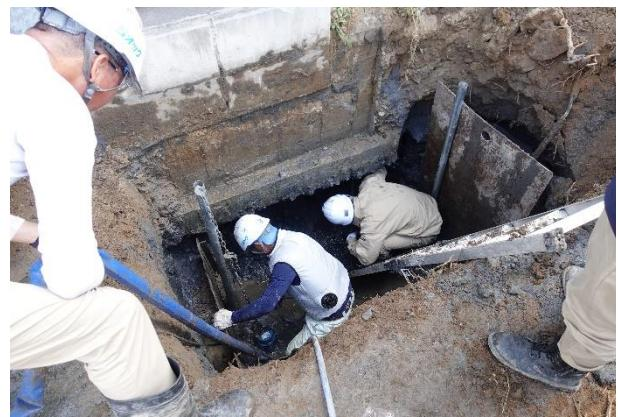
写真 5.3.2-7 桁基礎調査状況
