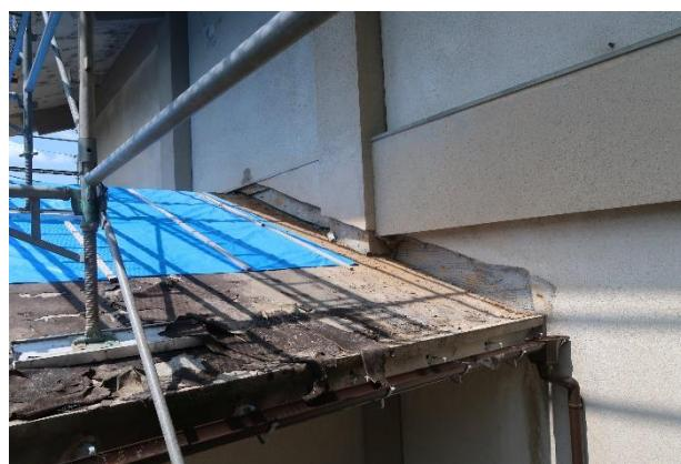
写真 5.3.2-179 外壁等の仕上げ材の剥落
