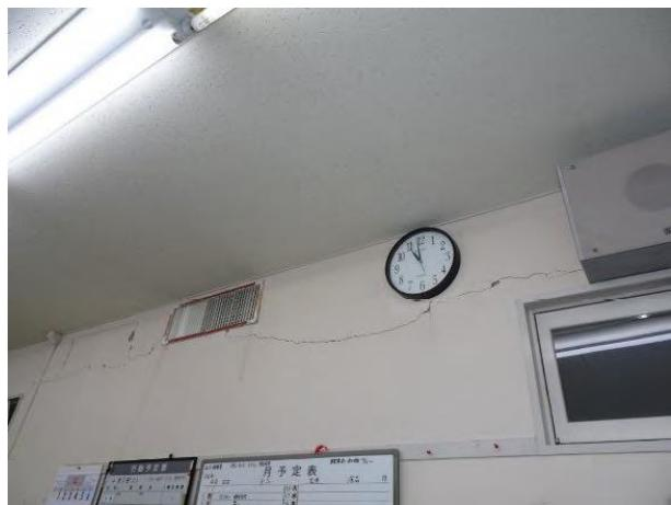
写真 5.3.2-182 壁のひび割れ (AN-1)
