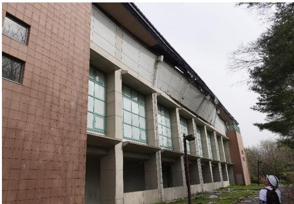
写真 5.3.2-98 平構面の RC 造壁の面外破壊
