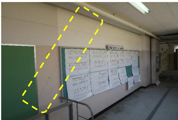
写真 5.3.2-34 建築物 C-3 耐力壁のひび割れ
