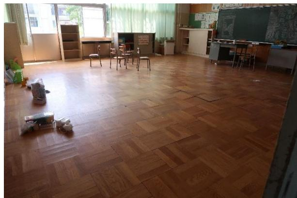
写真 5.3.2-35 建築物 C-4 床面の盛り上がり
