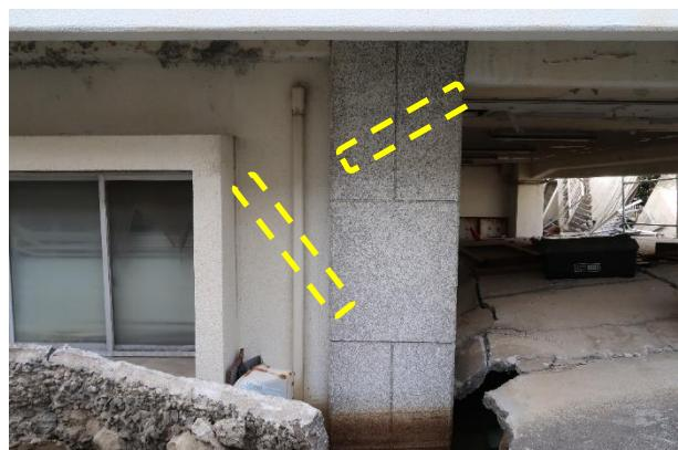
写真 5.3.2-132 X4-Y3 柱の損傷
