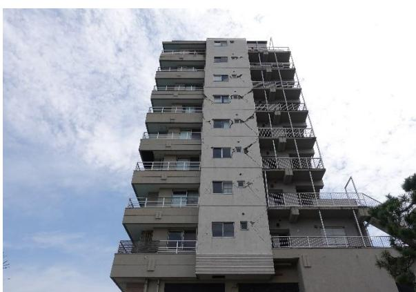
写真 5.3.2-161 AI-2 棟 方立壁のせん断破壊
