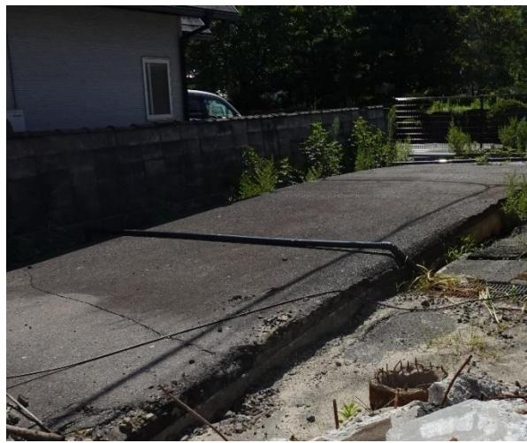
写真 5.3.2-175 応急復旧した排水管
