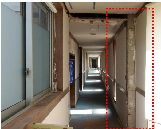
写真 5.3.2-73 J-1 棟-J-2 棟間の Exp. J. 部の損傷状況
