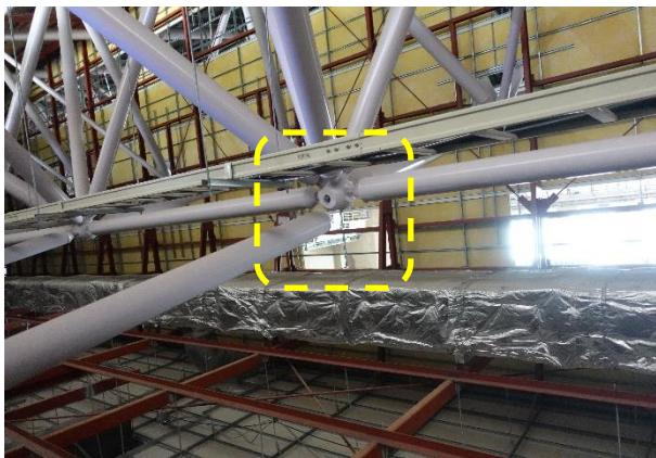
写真 5.3.2-102 システムトラス屋根のポールジョイント部での破断
