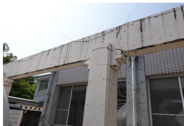
写真 5.3.2-77 柱頭部の曲げひび割れ
