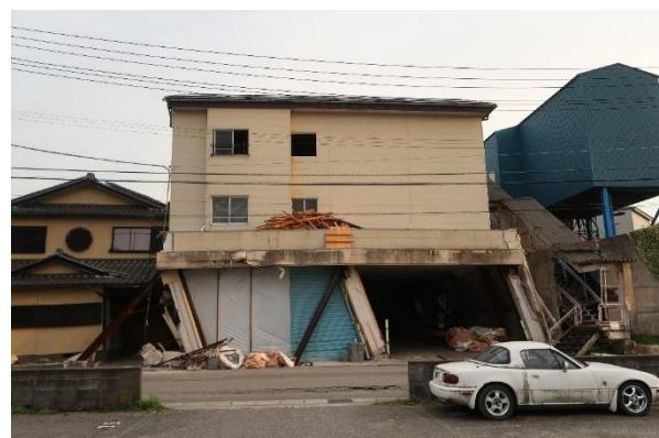
写真 5.3.2-150 隣接する鉄骨造住宅の被害
