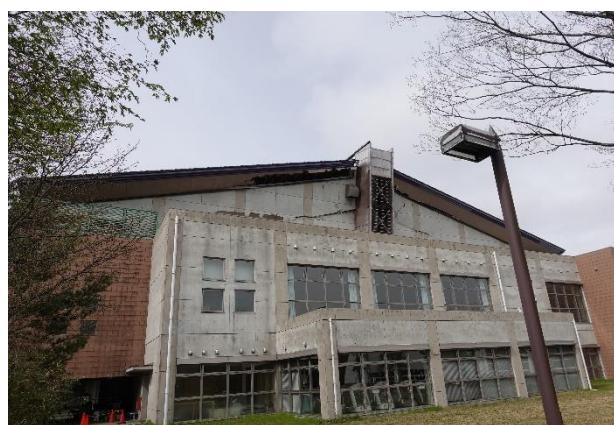
写真 5.3.2-97 妻構面の RC 造壁の面外破壊②
