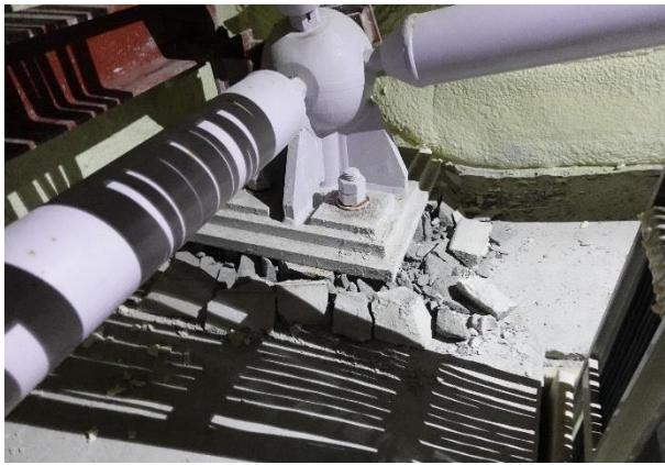
写真 5.3.2-100 屋根支承部のモルタルの損傷
