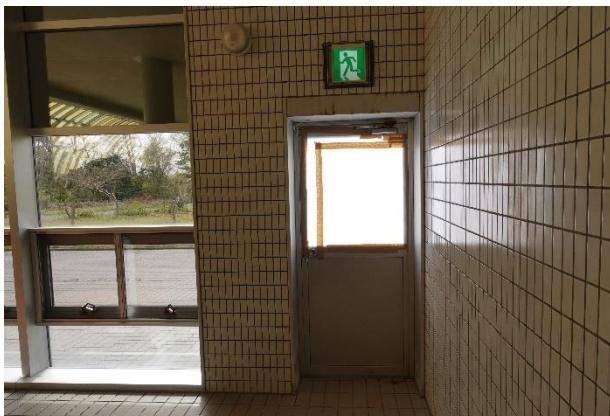
写真 5.3.2-105 建築物 M-2 のドアのガラスの割れ
