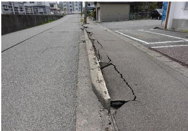
写真 5.3.2-138 建築物 AC-1 東側の地盤変状
