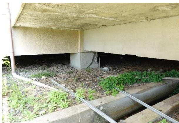
写真 5.3.2-178 東柱のせん断破壊
