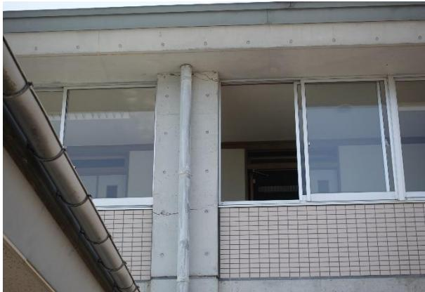
写真 5.3.2-80 2階柱の曲げによる損傷
