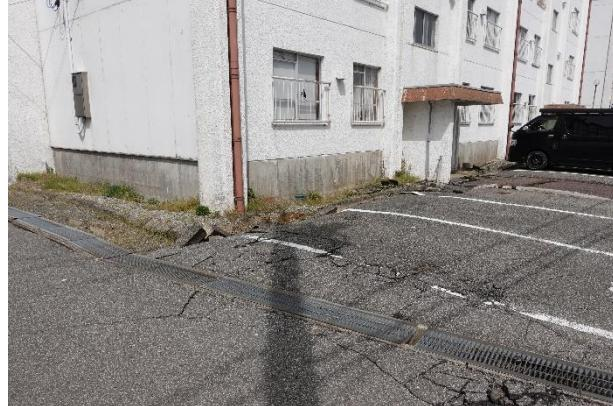
写真 5.3.2-140 建築物 AC-2 東側の地盤変状
