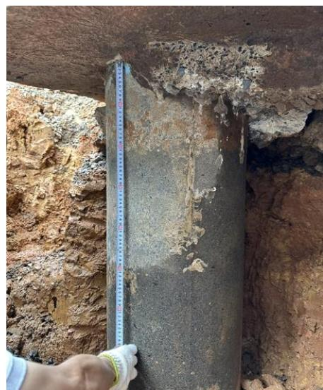
写真 5.3.2-123 杭の損傷状況 (④)
