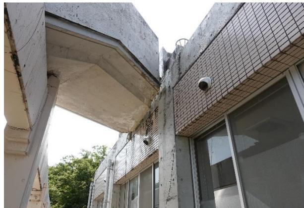
写真 5.3.2-79 外階段と J-3 棟主架構の分離
