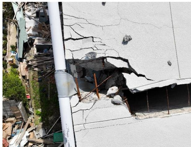
写真 5.3.2-127 西側壁面の損傷（拡大図）
