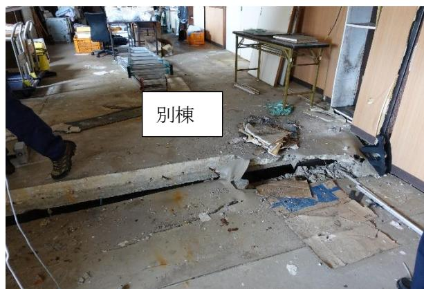
写真 5.3.2-160 AI-1 棟と別棟間の 1 階床損傷
