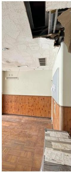
写真 5.3.2-119 P-2 棟の天井材落下
