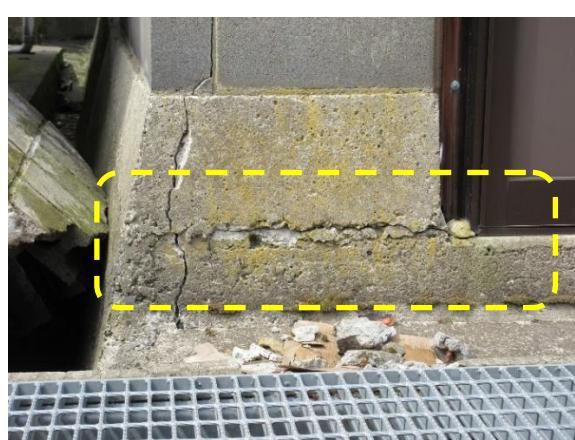
写真 5.3.2-93 建築物 L-2 基礎部の亀裂
