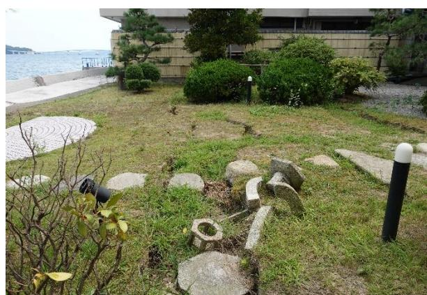
写真 5.3.2-162 AI-2 棟北西部の地盤変状
