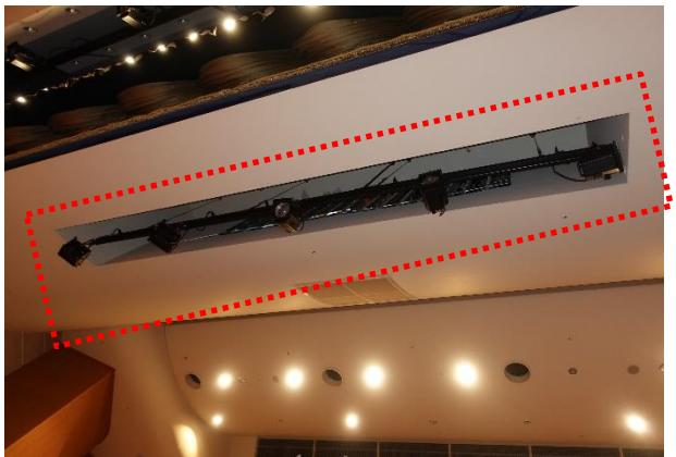
写真 5.3.2-84 落下した内装材が設置されている箇所
