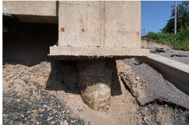
写真 5.3.2-111 建築物 O-3 南西角の基礎露出
