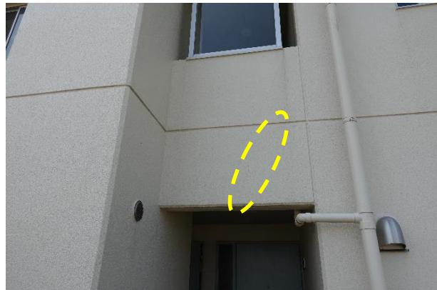
写真 5.3.2-59 西側階段室上部のひび割れ
