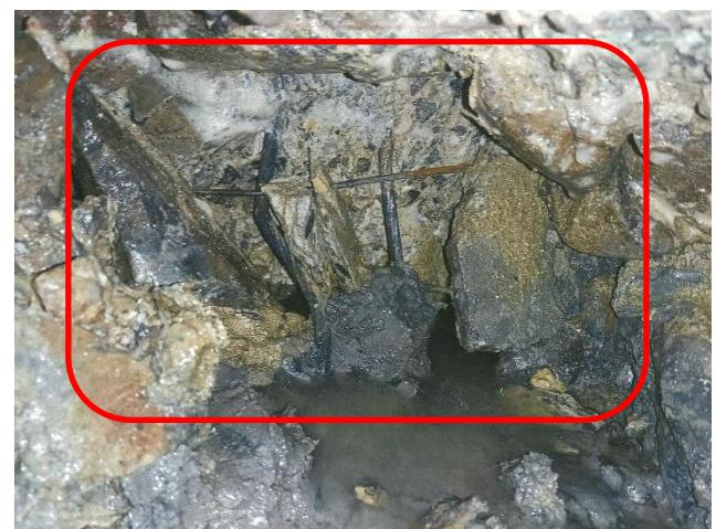
写真 5.3.2-42 杭頭部の損傷 (D-3②)
