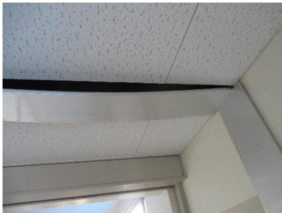
写真 5.3.2-109 Exp. J. の損傷
