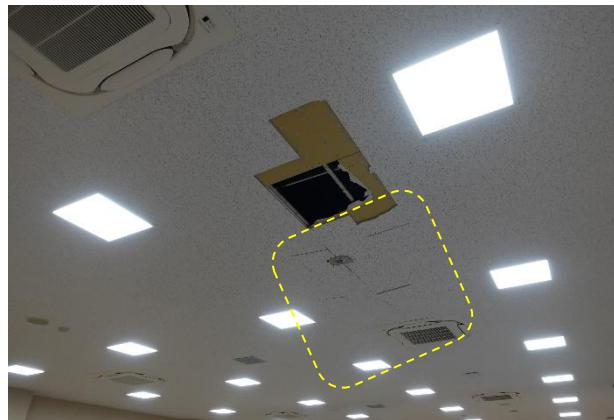
写真 5.3.2-69 天井材の変形
