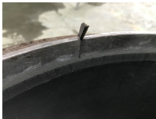
(b) 隙間部のシール材設置状況
