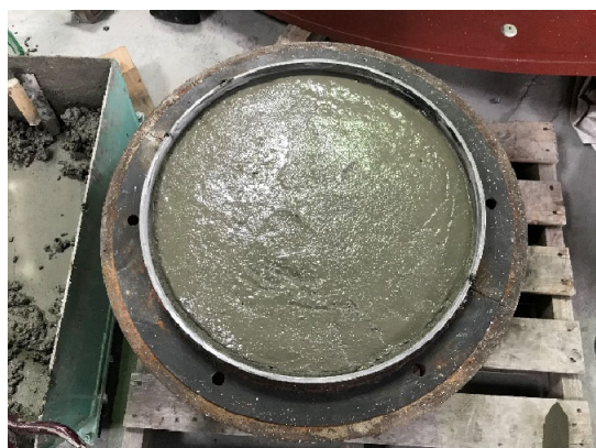
(c) 上側隙間部までのコンクリート打設状況
