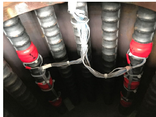
(b) ひずみゲージ設置状況
