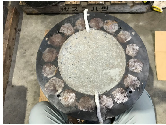
写真 2. 2. 6-11 B-2-3 上面のコンクリート 仕上げ状況
