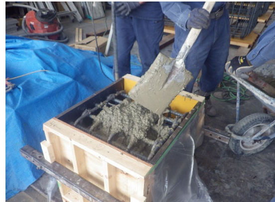
(d) コンクリート打設状況
