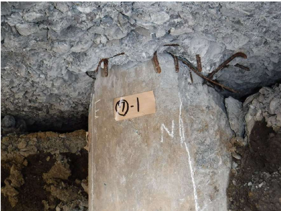
写真 7.4.2.32 杭⑦-1の杭頭部の状況
