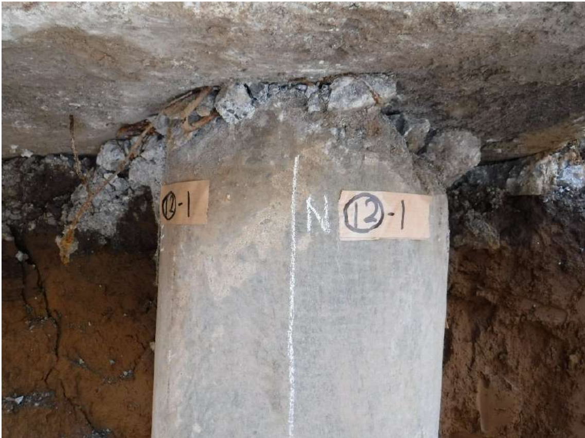
写真 7.4.2.39 杭⑫-1の杭頭部の状況
