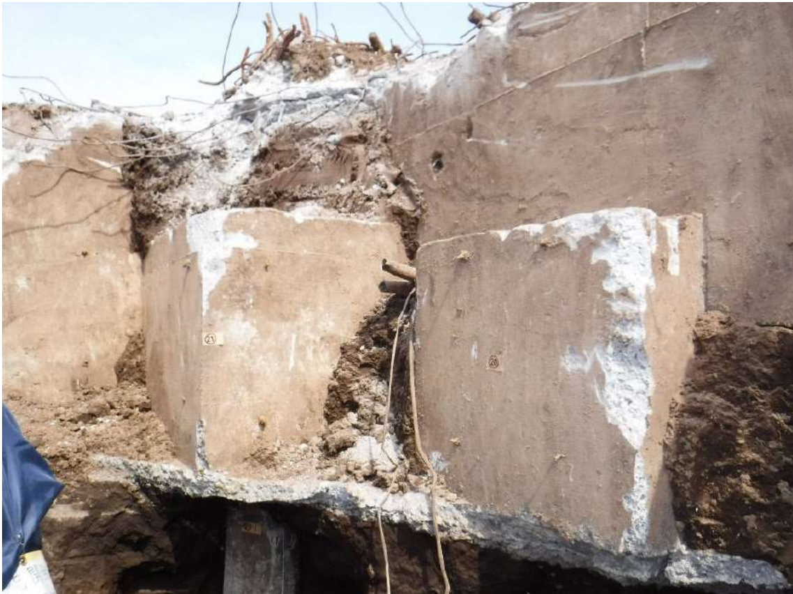
写真 7.4.2.23 基礎フーチング⑳および㉑周辺の状況
