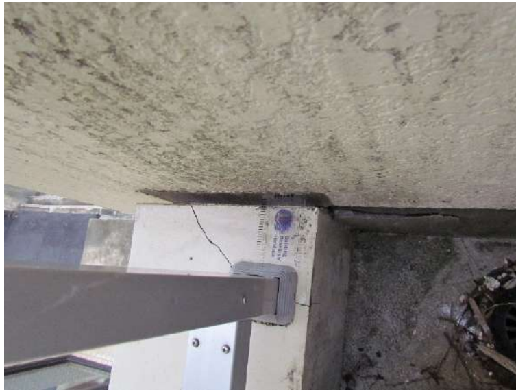
写真 7.4.1.5 境界梁の南側端部目開き量
