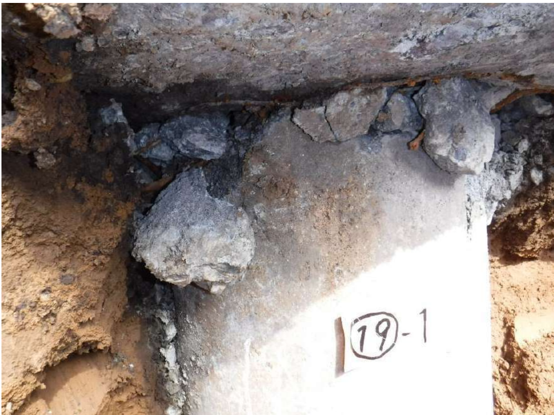
写真 7.4.2.50 杭⑲-1の杭頭部の状況
