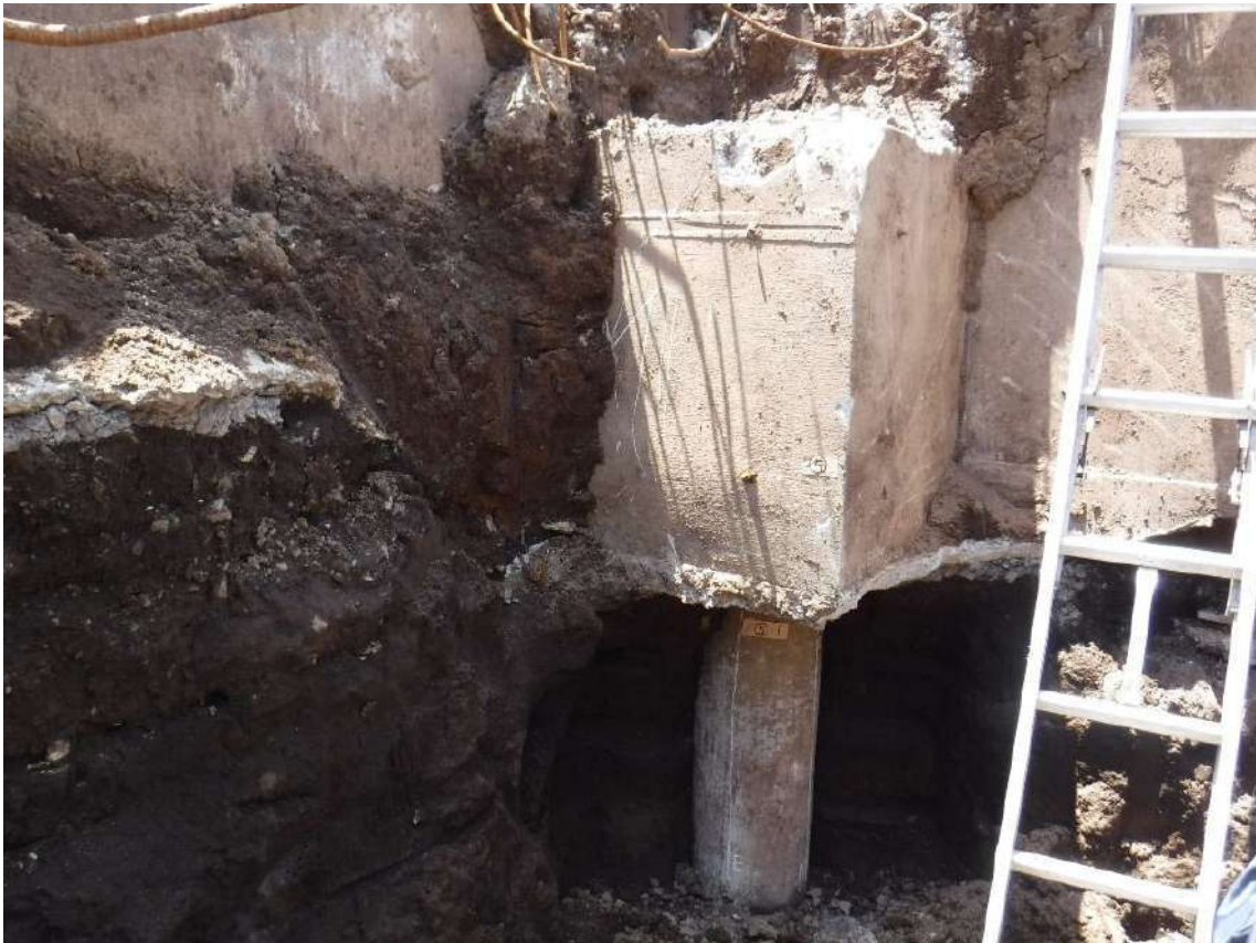
写真 7.4.2.7 基礎フーチング⑤周辺の状況
