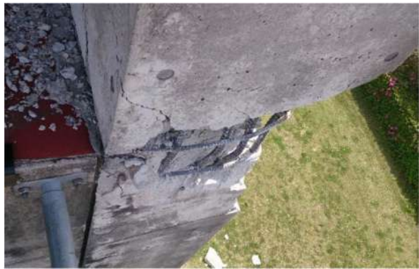
(b) 前震後の3階柱脚接合部周辺の損傷 (Ya2 構面, 図 3.2.4 における A 部分)
