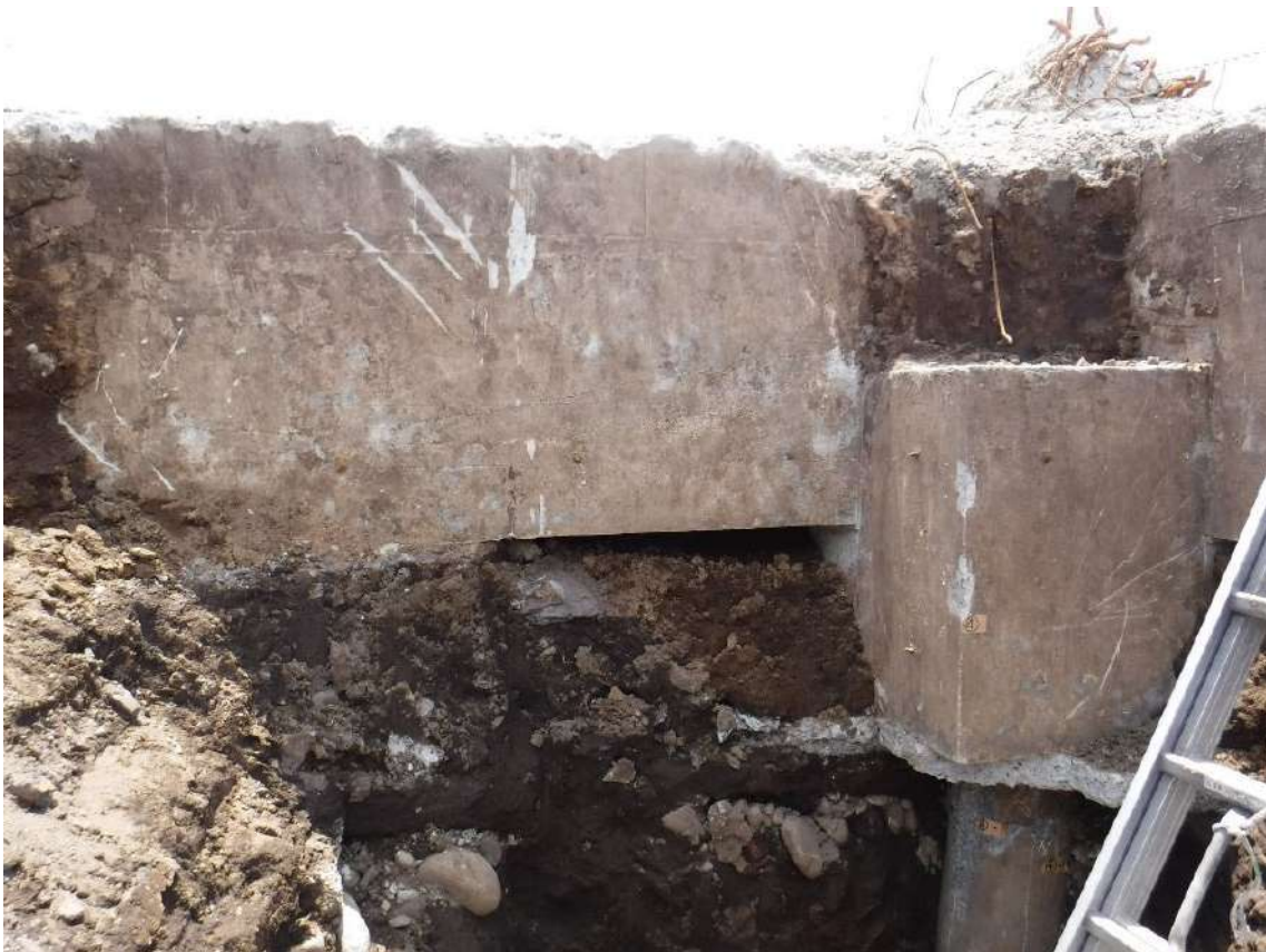
写真 7.4.2.6 基礎フーチング④周辺の状況
