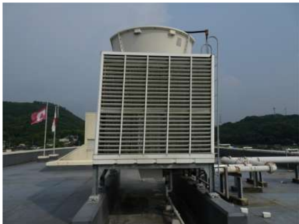
写真 8.4.3.22 傾斜した貯水槽
