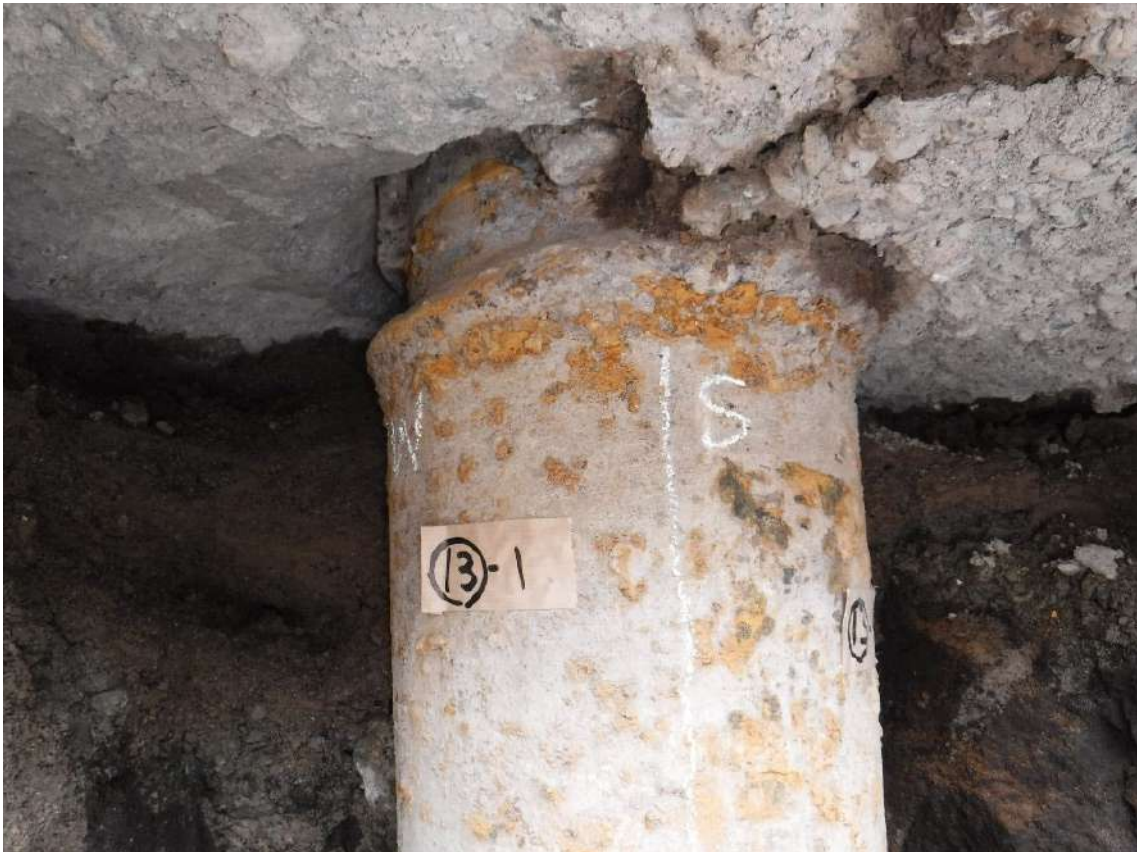
写真 7.4.2.41 杭⑬-1の杭頭部の状況
