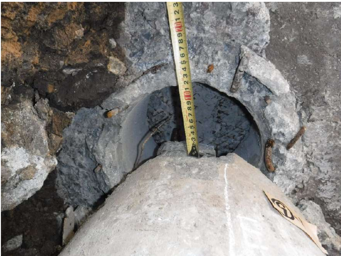
写真 7.4.2.36 杭⑨-1の杭頭部の状況
