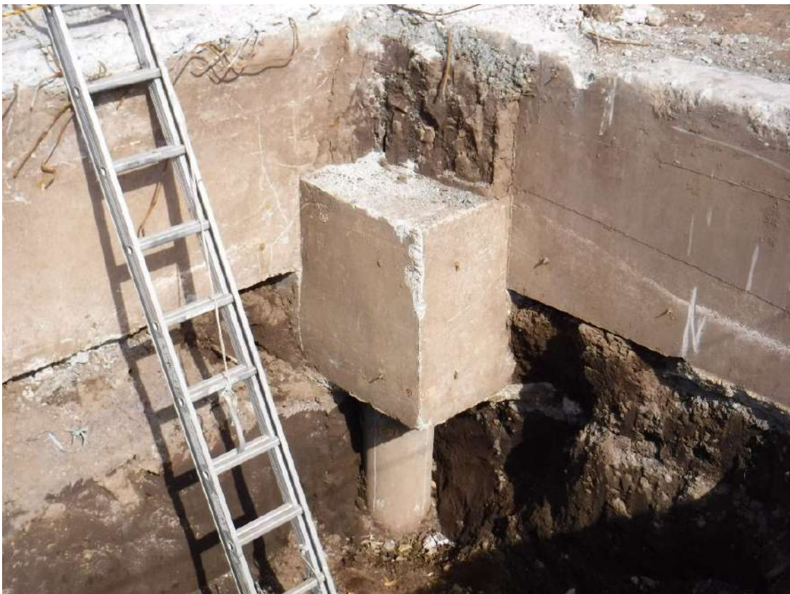
写真 7.4.2.4 基礎フーチング②周辺の状況
