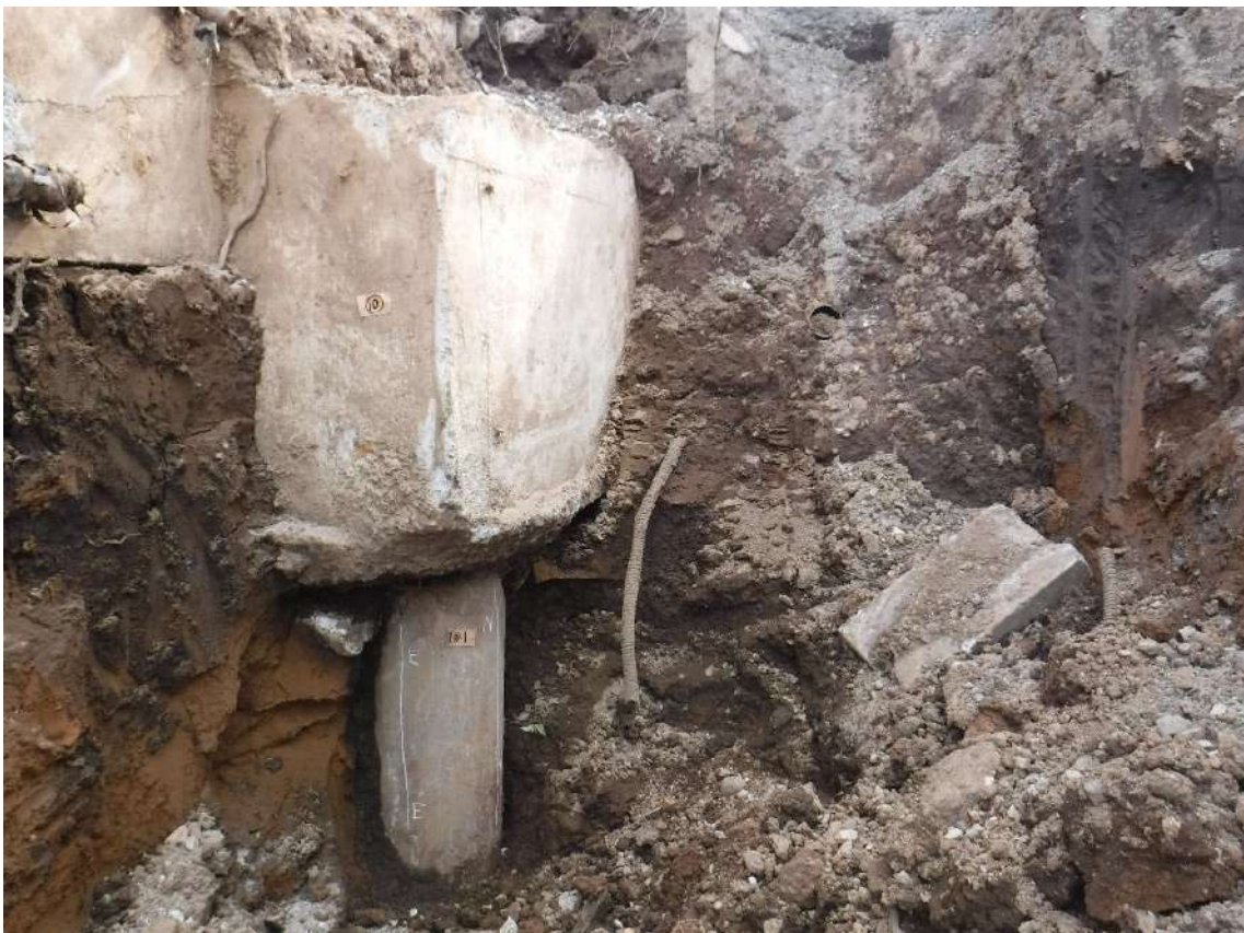
写真 7.4.2.14 基礎フーチング⑩周辺の状況
