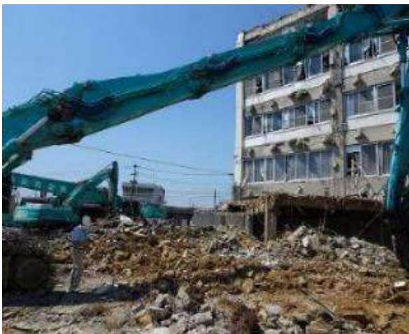
写真 9.2.1 解現場の状況
