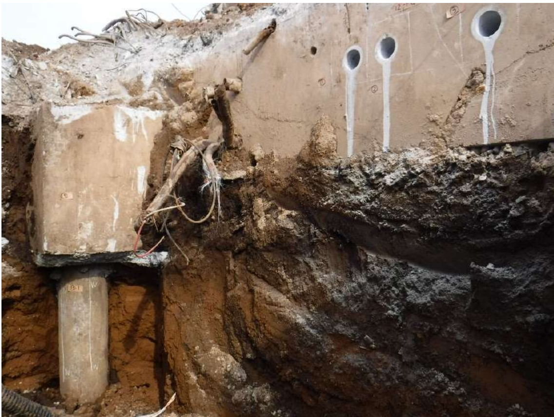
写真 7.4.2.22 基礎フーチング⑲周辺の状況
