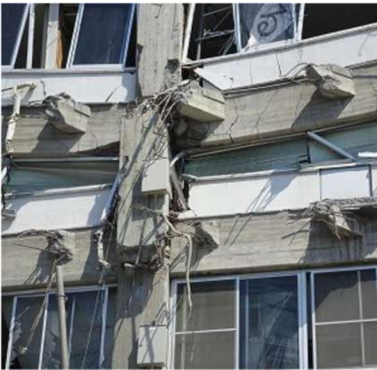
(c) 4, 5階十字形柱梁接合部 (西側面)
