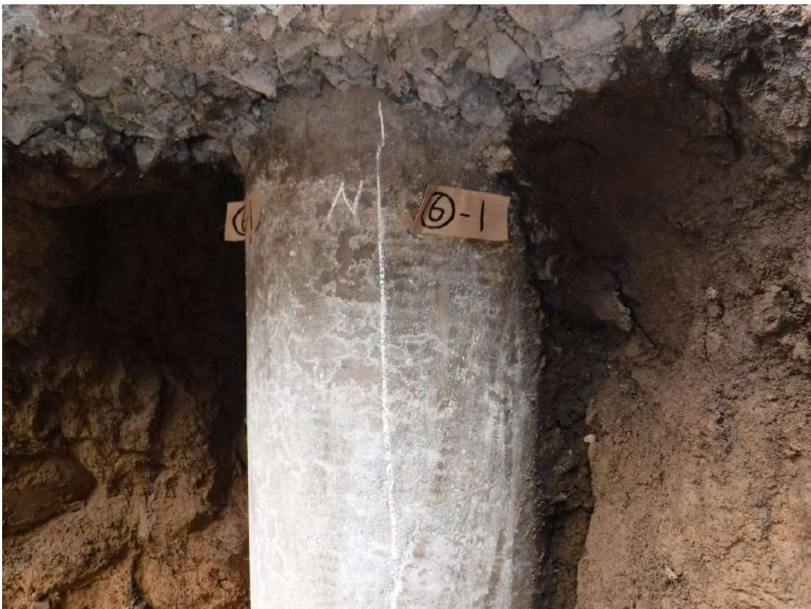
写真 7.4.2.30 杭⑥-1の杭頭部の状況
