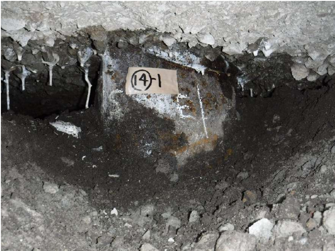
写真 7.4.2.43 杭⑭-1の杭頭部の状況
