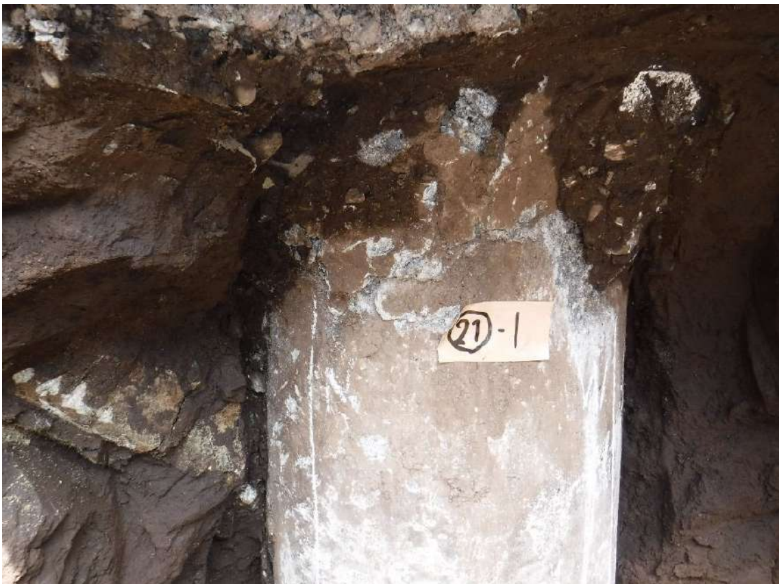
写真 7.4.2.52 杭㉑-1の杭頭部の状況
