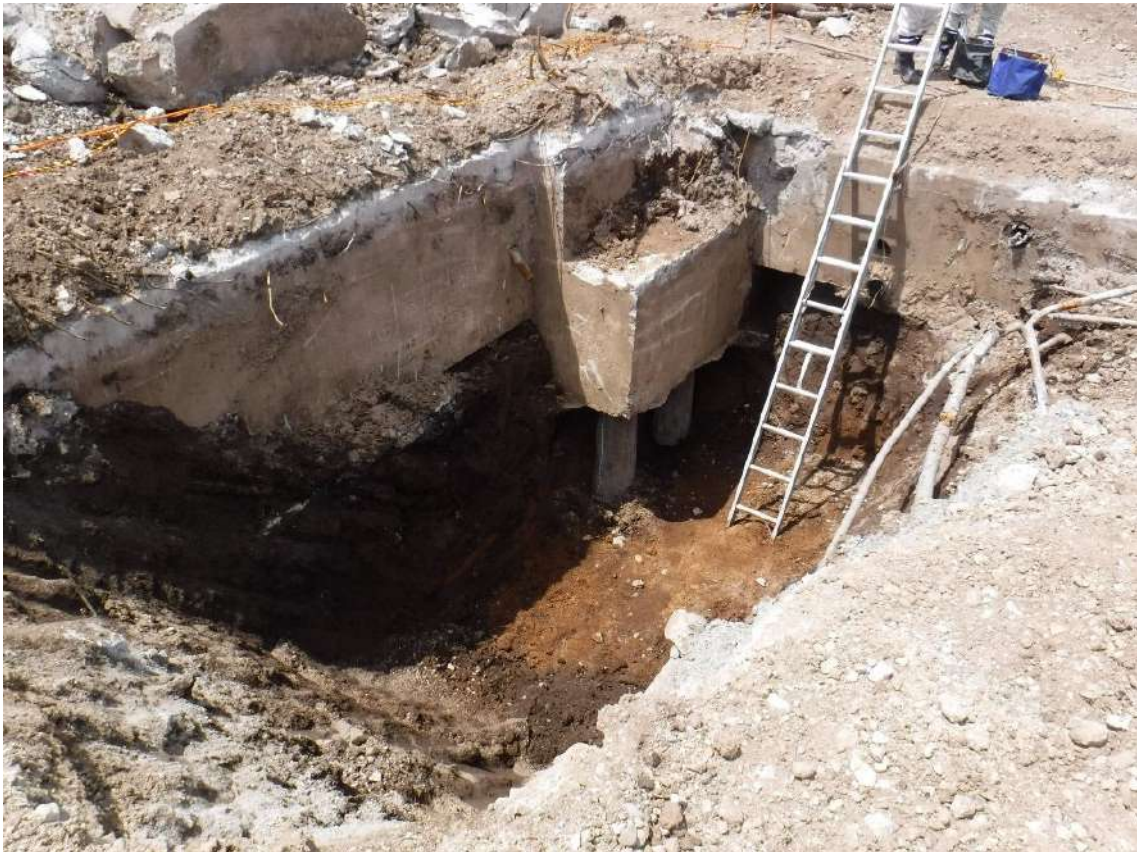
写真 7.4.2.8 基礎フーチング⑥周辺の状況
