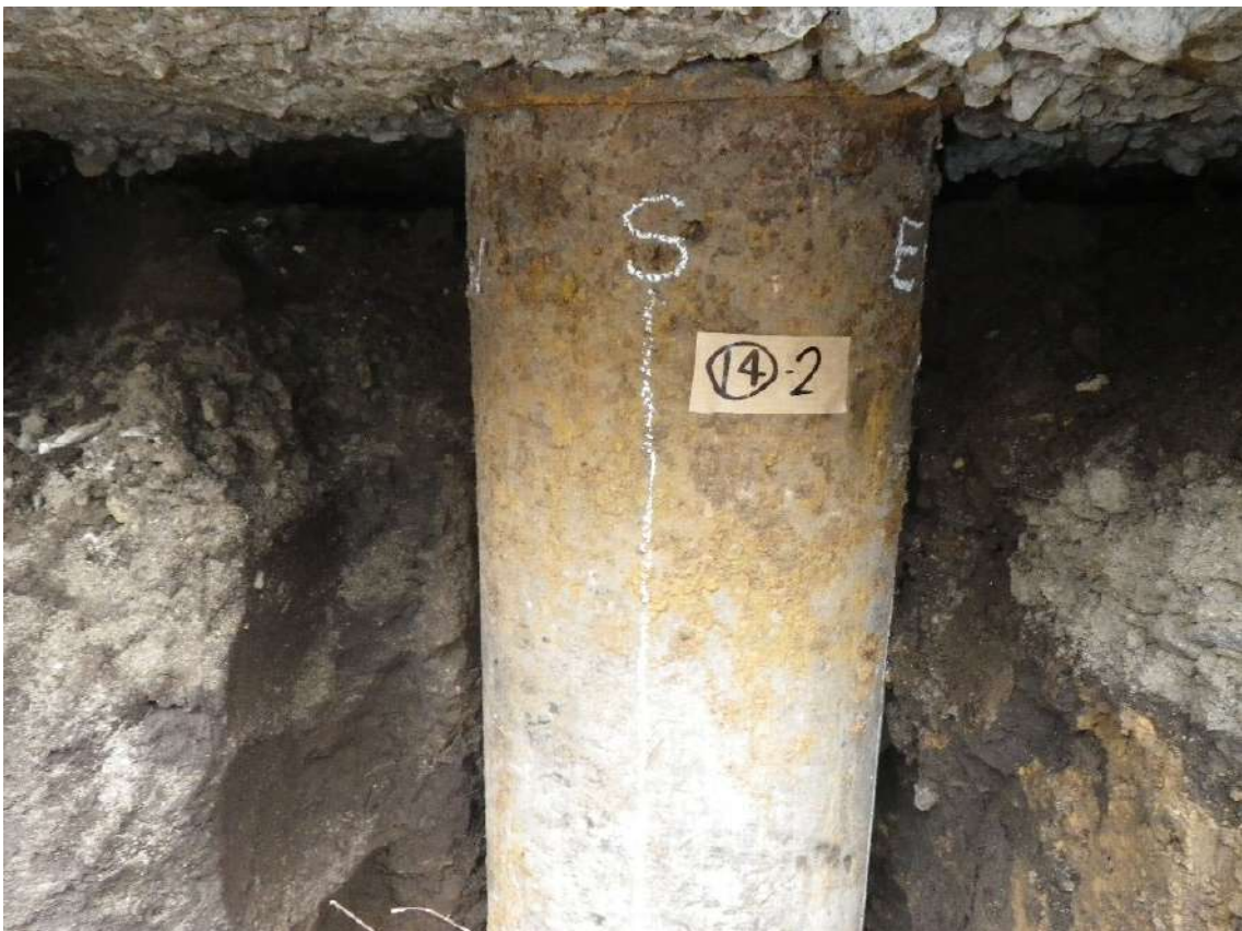
写真 7.4.2.44 杭⑭-2の杭頭部の状況
