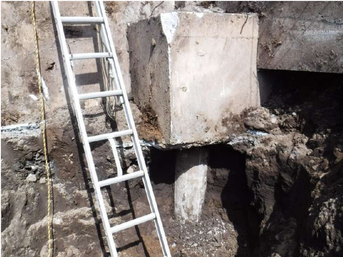
写真 7.4.2.19 基礎フーチング⑮周辺の状況
