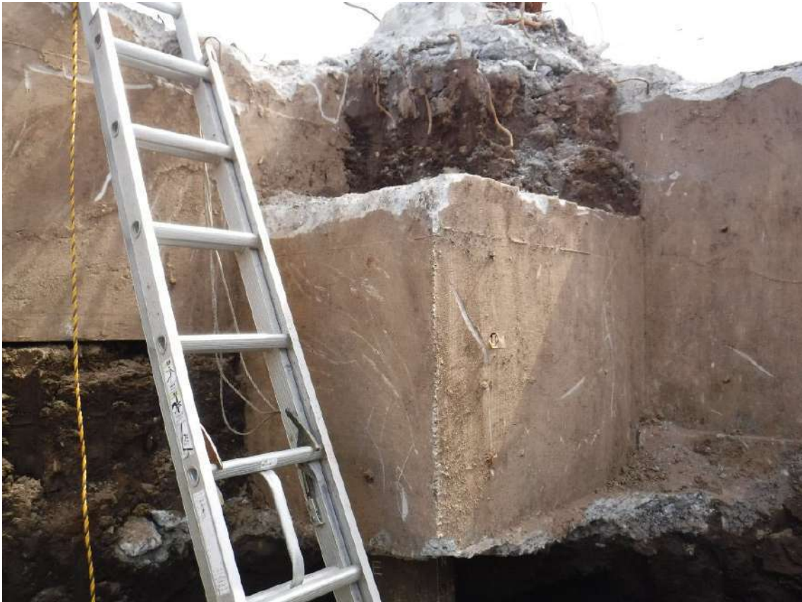
写真 7.4.2.15 基礎フーチング⑪周辺の状況
