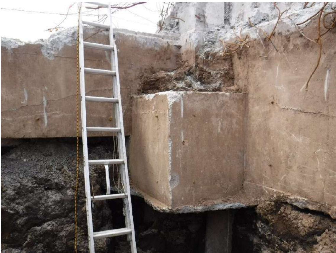
写真 7.4.2.10 基礎フーチング⑦周辺の状況
