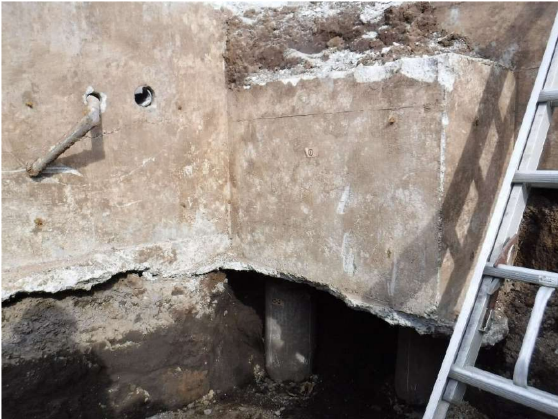
写真 7.4.2.3 基礎フーチング①周辺の状況
