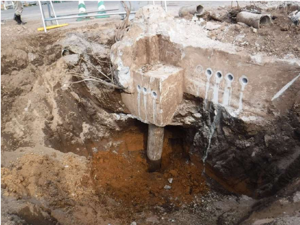
写真 7.4.2.20 基礎フーチング⑯周辺の状況
