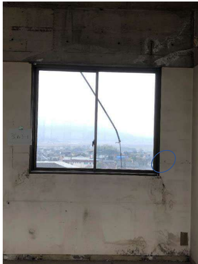
写真 7.4.1.16 3CW3-1 の部材写真
