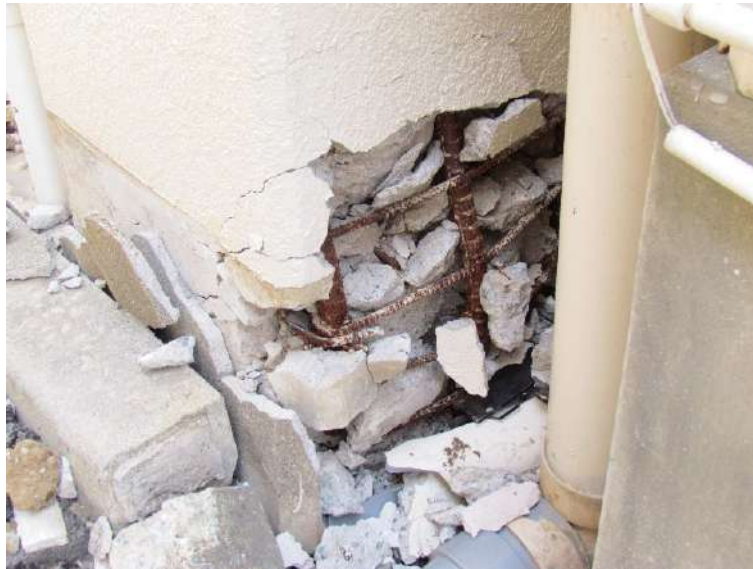
写真 7.4.1.11 渡り廊下棟の柱の柱脚
