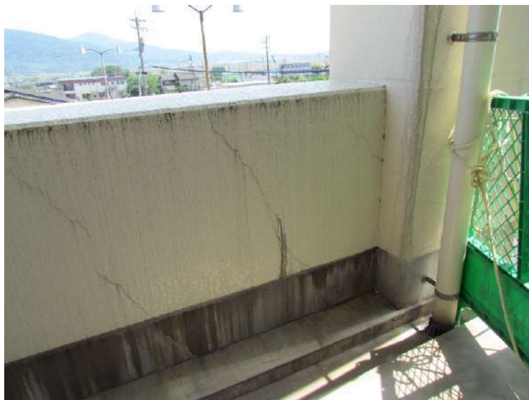
写真 7.4.1.7 損傷度 II の基礎梁
