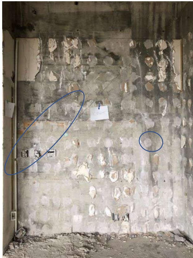
写真 7.4.1.14 1CW2-8 の部材写真
