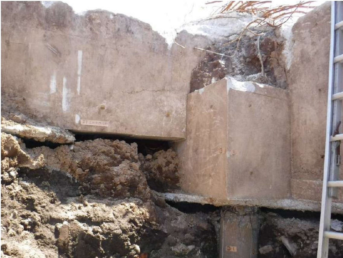
写真 7.4.2.5 基礎フーチング③周辺の状況
