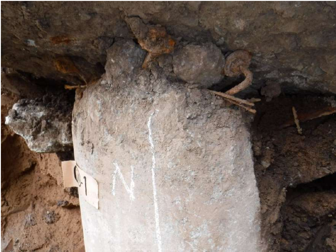
写真 7.4.2.37 杭⑩-1の杭頭部の状況
