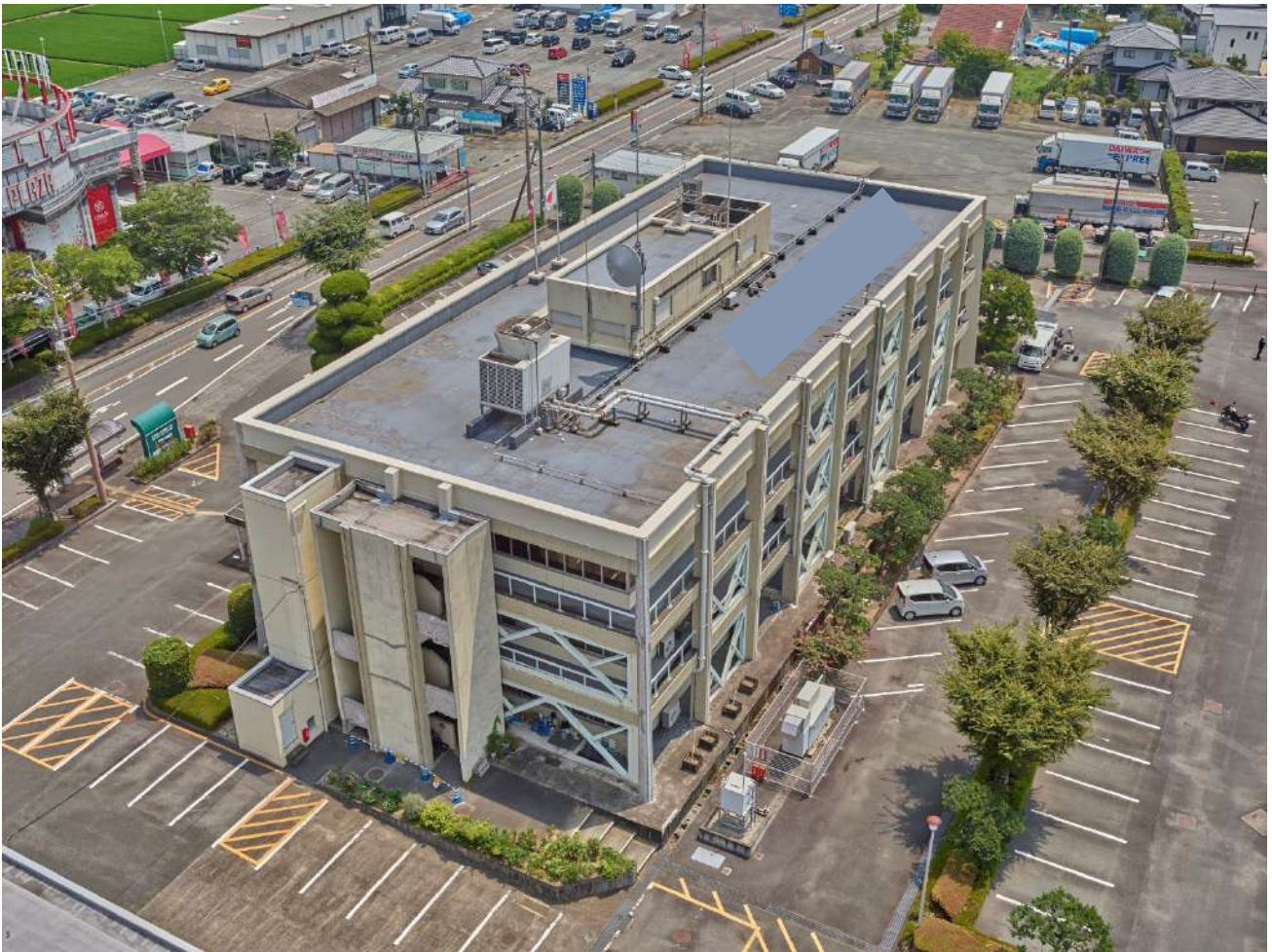
写真 8.4.3.2 ドローンによる建物全景写真
