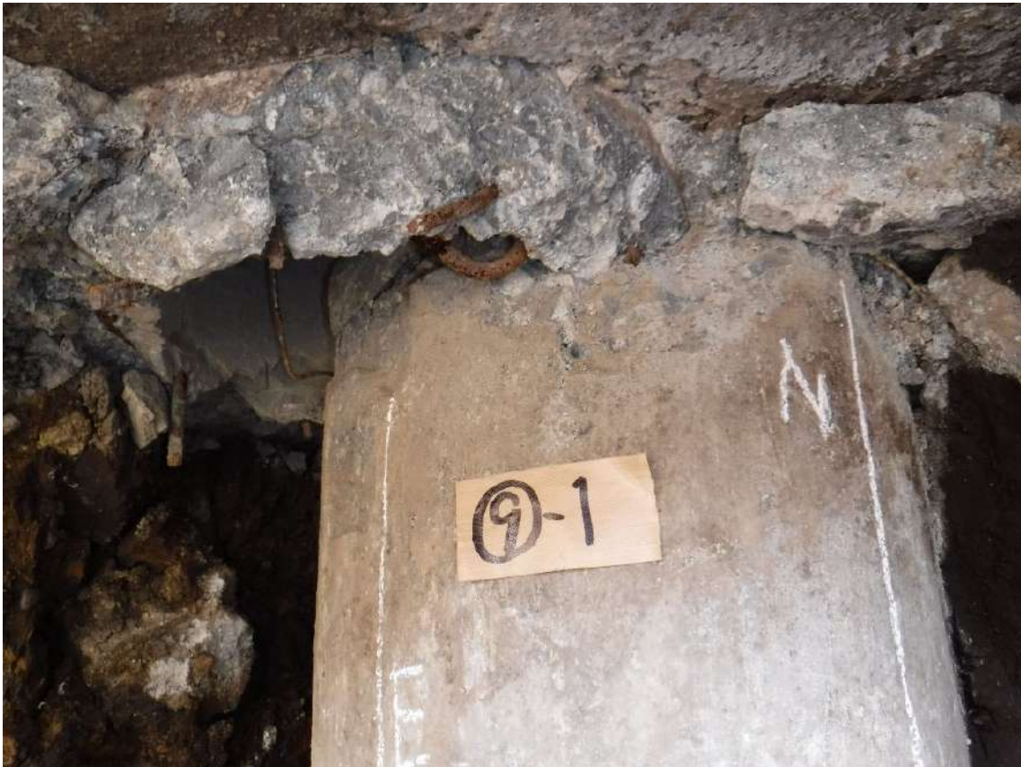
写真 7.4.2.35 杭⑨-1の杭頭部の状況
