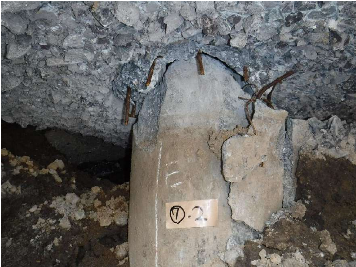
写真 7.4.2.33 杭⑦-2の杭頭部の状況
