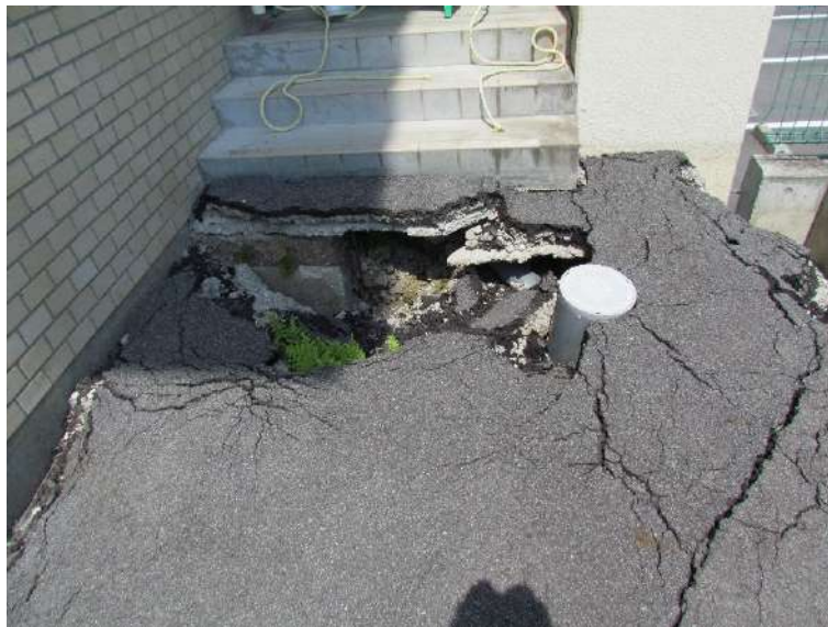
写真 7.4.1.9 外フレーム西側階段
