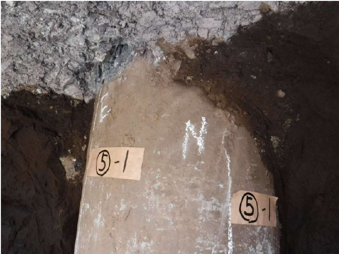
写真 7.4.2.29 杭⑤-1の杭頭部の状況
