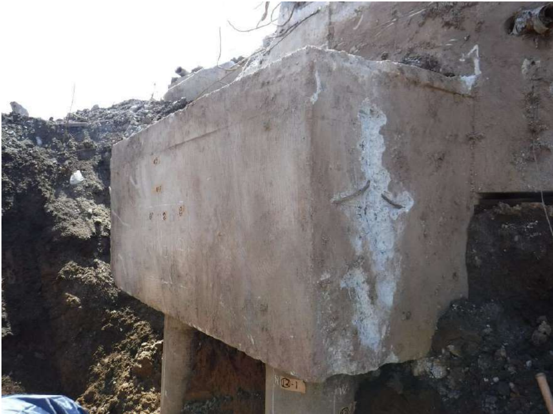
写真 7.4.2.16 基礎フーチング⑫周辺の状況
