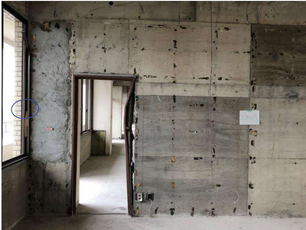
写真 7.4.1.15 2CW1-7 の部材写真
