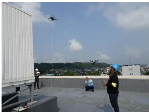
写真 8.4.3.24 ドローンによる計測の様子
