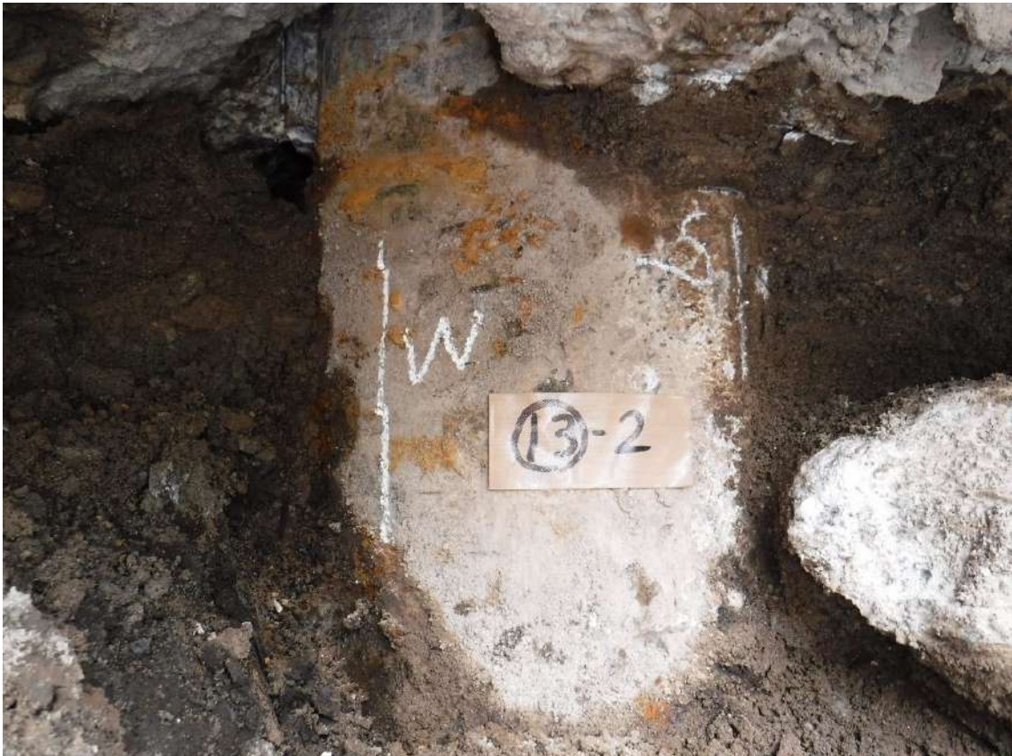
写真 7.4.2.42 杭⑬-2の杭頭部の状況
