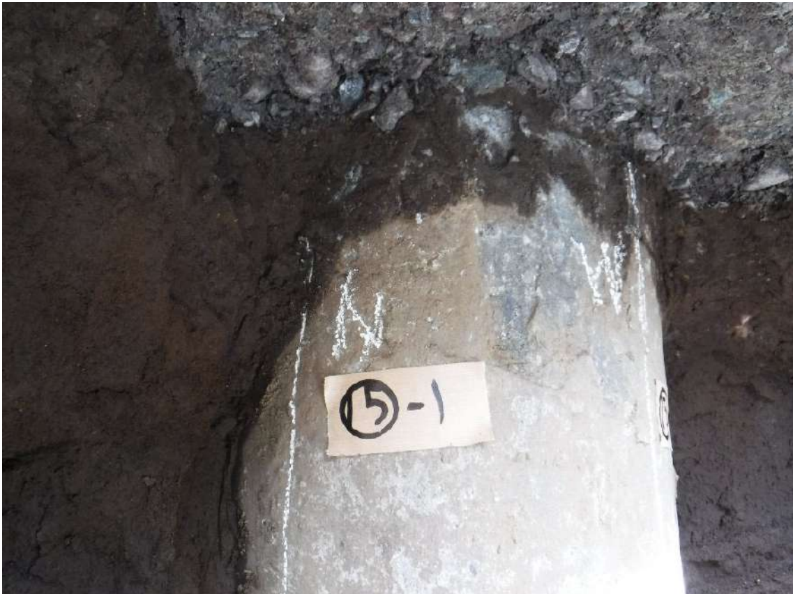
写真 7.4.2.45 杭⑮-1の杭頭部の状況
