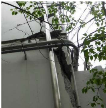
写真 9.3.5 北東側2階柱脚部
