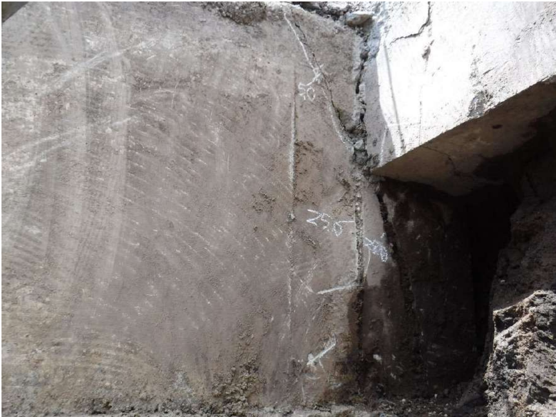
写真 7.4.2.9 基礎フーチング⑥周辺の状況
