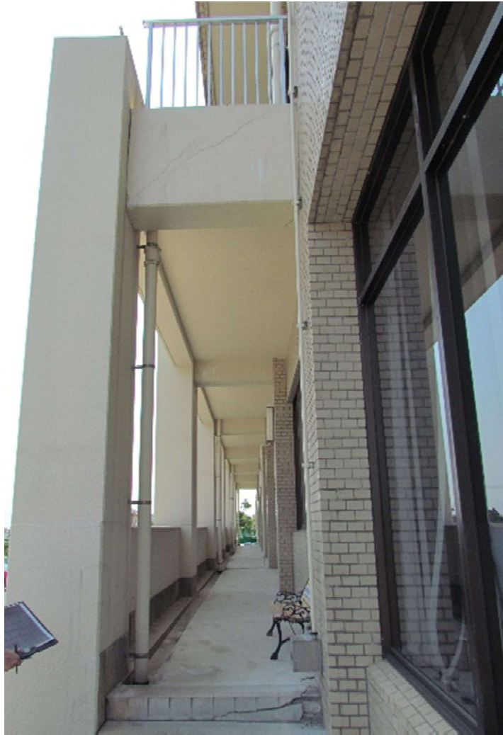
写真 7.4.1.3 外フレームと既存部の境界梁
