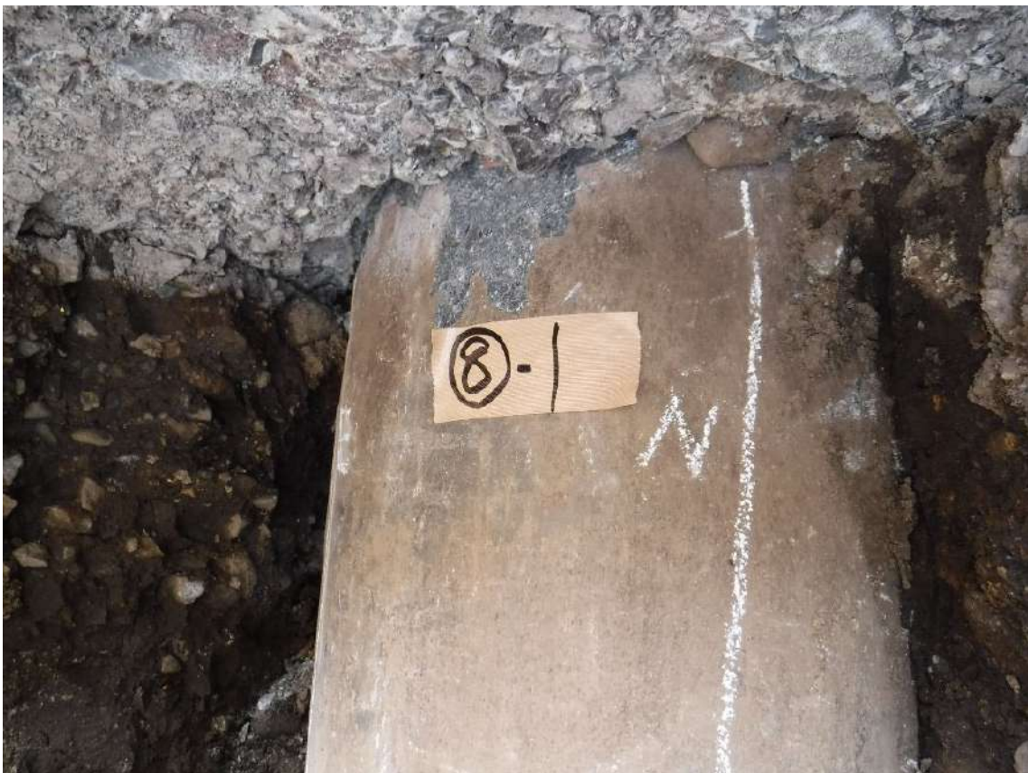
写真 7.4.2.34 杭⑧-1の杭頭部の状況
