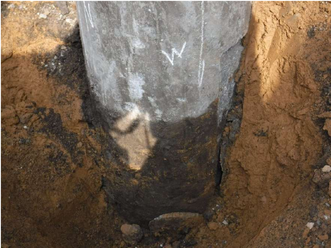
写真 7.4.2.47 杭⑩-1の杭頭部の状況
