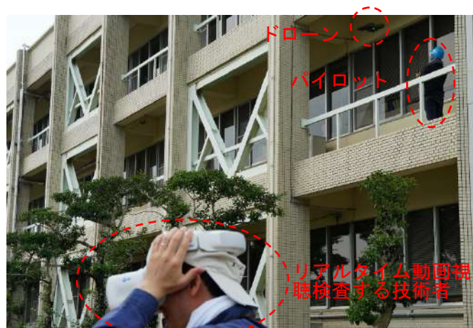
写真 8.4.3.28 FPV 撮影とリアルタイム動画視聴検査の様子
