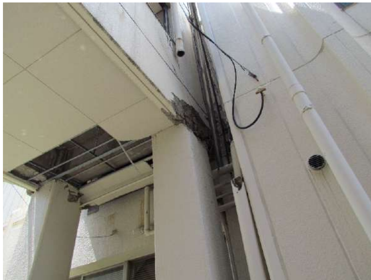
写真 7.4.1.12 渡り廊下棟の柱
