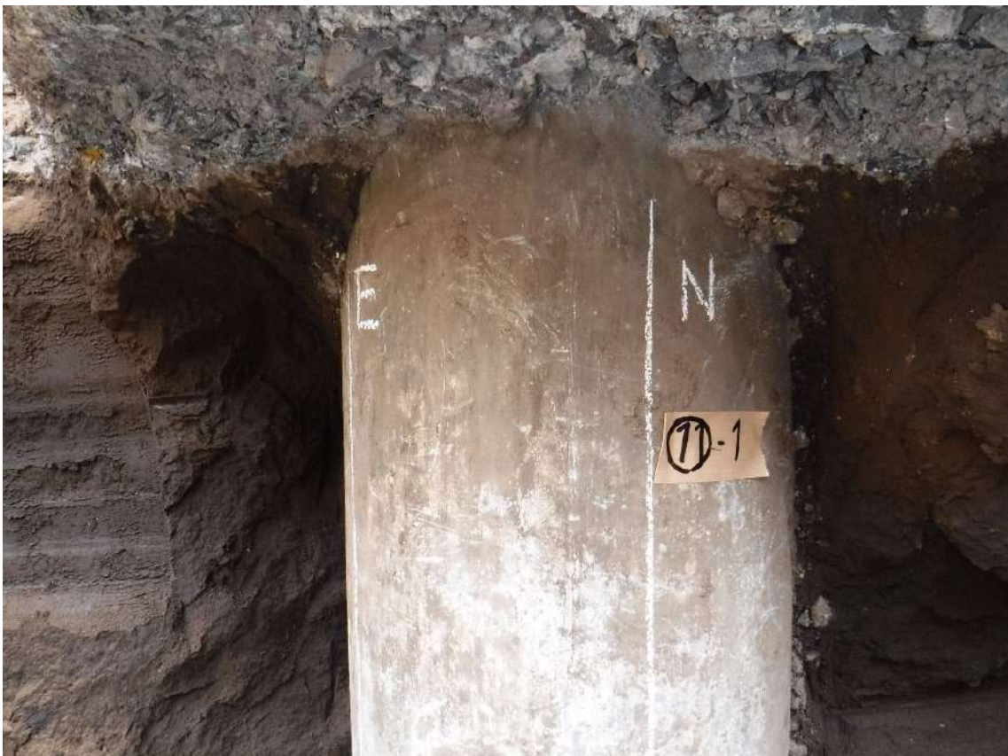
写真 7.4.2.38 杭⑪-1の杭頭部の状況
