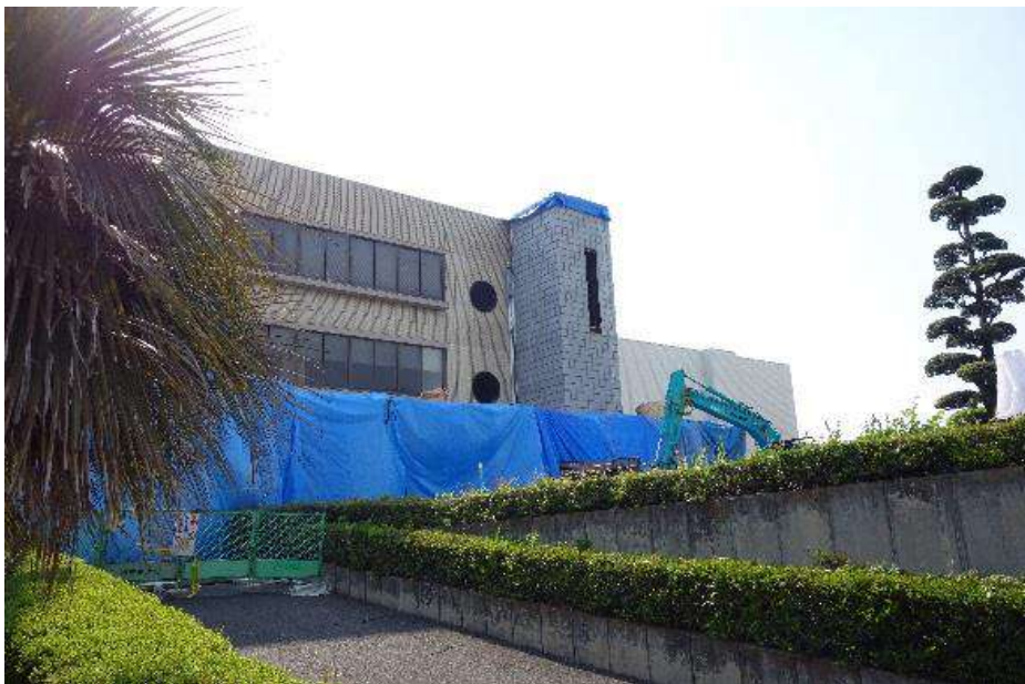
写真7.3.2.2 建築物北東のエレベータ棟と鉄骨造の庇
