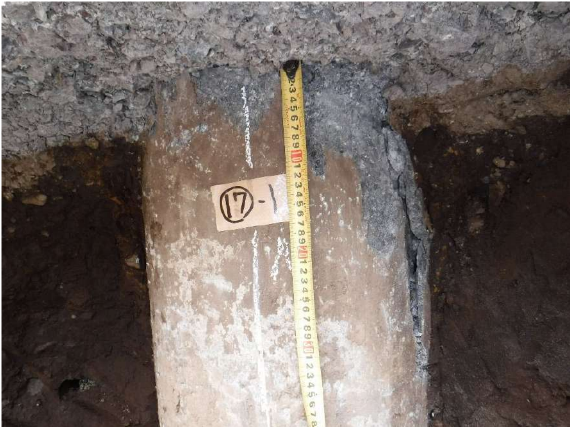
写真 7.4.2.48 杭⑰-1の杭頭部の状況
