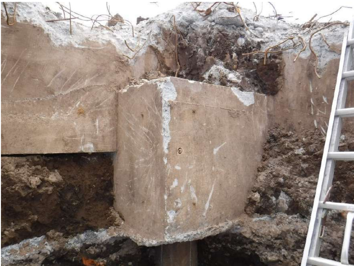
写真 7.4.2.12 基礎フーチング⑧周辺の状況
