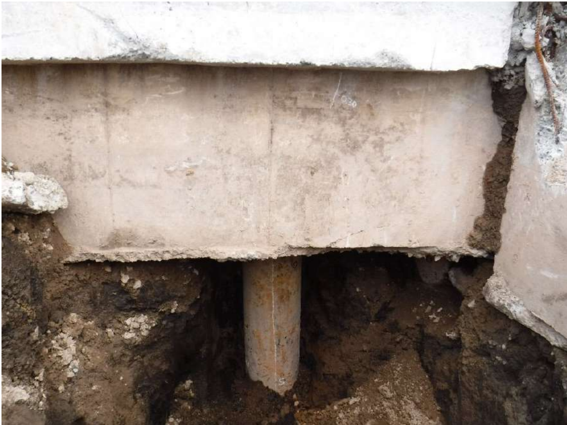
写真 7.4.2.17 基礎フーチング⑬周辺の状況
