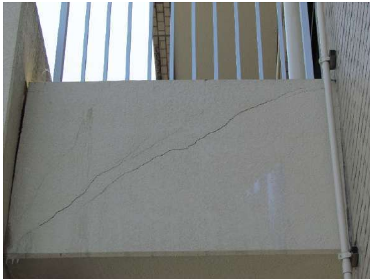
写真 7.4.1.4 境界梁の拡大写真
