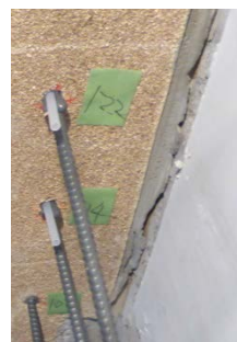
写真 5.2.2.5-2 位置固定・脱落防止（くさび）
