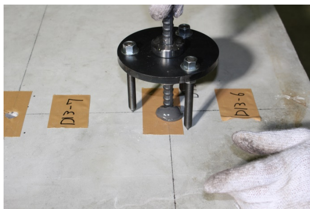
解図2 アンカー打設用治具の例
