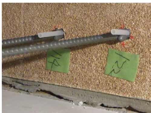
写真 5.2.3.4-2 くさびによる脱落防止(天井, No. 122) 写真 5.2.3.4-3 壁際で不陸あり(天井, No. 130)
