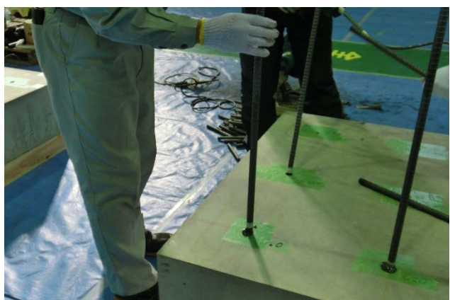
図 5.3.2.15 アンカー筋の挿入状況
