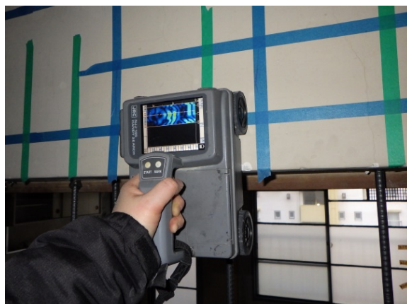
写真 5.5.3.5 梁側面探査状況
