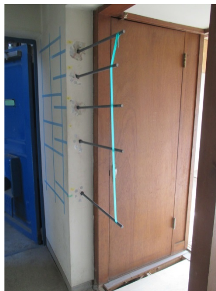
写真 5.5.3.2 施工状況(302号室壁・横向き)
