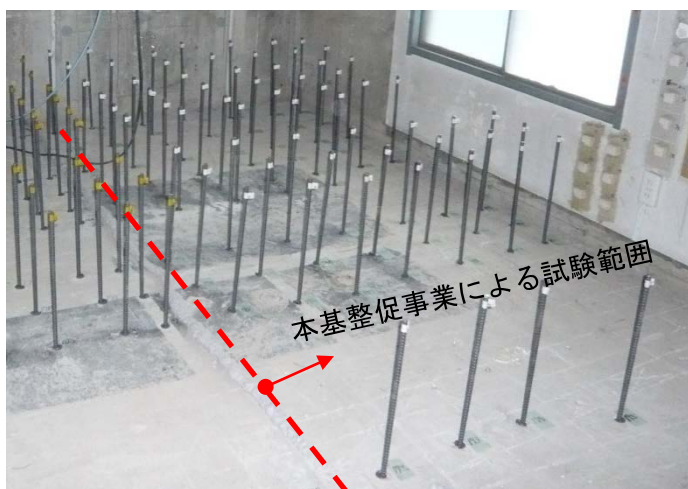
写真 5. 2. 3. 1-3 床に施工したアンカー筋
