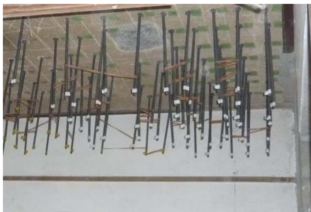
写真 5. 2. 3. 1-2 天井に施工したアンカー筋
