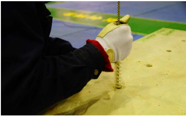
図 5.3.2.10 孔内の清掃状況
