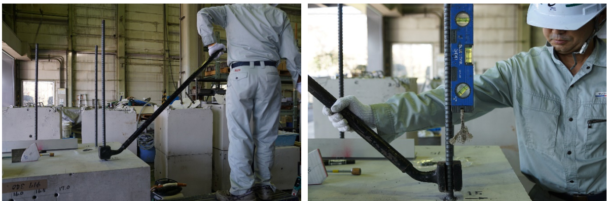
図 5.3.2.19 アンカー筋の台直しの作業状況
