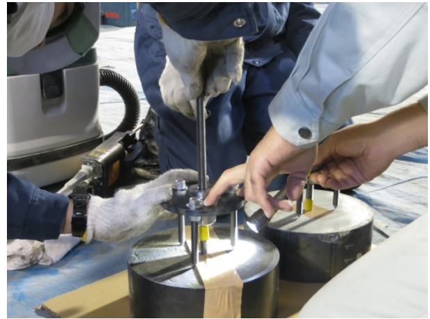
写真 2.2.2.1-4 アンカー筋の固着状況
