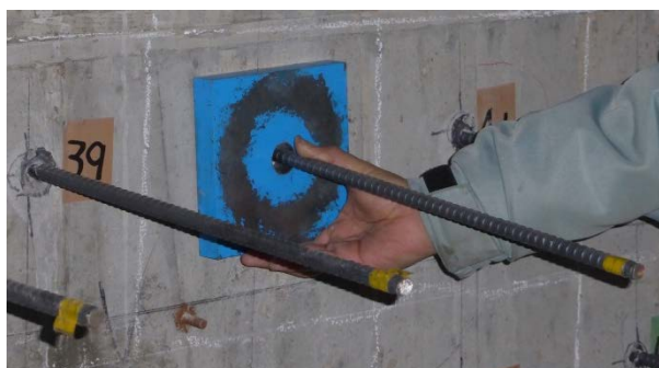
写真 5.2.2.3-1 支圧板の設置
