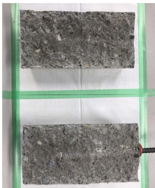
写真 5.5.2.4 接着材充填状況(正規施工)
