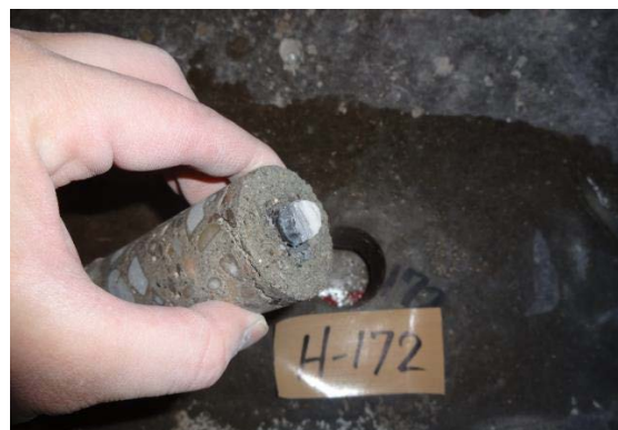
写真 5. 2. 2. 3-4 アンカー筋部分のコア採取
