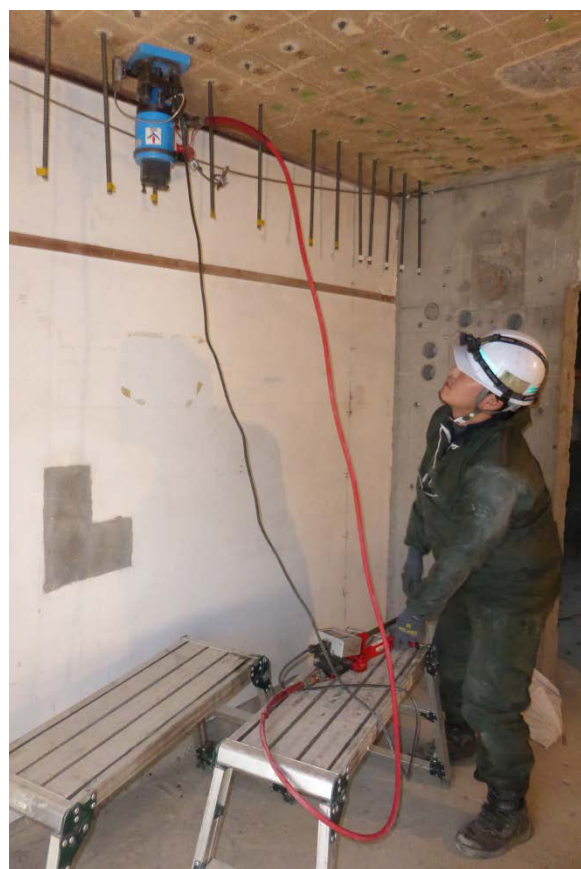
写真 5.2.2.3-2 上向き施工のアンカー筋への試験
