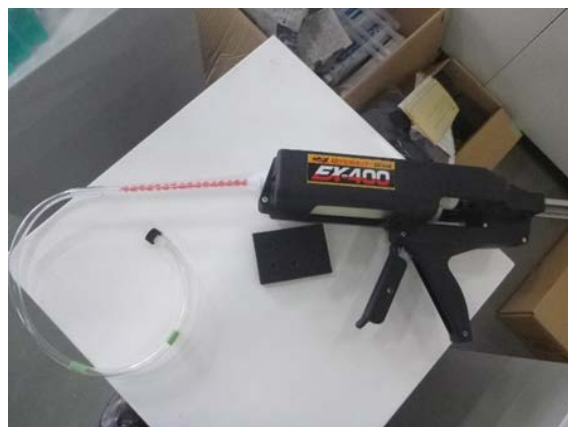
(f) 注入ガンにカートリッジ装填
