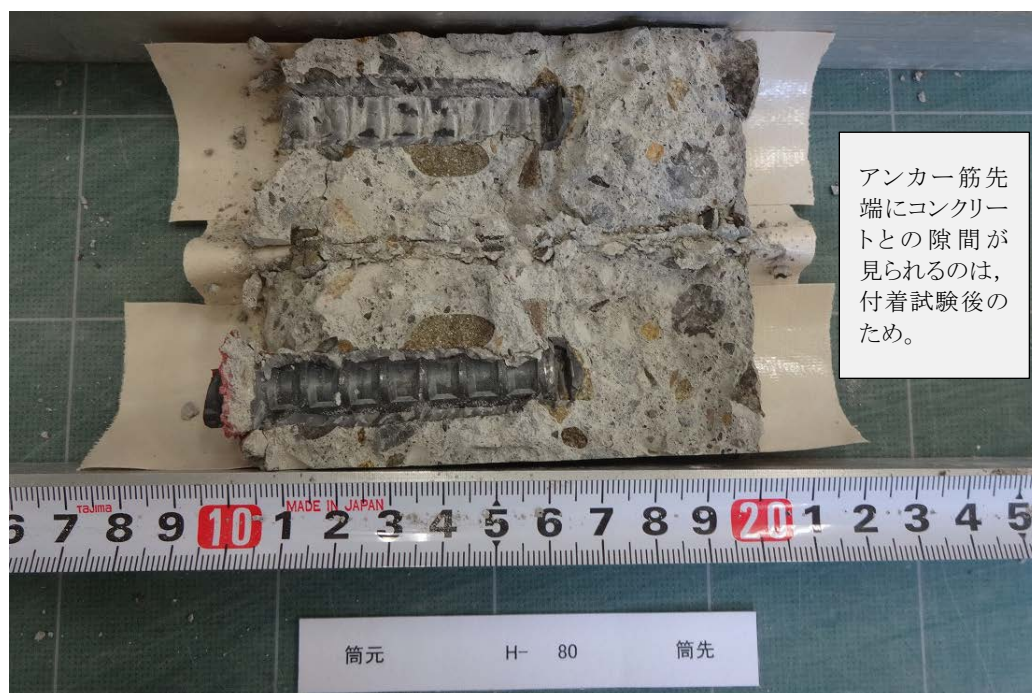
写真 5.2.3.5-1 接着剤の充填状況の確認例(天井, No. 80)
