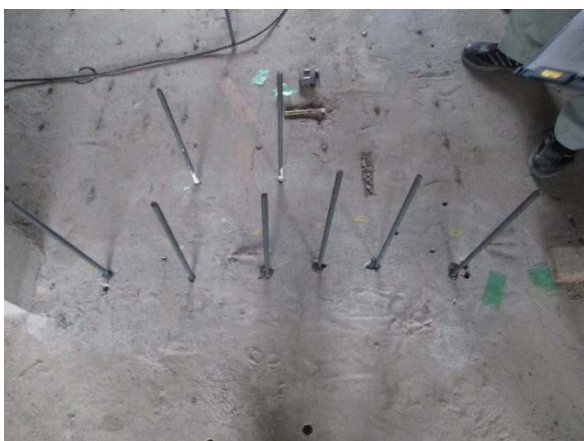
写真 5.5.3.3 施工状況(202号室壁梁・下向き)
