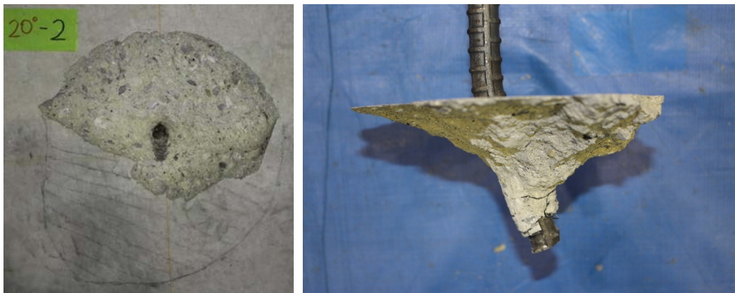
(e) 傾斜角 20° のコーン状破壊形状
