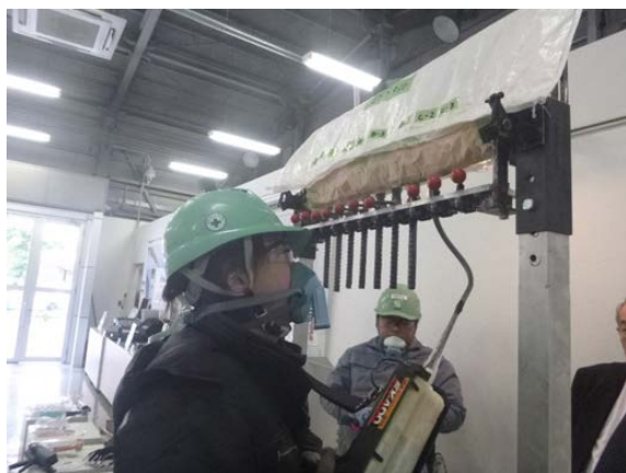
(a) 表面の注入状況
