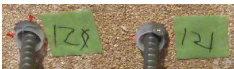
写真 5.2.3.5-2 天井施工において使用した接着剤の垂れ対策のプラスチック製キャップ
