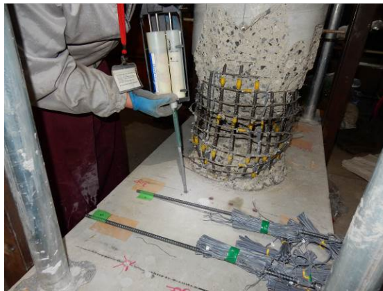
(a) 樹脂注入
