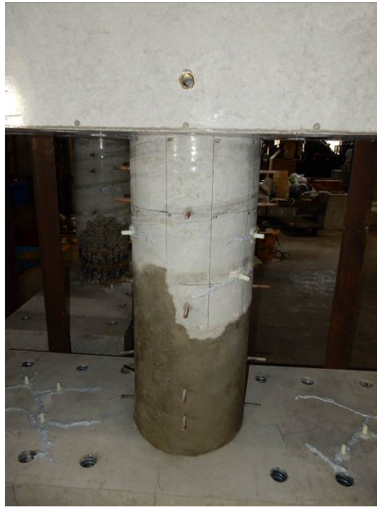
写真 4. 2. 3 モルタルによる補修状況
