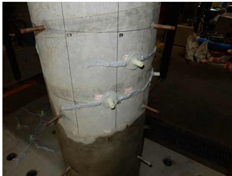
写真 4. 2. 4 ひび割れ部へのエポキシ樹脂注入
