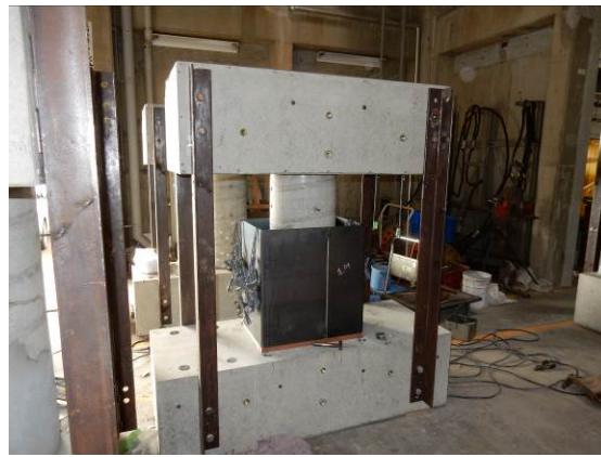
(a) 鋼板設置
