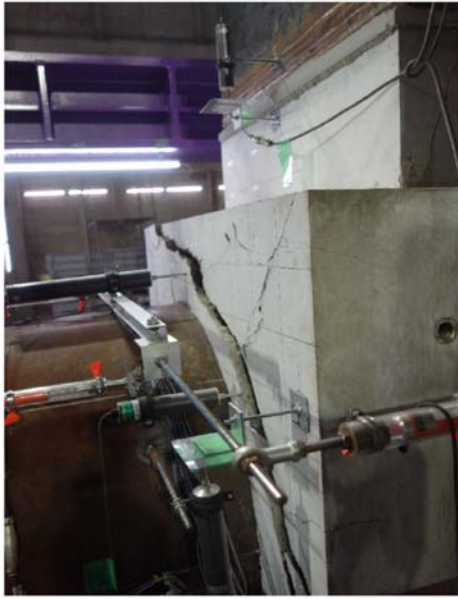
(試験体 No. 1 変位計設置部の浮き)
